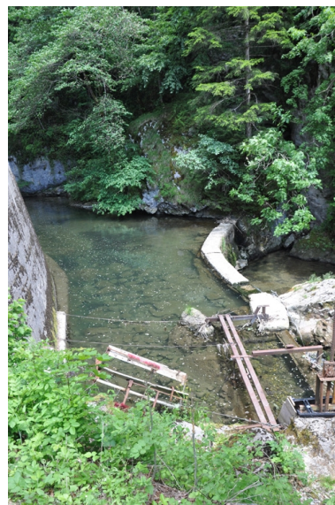
Vue de la prise d'eau et du barrage sur le ruisseau du Cozon Phot. Yannick Milleret IVR82_20107300586NUCA
