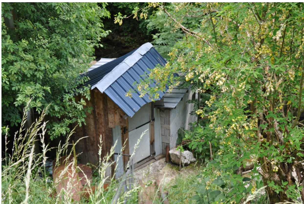
Vue générale de la microcentrale hydroélectrique du Pont-du-Lac
