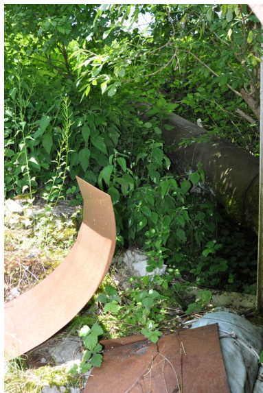
Détail de la conduite forcée Phot. Yannick Milleret IVR82_20107300587NUCA
