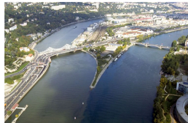
Vue aérienne depuis le sud Phot. François Guy IVR82_20036900339NUCA
