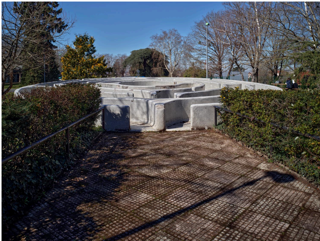
Vue depuis le niveau du sol
