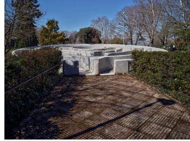
Vue depuis le niveau du sol
