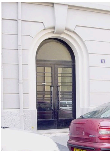
Porte d'entrée Phot. Anaïs Beccaria IVR82_20046903517NUCA
