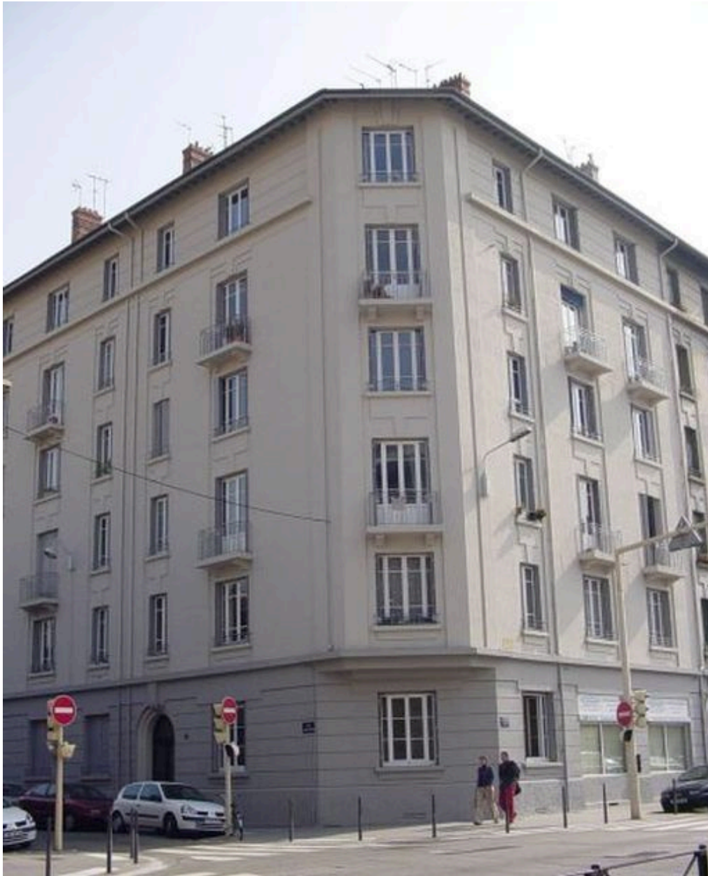
Vue générale de l'élévation
