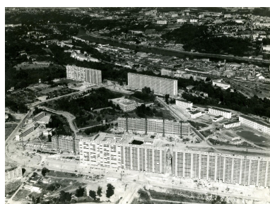
Vue du chantier de construction du Plateau, 1962 (archives de l'Avenir) Phot. Nadine Halitim-Dubois IVR82_20036901987NUC
