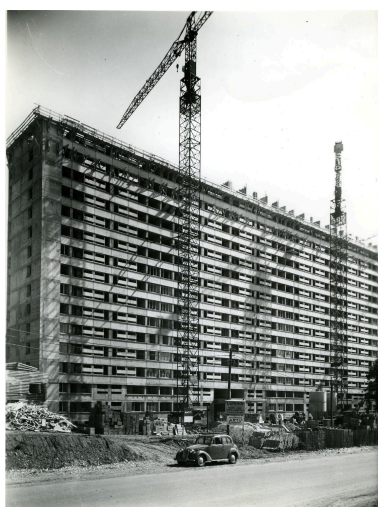
Construction de la barrière de la SACVL à Balmont, 1962 (archives de l'Avenir) Phot. Nadine Halitim-Dubois IVR82_20036901988NUC
