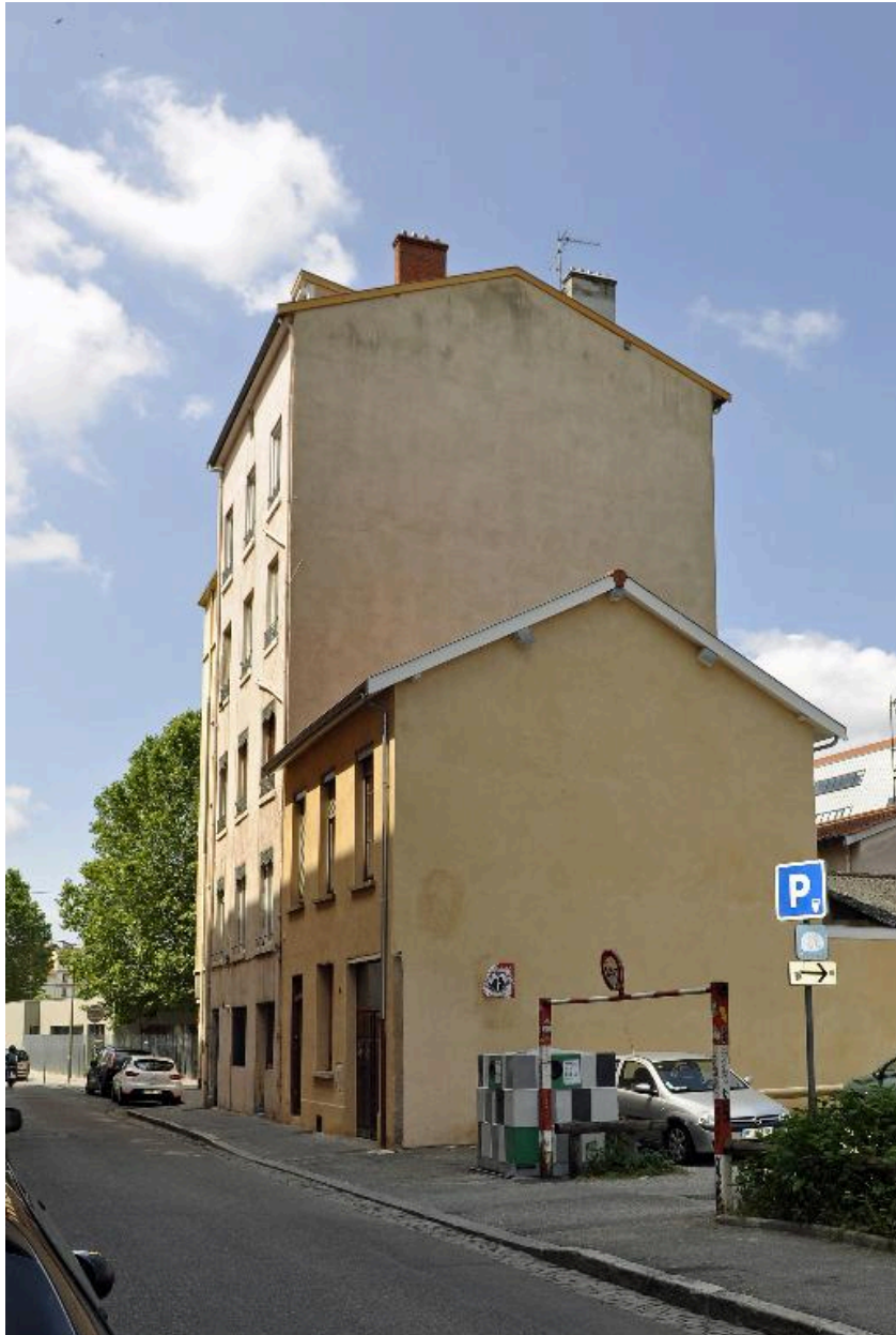
Vue de l'élévation latérale nord
