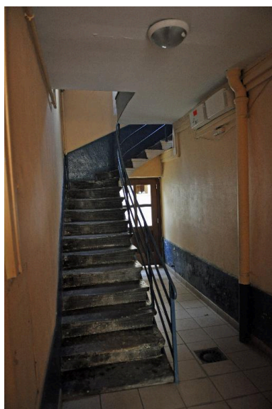
Vue intérieure : le départ de l'escalier, première révolution en équerre
