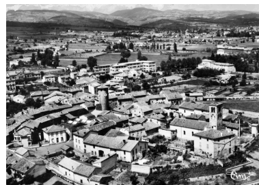
Vue aérienne du bourg de Moingt. [vue d'ensemble du presbytère au niveau du chevet]
