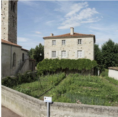
Vue générale Phot. Didier Gourbin IVR82_20074201101NUCA
