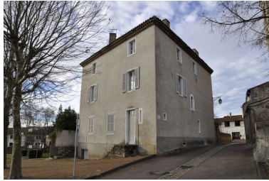
Vue d'ensemble arrière. Phot. Thierry Monnet IVR82_20134203482NUCA
