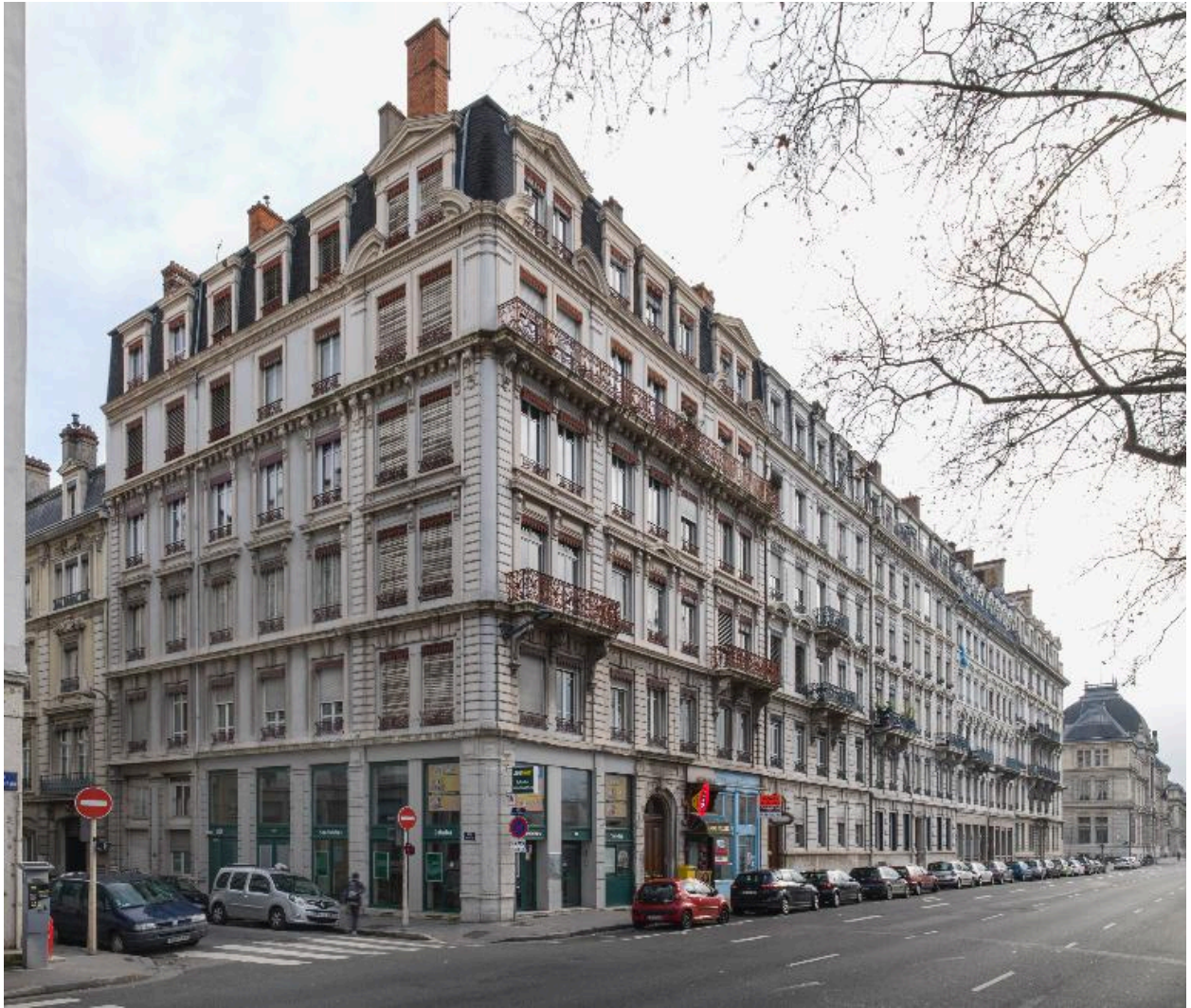
Vue d'ensemble de l'îlot
