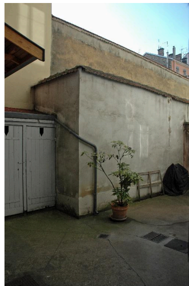
Vue partielle de la cour Phot. Magali Delavenne IVR82_20146902799NUCA
