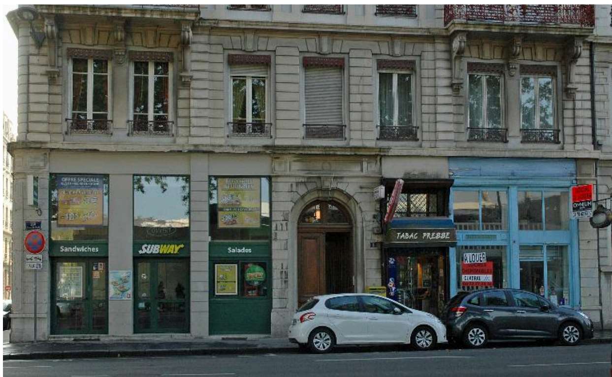
Elévation sur quai : vue rapprochée du rez-de-chaussée
