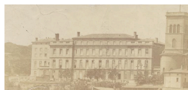
Vue de situation depuis le nord-est. Tirage photographique, sd Phot. Lyon Musées Gadagne IVR82_20156901810NUCB
