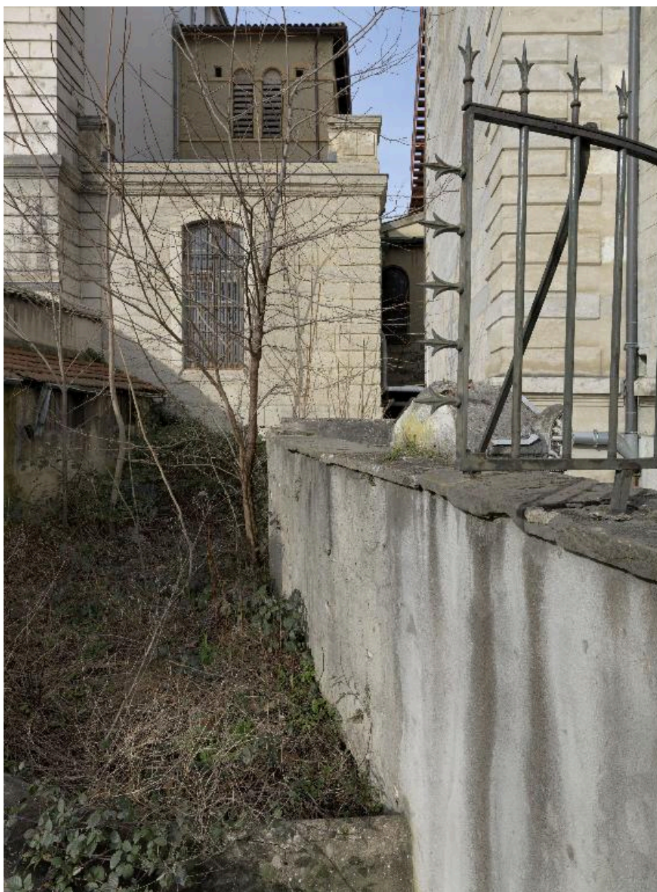
Vue partielle depuis le jardin de l'ancien prieuré des Génovéfains
