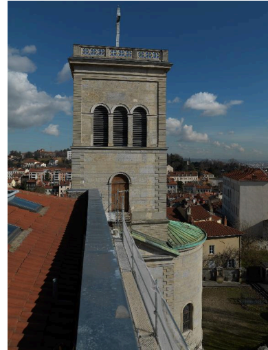
Elévation est du clocher et chevet depuis l'ancien prieuré des Génovéfains Phot. Thierry Leroy IVR82_20156901864NUCAQ
