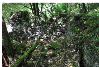
Vestiges du moulin Pachoud amont Phot. Yannick Milleret IVR82_20127301736NUCA
