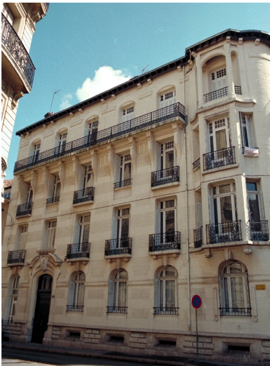
Façade principale, rue de l'Alma
