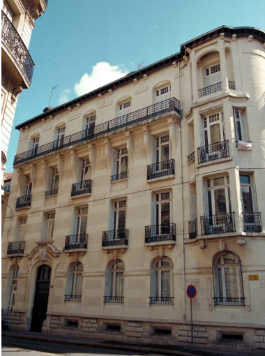
Façade principale, rue de l'Alma
