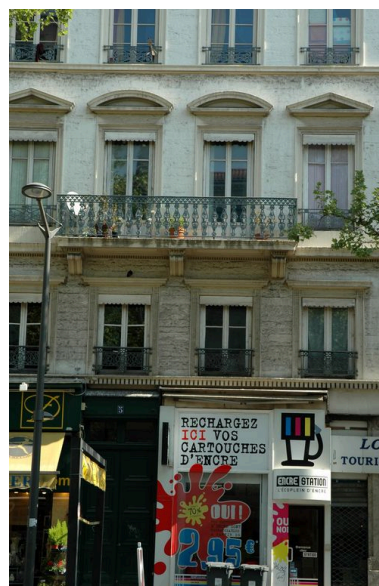
Rez-de-chaussée et travées centrales Phot. Maryannick Chalabi IVR82_20096901283NUCA
