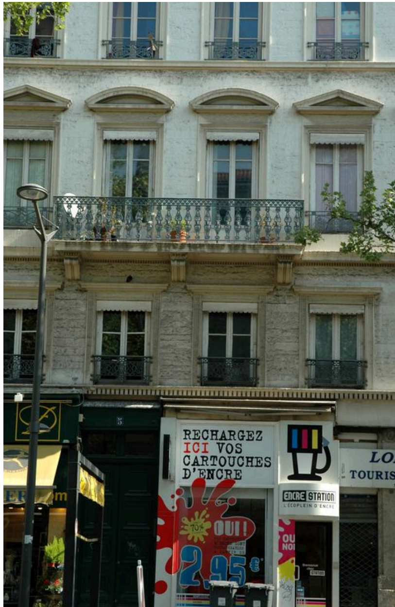
Rez-de-chaussée et travées centrales
