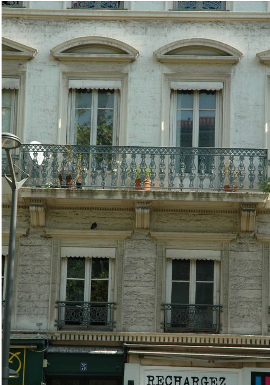
Détail de deux travées de fenêtres
