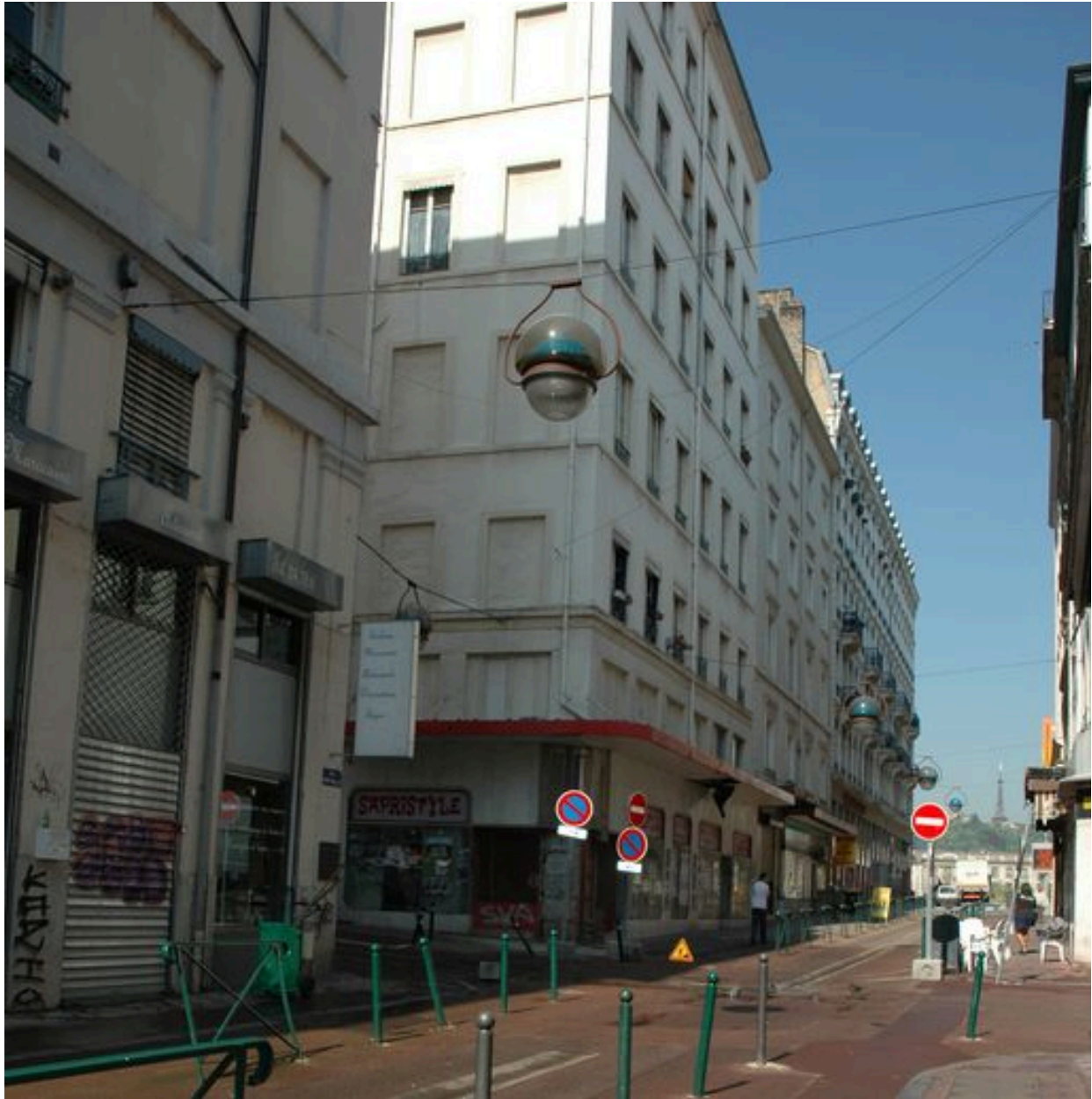
Vue d'ensemble depuis l'est, angle de la rue Montebello
