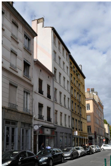
Vue générale, élévation sur rue Phot. Magali Delavenne IVR84_20176901521NUCA
