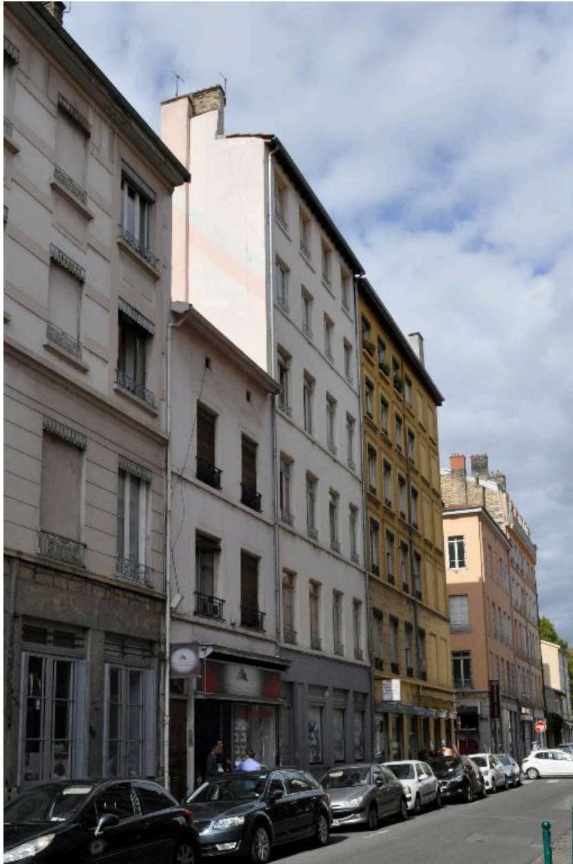
Vue générale, élévation sur rue
