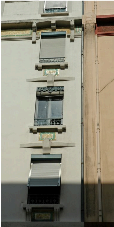
Détail d'une travée de fenêtres Phot. Maryannick Chalabi IVR82_20076900314NUCA
