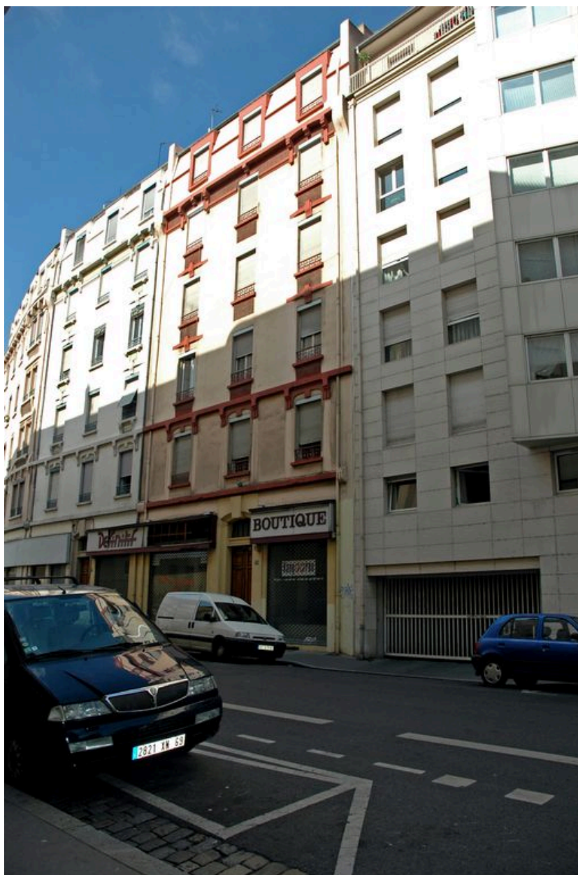
Vue d'ensemble des 270-272 depuis le nord-est
