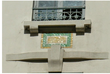
Détail du décor de céramique en façade Phot. Maryannick Chalabi IVR82_20076900315NUCA
