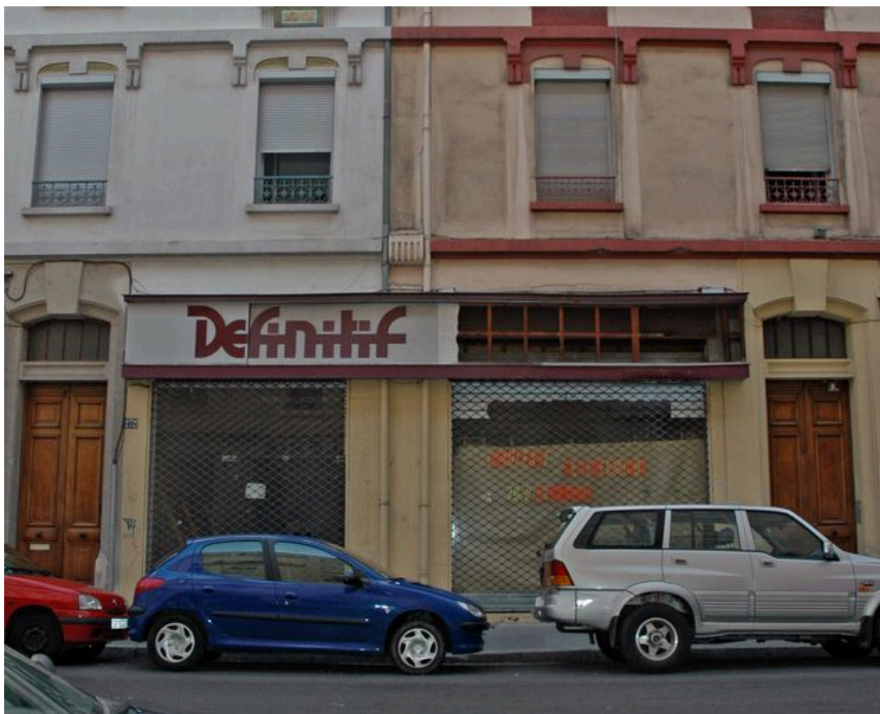
Rez-de-chaussée sur rue des 270-272
