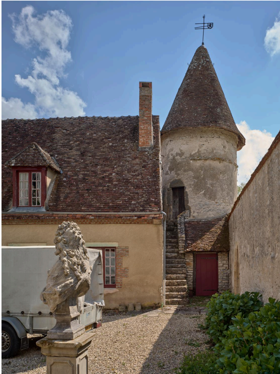
Tour sud, vue de l'ouest.
