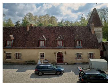
Bâtiment principal vu de l'ouest. Phot. Christian Parisey IVR84_20240300269NUC4A
