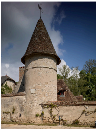
Vue générale de la tour au sud Phot. Christian Parisey IVR84_20240300271NUC4A
