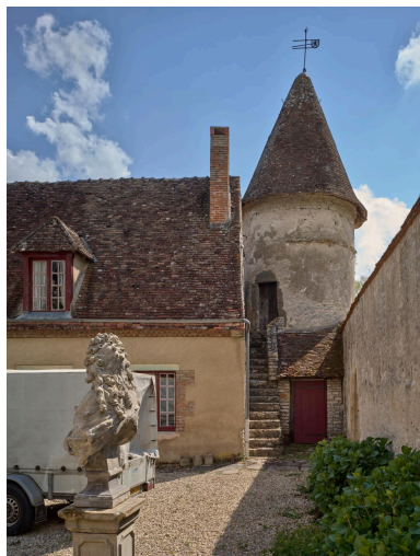
Tour sud, vue de l'ouest. Phot. Christian Parisey IVR84_20240300270NUC4A
