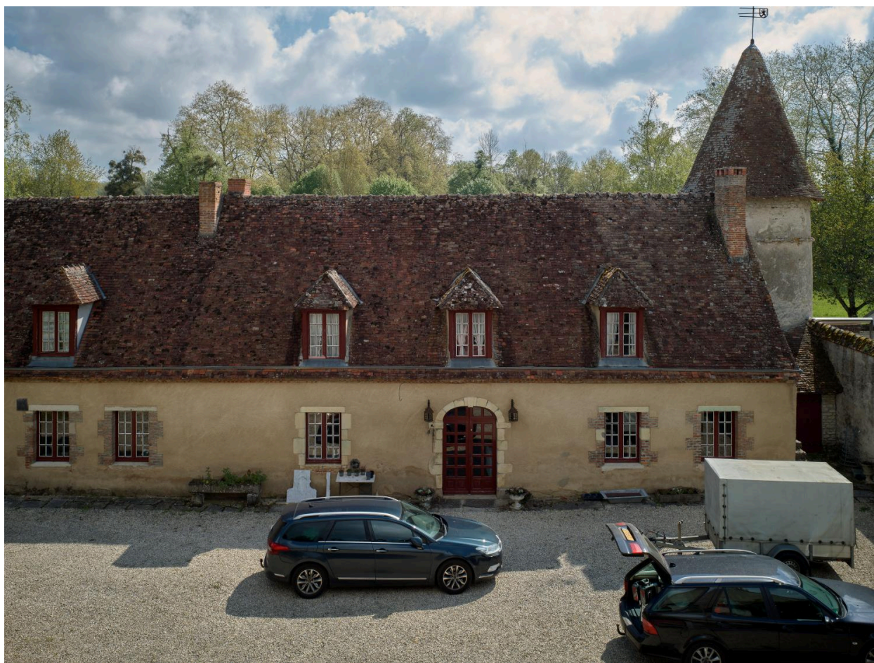
Bâtiment principal vu de l'ouest.
