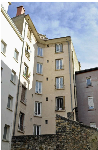
Vue des élévations postérieures Phot. Catherine Guégan IVR84_20176901005NUCA
