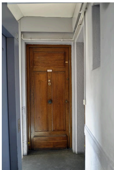
Vue intérieure : une porte palière Phot. Catherine Guégan IVR84_20176900974NUCA
