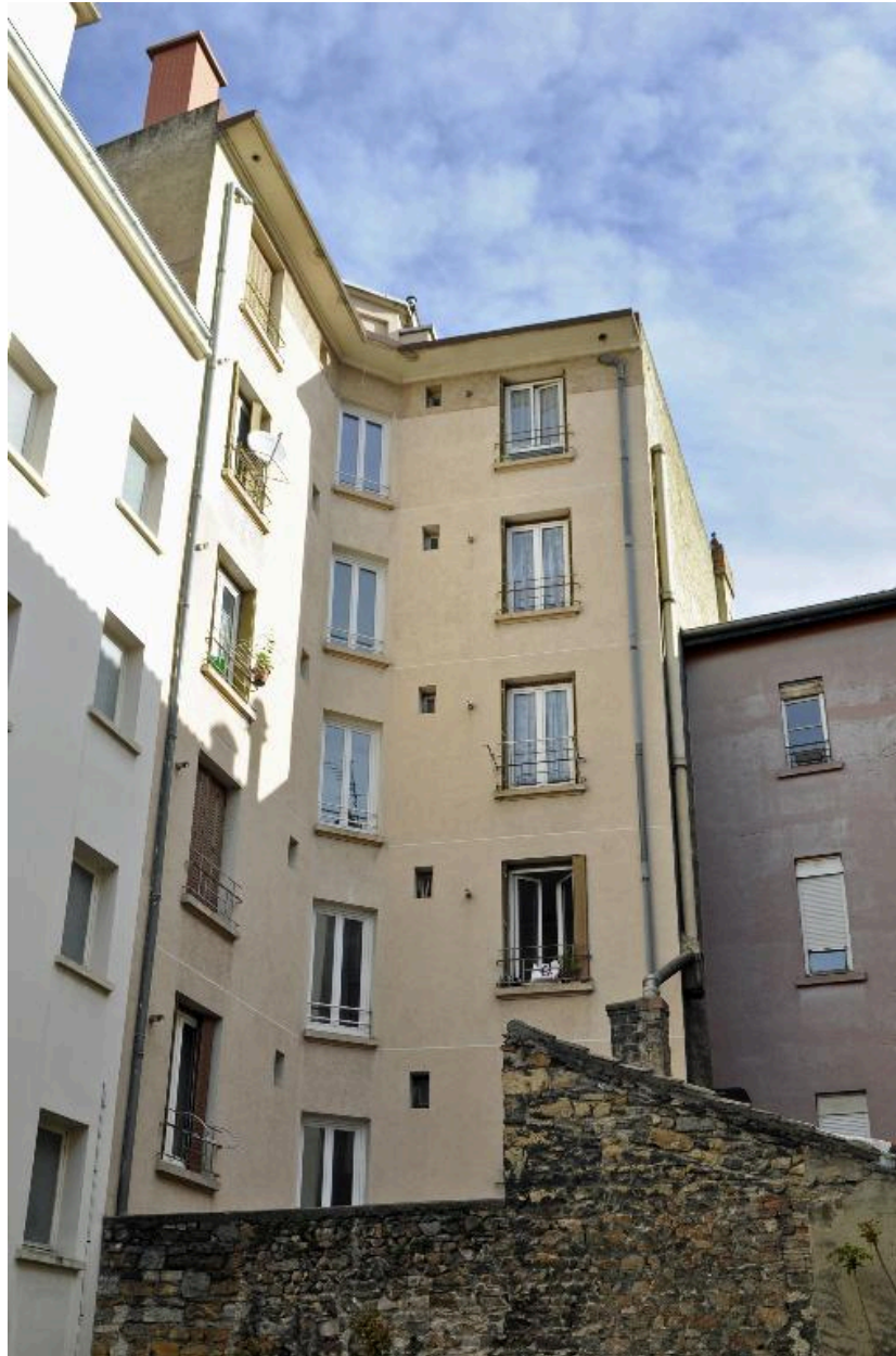
Vue des élévations postérieures
