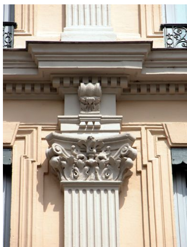
Façade sur le quai, partie centrale, 4e niveau, chapiteau de l'ordre colossal Phot. Phot. Inv. D. Chevallier IVR82_20046900564NUCA
