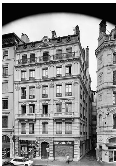
Façade sur le quai, vue générale Phot. Didier Gourbin IVR82_20046900831P
