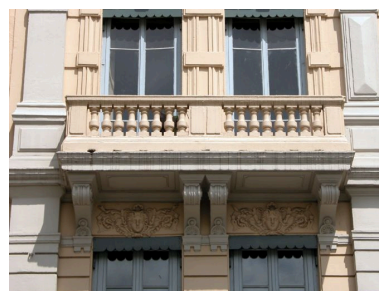
Façade sur le quai, 3e niveau, balcon de gauche Phot. Phot. Inv. D. Chevallier IVR82_20046900563NUCA
