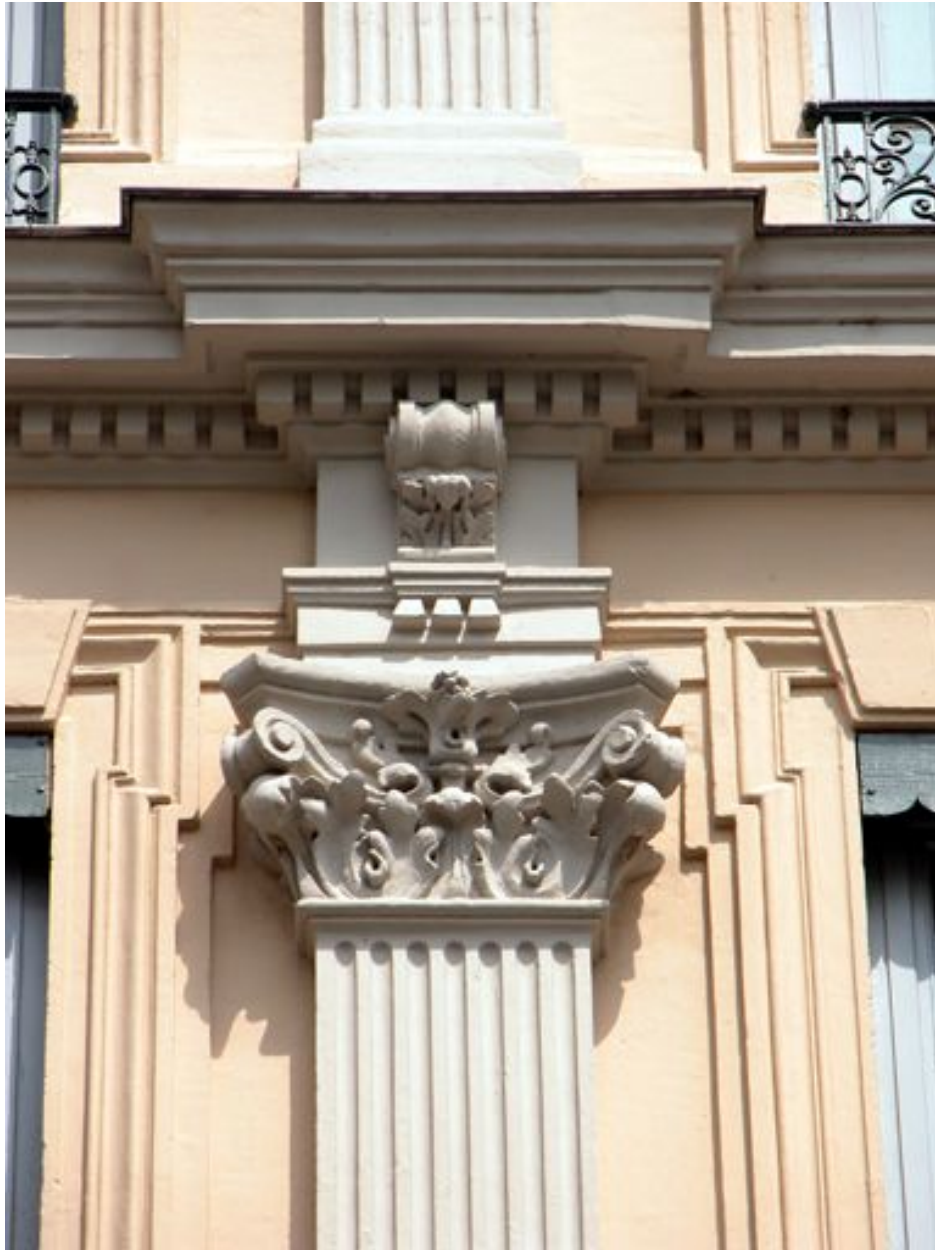
Façade sur le quai, partie centrale, 4e niveau, chapiteau de l'ordre colossal
