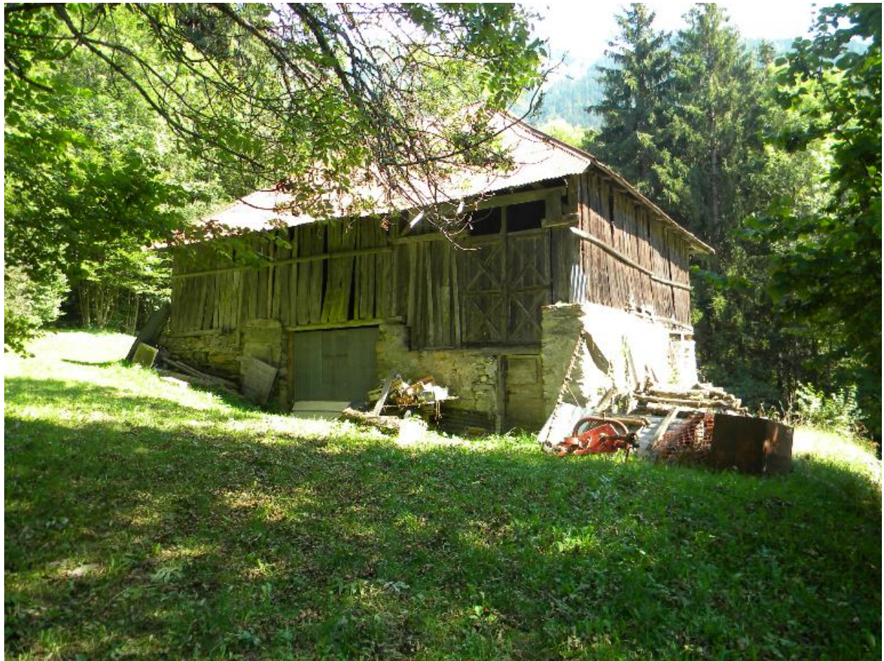
Vue d'ensemble d'une grange-étable (2008 E6 781,788,789).
