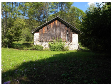
Vue d'une grange depuis l'aval (2008 E7 949) Phot. Jérôme Daviet IVR82_20157401642NUCA
