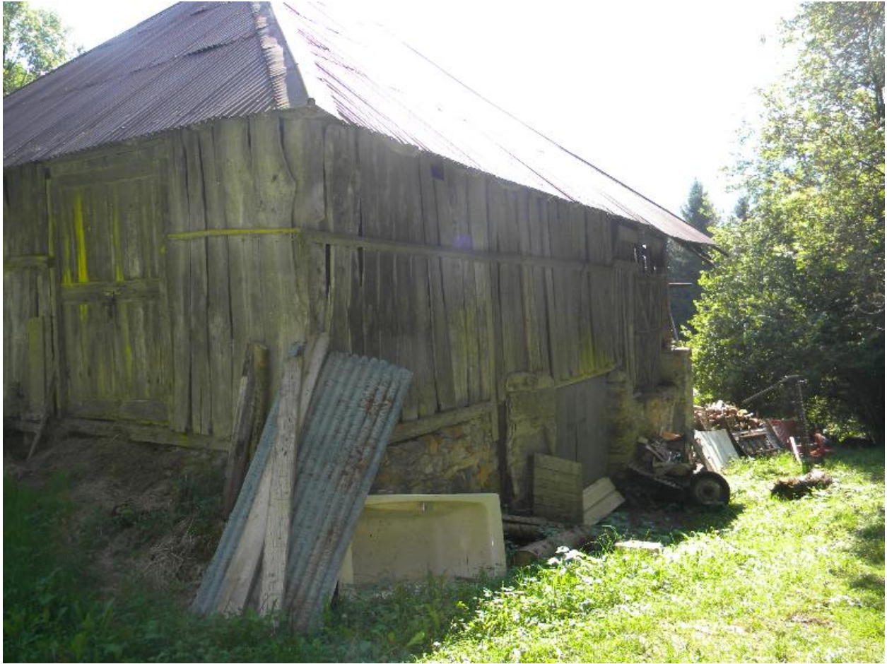
Vue de trois quarts nord-est d'une grange-étable (2008 E6 781,788,789).
