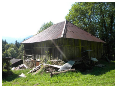
Vue de la façade sud d'une grange- étable (2008 E6 781,788,789). Phot. Jérôme Daviet IVR82_20157401650NUCA
