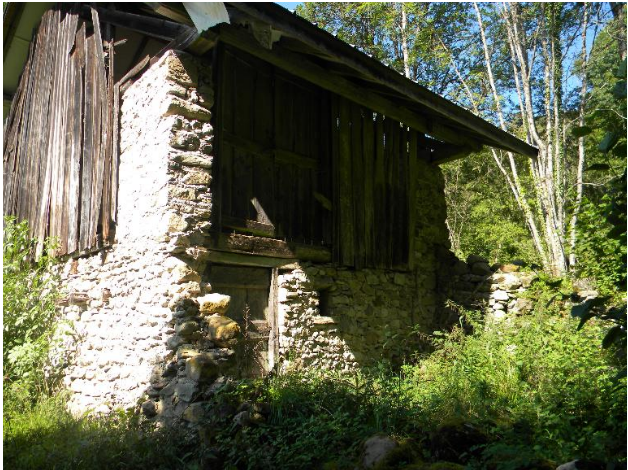
Vue de la façade sud d'une grange (2008 E7 949).
