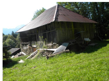
Vue de trois-quarts sud- est (2008 E6 781,788,789). Phot. Jérôme Daviet IVR82_20157401649NUCA
