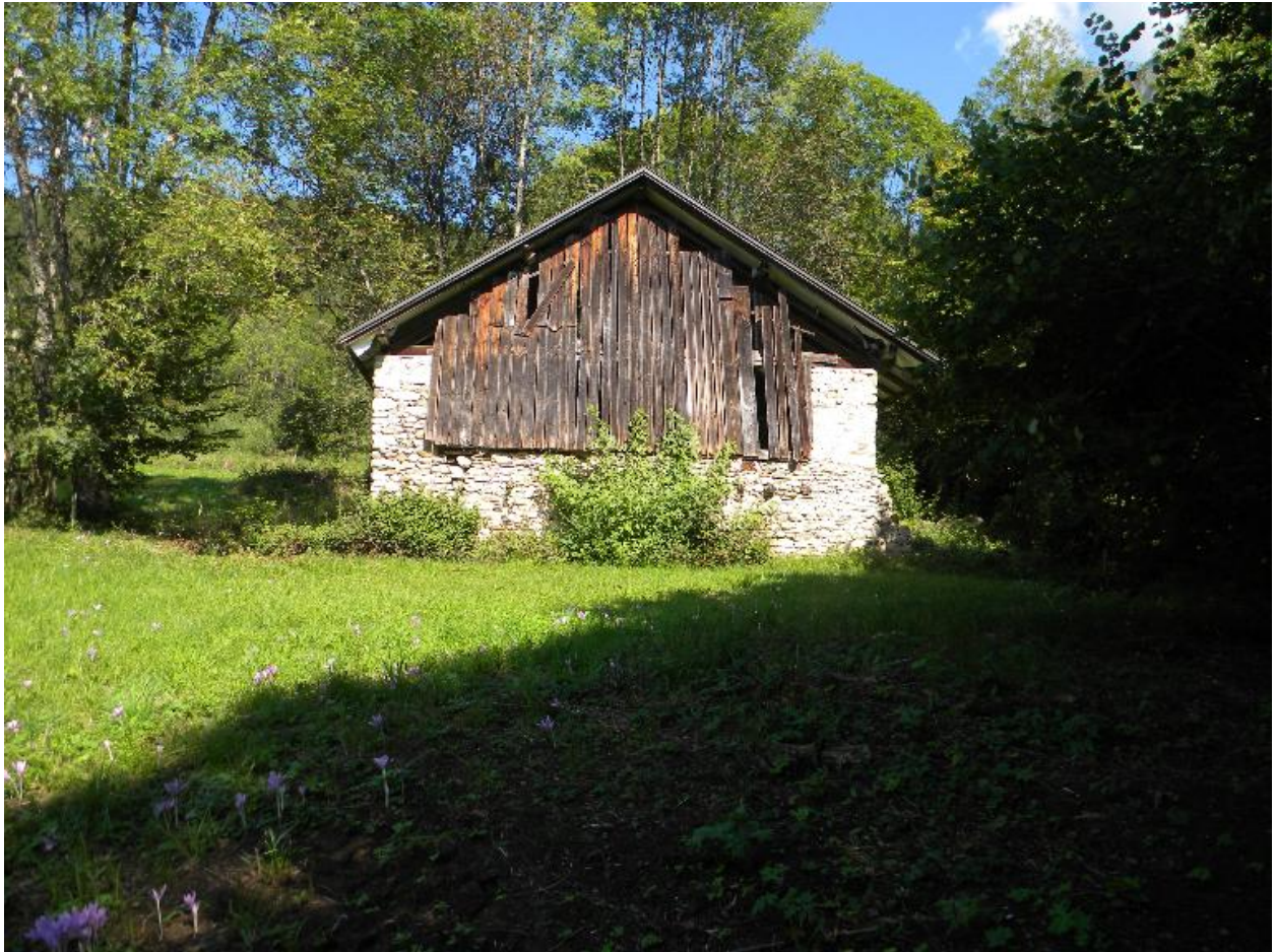
Vue d'une grange depuis l'aval (2008 E7 949)
