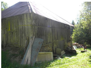
Vue de trois quarts nord-est d'une grange-étable (2008 E6 781,788,789). Phot. Jérôme Daviet IVR82_20157401648NUCA
