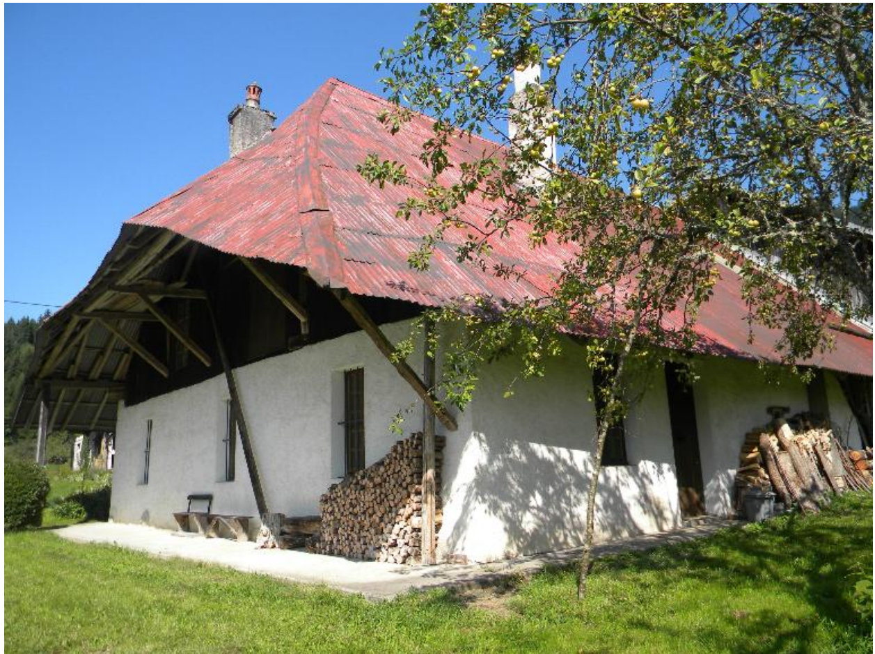
Vue de l'habitation de la ferme du Planchard.
