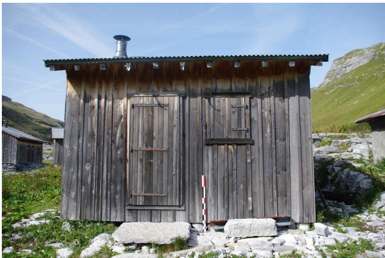
Vue de la façade antérieure sud
