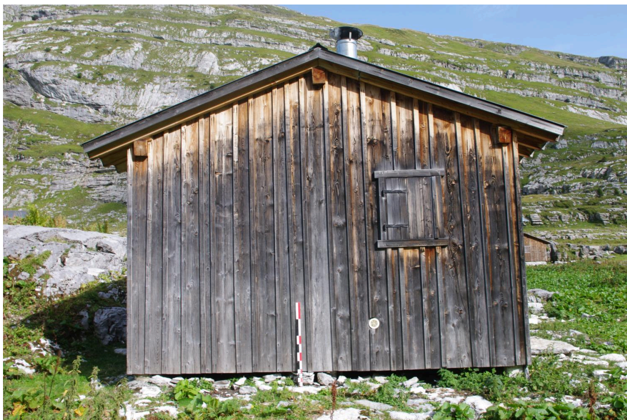
Vue du mur pignon ouest
