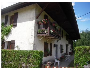
Vue d'une ancienne ferme réaménagée en maison d'habitation. Phot. Clémence Serve IVR82_20117403580NUCA
