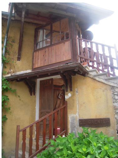
Vue d'une maison d'habitation du chef-lieu. Phot. Clémence Serve IVR82_20117403575NUCA
