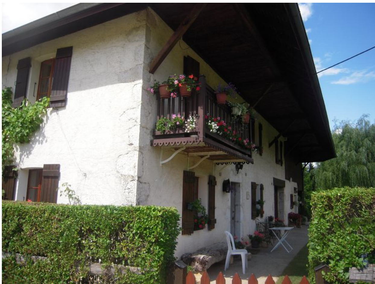
Vue d'une ancienne ferme réaménagée en maison d'habitation.
