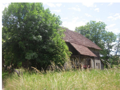
Vue d'un bâtiment agricole du chef-lieu. Phot. Clémence Serve IVR82_20117403577NUCA
