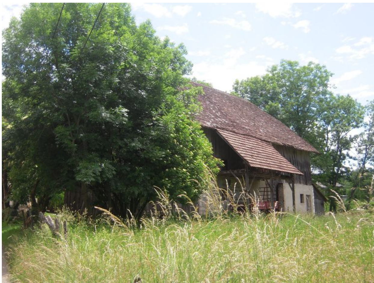
Vue d'un bâtiment agricole du chef-lieu.
