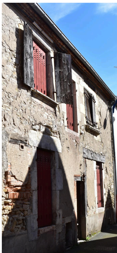
Façade du n°16, rue des orfèvres (parcelle cadastrale B01 : 109), détail de deux baies du 1er étage présentant des encadrements et appuis moulurés ainsi qu'un départ de meneau sur le linteau de la seconde, datables de la limite des 15e et 16e siècles.
