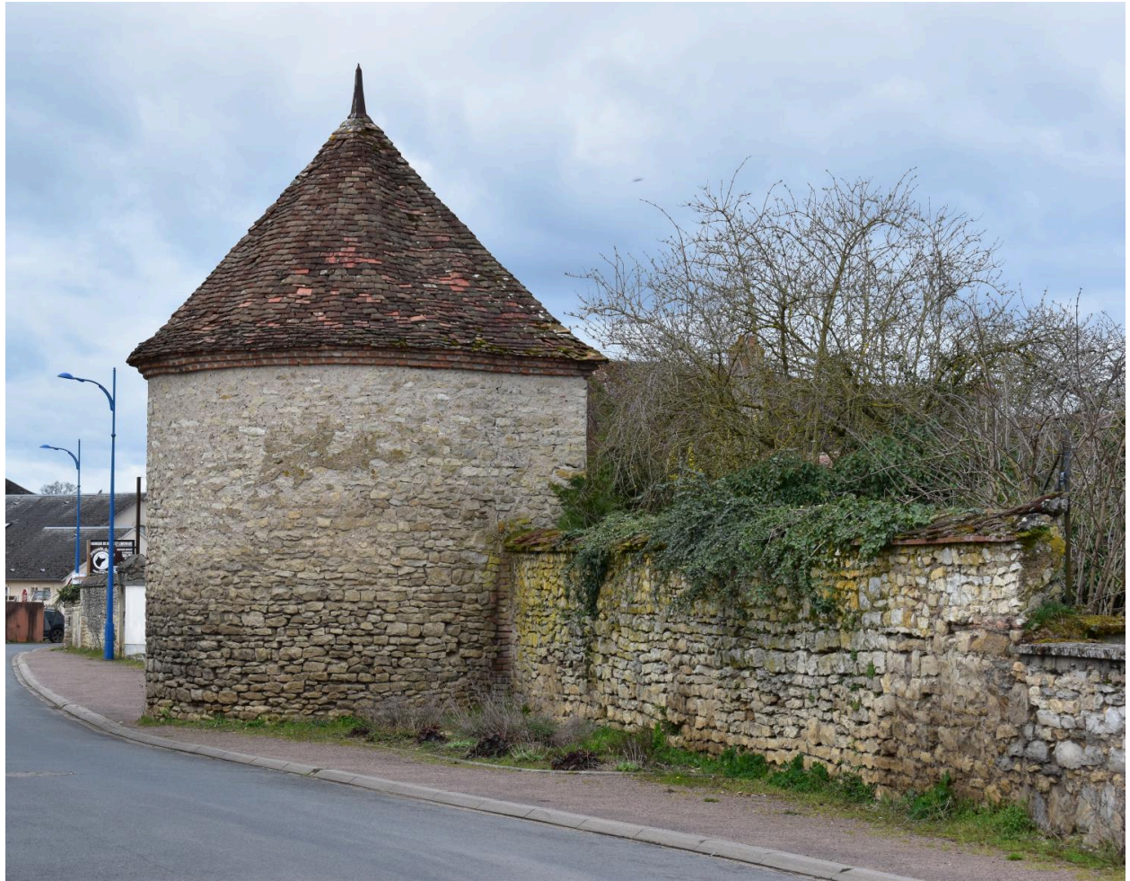
Tour, vestige de la fortification d'agglomération du Veudre, parcelle cadastrale B01 : 123, donnant sur la rue Tour des murs. Vue vers le sud
