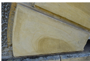
Détail de pierre de taille gravée de graffitis de bateaux, 14, rue d'Allier. Phot. Maryse Durin-Tercelin IVR84_20250300723NUCA
