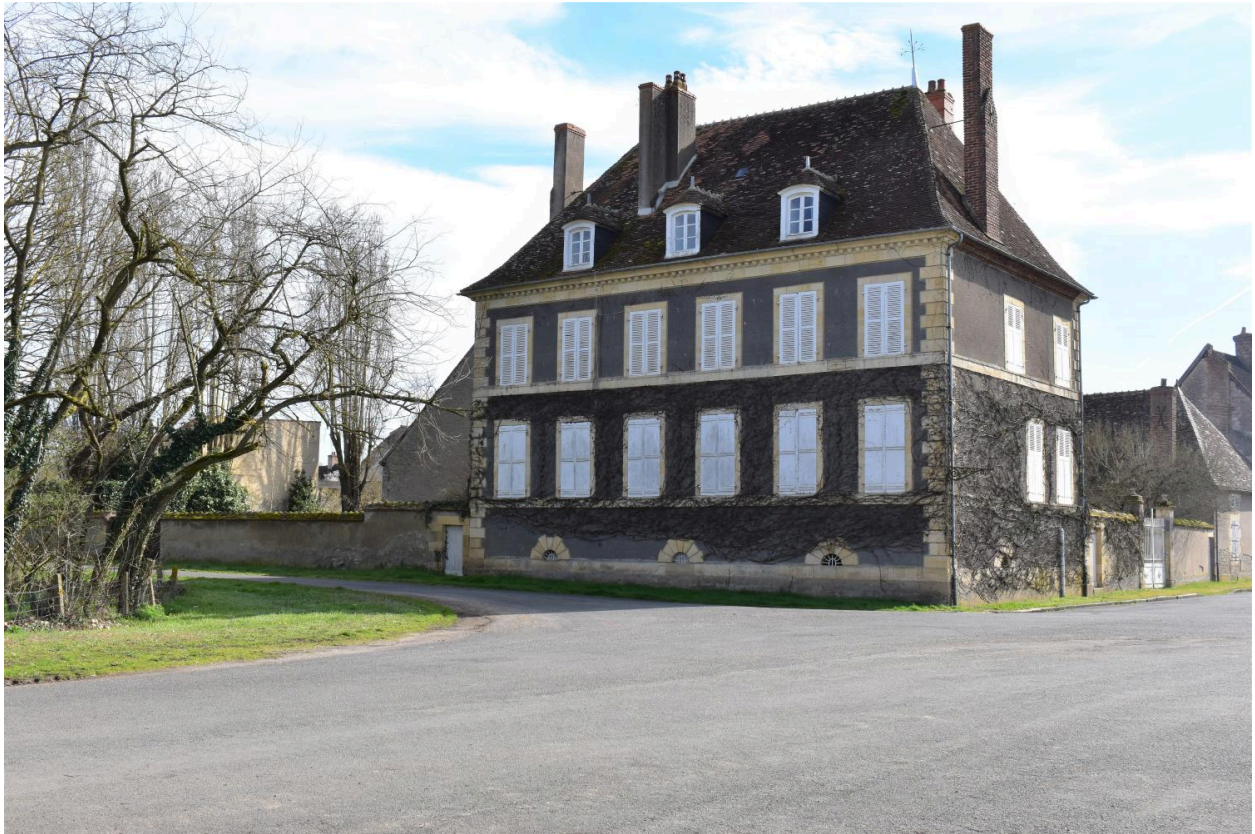
Maison dit "hostel" "bâti en 1779 par Me Gabriel François Douyet de la Vilaine, notaire royal" d'après Le Brun, 1913, p. 111. 14, rue d'Allier, parcelle cadastrale B01 : 49. Façade nord.
