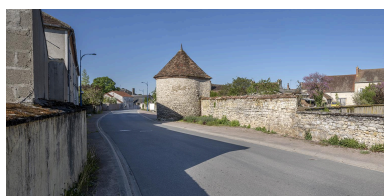
Tour et vestige de la fortification d'agglomération du Veurdre, parcelle cadastrale B01 : 123, donnant sur la rue Tour des murs. Vue vers le sud Phot. Franck Trabouillet IVR84_20260300342NUCA
