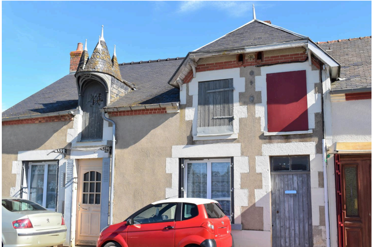
Ensemble de deux maisons contiguës, 26, 24 Faubourg de Lorette, parcelle cadastrale B02 : 1217-1218, détail du pigeonnier et de l'une des lucarnes charpentées.
