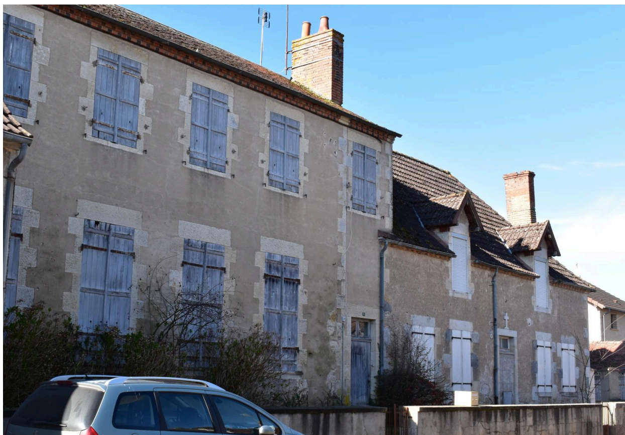
Ecole libre édifée en 1883 et 1884, actuellement maison d'habitation, 17-19 faubourg de Lorette, parcelle cadastrale B01 : 204-205. Vue générale.
