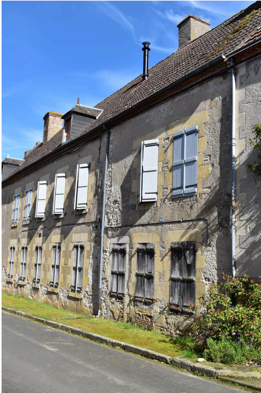
Maison, 12, rue d'Allier, parcelle cadastrale B01 : 1132. Vue générale de la façade sur rue, limite du 18e siècle et 19e siècle.
