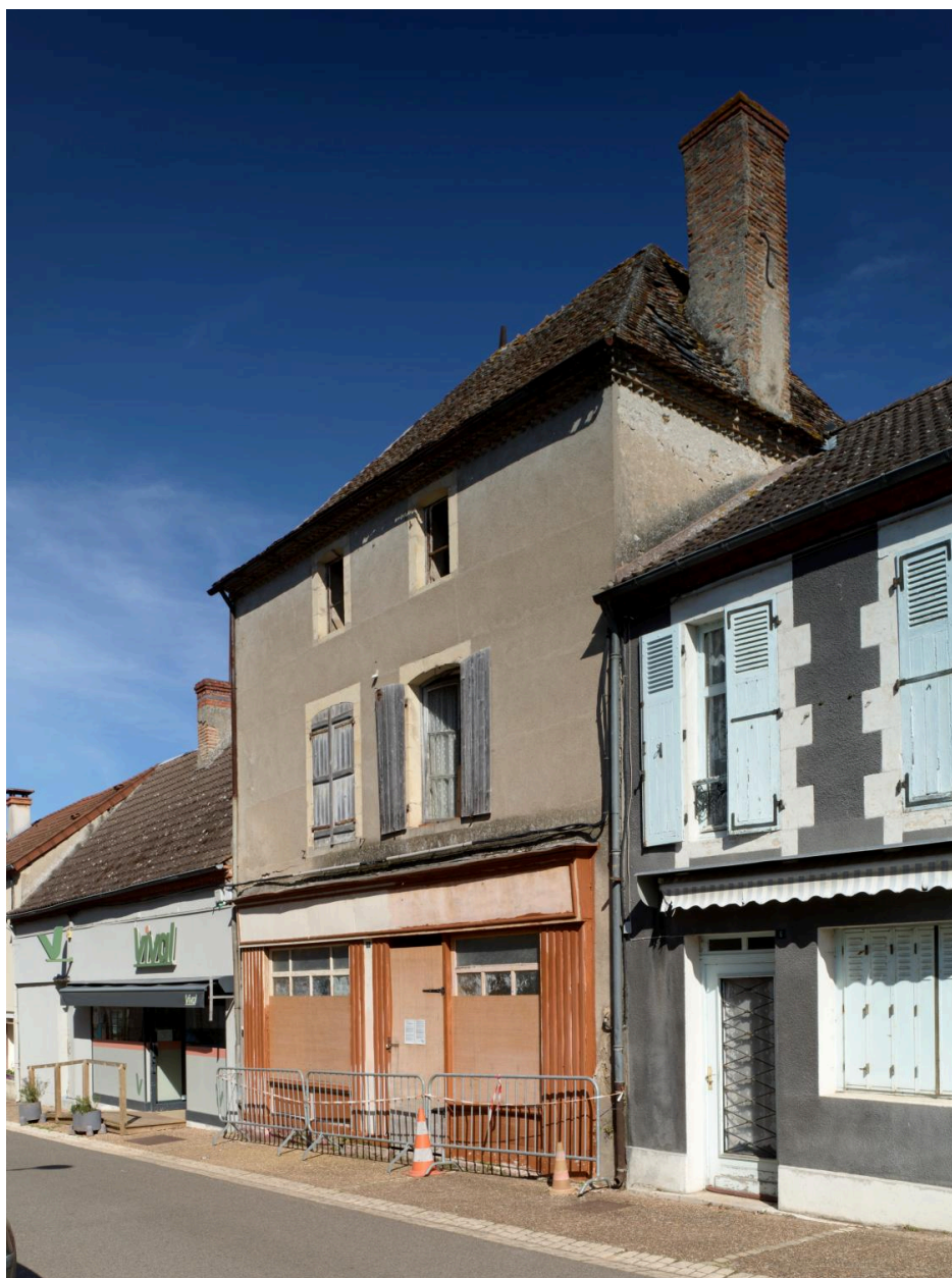
Maison dite hôtel des Vilhardin de Marcellange, 8, rue Monnet parcelle cadastrale B01 : 94.
