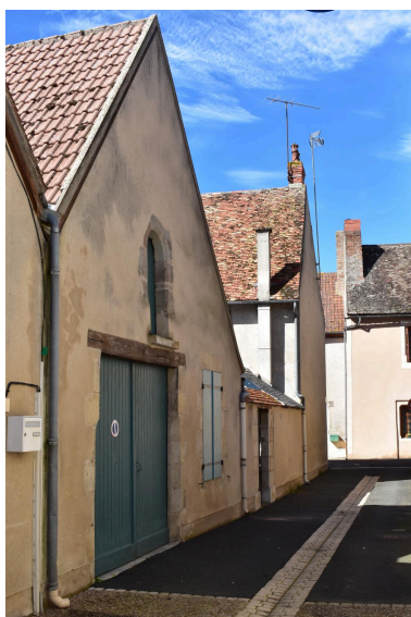
Mur pignon du n°21 rue des orfèvres (parcelle cadastrale B01 : 137) présentant une baie en plein cintre et des piédroits de double porte moulurés probablement datables de la limite des 15e et 16e siècles.
