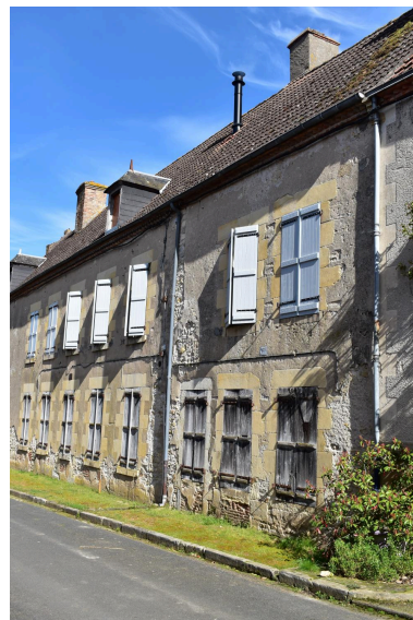
Maison, 12, rue d'Allier, parcelle cadastrale B01 : 1132. Vue générale de la façade sur rue, limite du 18e siècle et 19e siècle. Phot. Maryse Durin-Tercelin IVR84_20260300055NUCA
