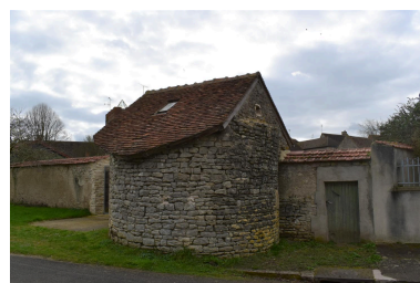
Tour, vestige de la fortification d'agglomération du Veurdre, B01 : 1343, donnant sur la place du Champ de Foire. Vue vers l'est. Phot. Maryse Durin-Tercelin IVR84_20260300053NUCA
