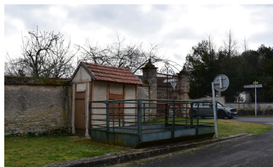
Pont-bascule édifié en 1881, rue du Tour des Murs, parcelle cadastrale B02 : 1070. Phot. Maryse Durin-Tercelin IVR84_20260300031NUCA
