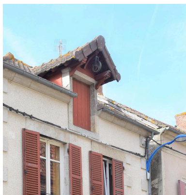
Maison, 7, rue d'Allier, parcelle cadastrale B01 : 78. Maison surhaussée avec ajout d'une lucarne à auvent dans le premier quart du 20e siècle. (Voir les deux vues de la rue d'Allier d'après les cartes postales anciennes contemporaines). Vue de la lucarne munie d'une poulie. Phot. Maryse Durin-Tercelin IVR84_20260300015NUCA
