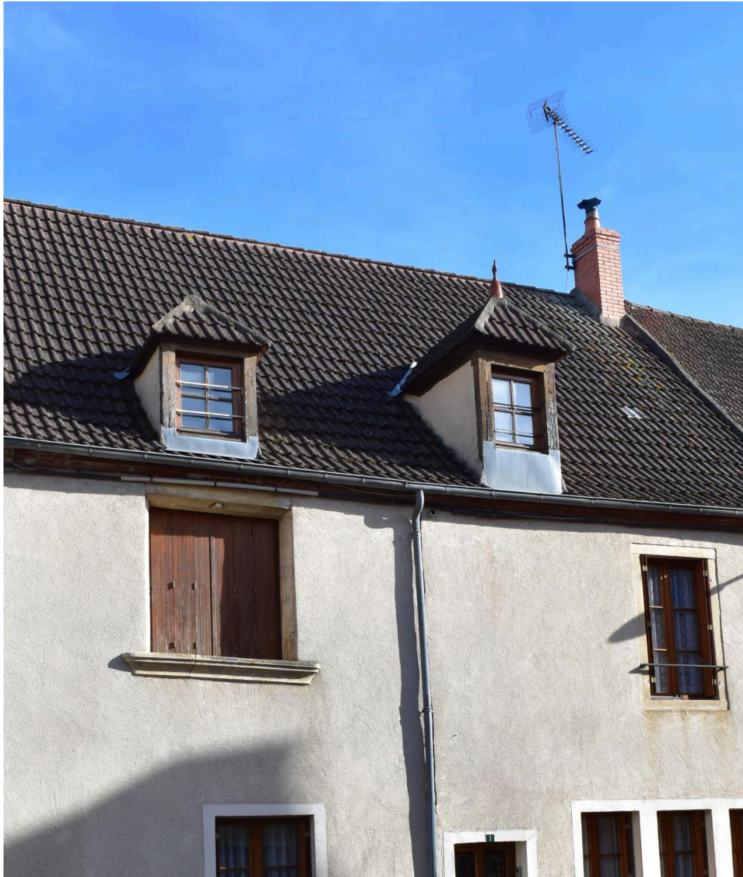
Façade du n°3 rue de Bourbon (parcelle cadastrale B01 : 108), détail de la baie du 1er étage présentant des moulurations et un départ de meneau sur son encadrement et l'appui datables de la limite des 15e et 16e siècles.
