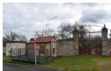
Pont-bascule édifé en 1881, rue du Tour des Murs, parcelle cadastrale B02 : 1070. Phot. Maryse Durin-Tercelin IVR84_20260300030NUCA
