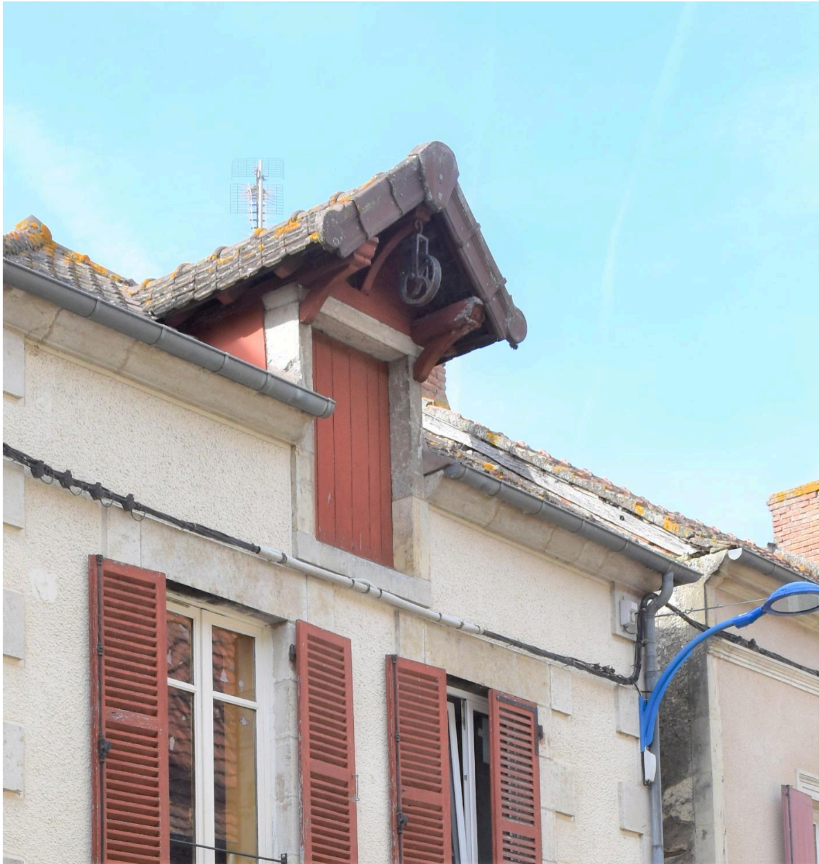
Maison, 7, rue d'Allier, parcelle cadastrale B01 : 78. Maison surhaussée avec ajout d'une lucarne à auvent dans le premier quart du 20e siècle. (Voir les deux vues de la rue d'Allier d'après les cartes postales anciennes contemporaines). Vue de la lucarne munie d'une poulie.
