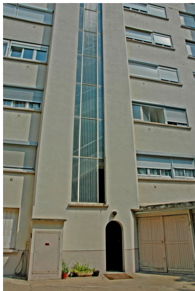
La cage d'escalier demi-hors-oeuvre Phot. Maryannick Chalabi IVR82_20066903047NUCA
