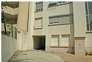
Vue du passage couvert depuis la cour Phot. Maryannick Chalabi IVR82_20066903048NUCA
