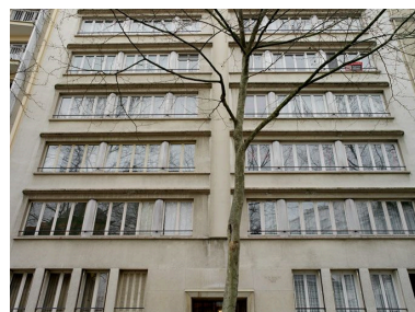
Détail des fenêtres Phot. Eric Dessert IVR82_20096900259NUCA
