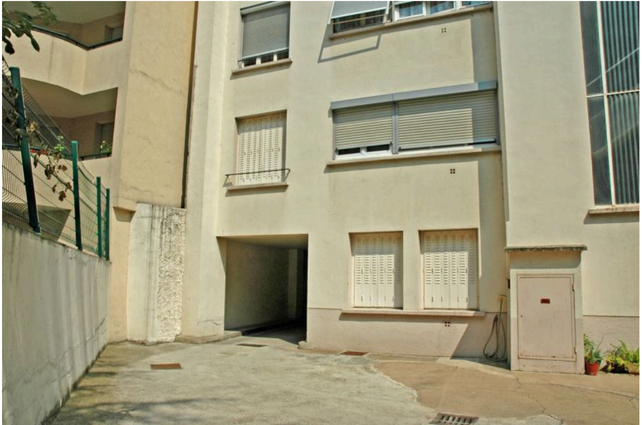
Vue du passage couvert depuis la cour
