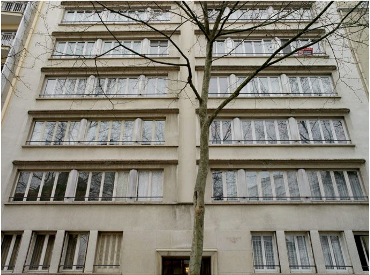
Détail des fenêtres
