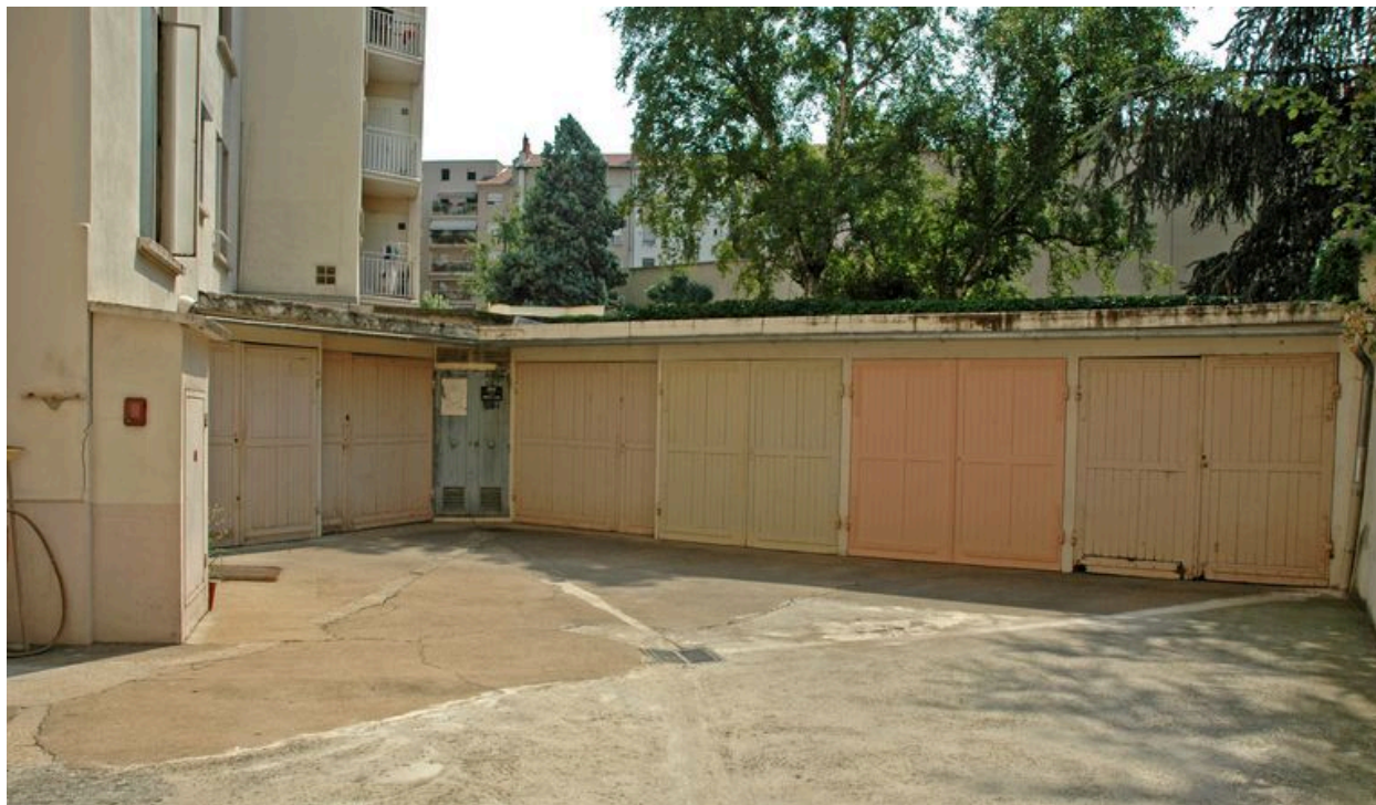
Les garages construits dans la cour
