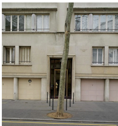
Vue de l'entrée Phot. Eric Dessert IVR82_20096900258NUCA
