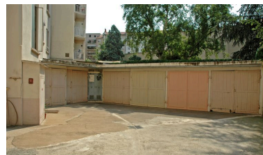
Les garages construits dans la cour Phot. Maryannick Chalabi IVR82_20066903049NUCA
