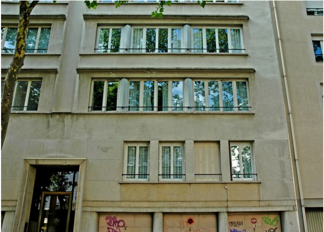
Détail d'une travée d'ouvertures
