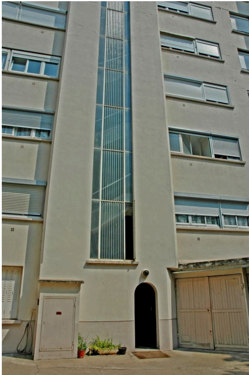
La cage d'escalier demi-hors-oeuvre
