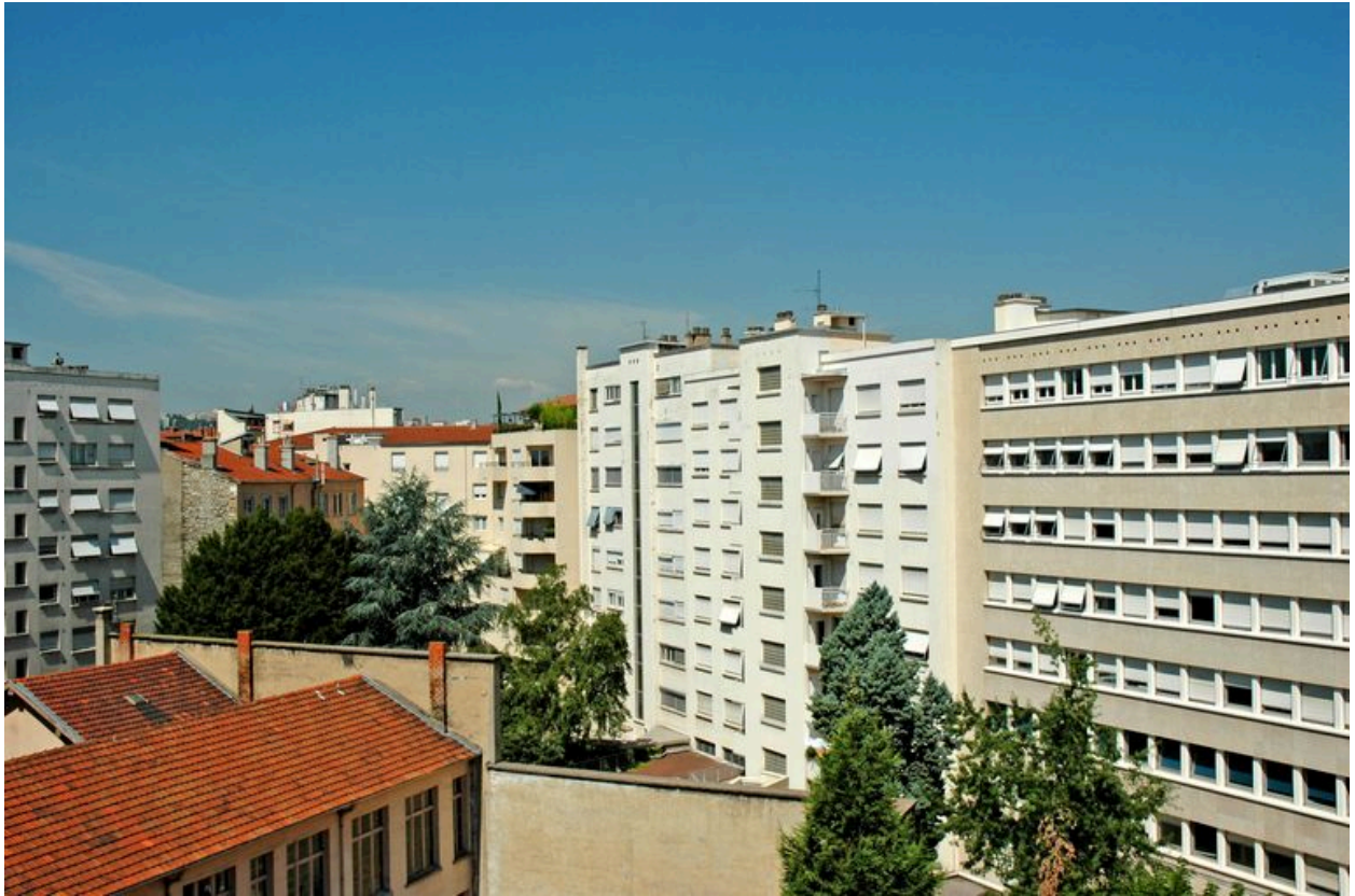
Vue d'ensemble de l'élévation postérieure et des cours depuis le sud-est
