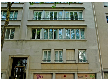
Détail d'une travée d'ouvertures Phot. Maryannick Chalabi IVR82_20066903044NUCA
