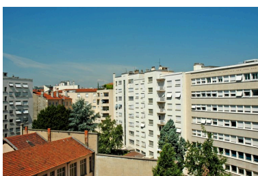
Vue d'ensemble de l'élévation postérieure et des cours depuis le sud-est Phot. Maryannick Chalabi IVR82_20066903073NUCA
