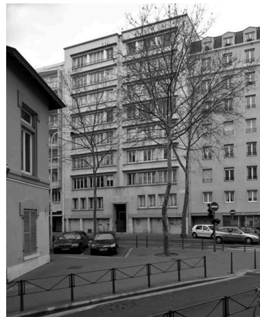
Vue depuis le nord-ouest Phot. Eric Dessert IVR82_20076901318NUC
