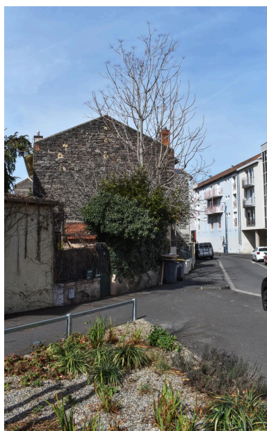
Carrefour de la rue de Romagnat et du boulevard Cote-Blatin, mur aveugle Phot. Félicie Fougère IVR84_20246301216NUCA
