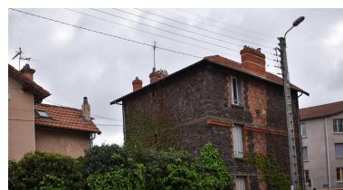
Elévation postérieure aveugle Phot. Félicie Fougère IVR84_20246301212NUCA
