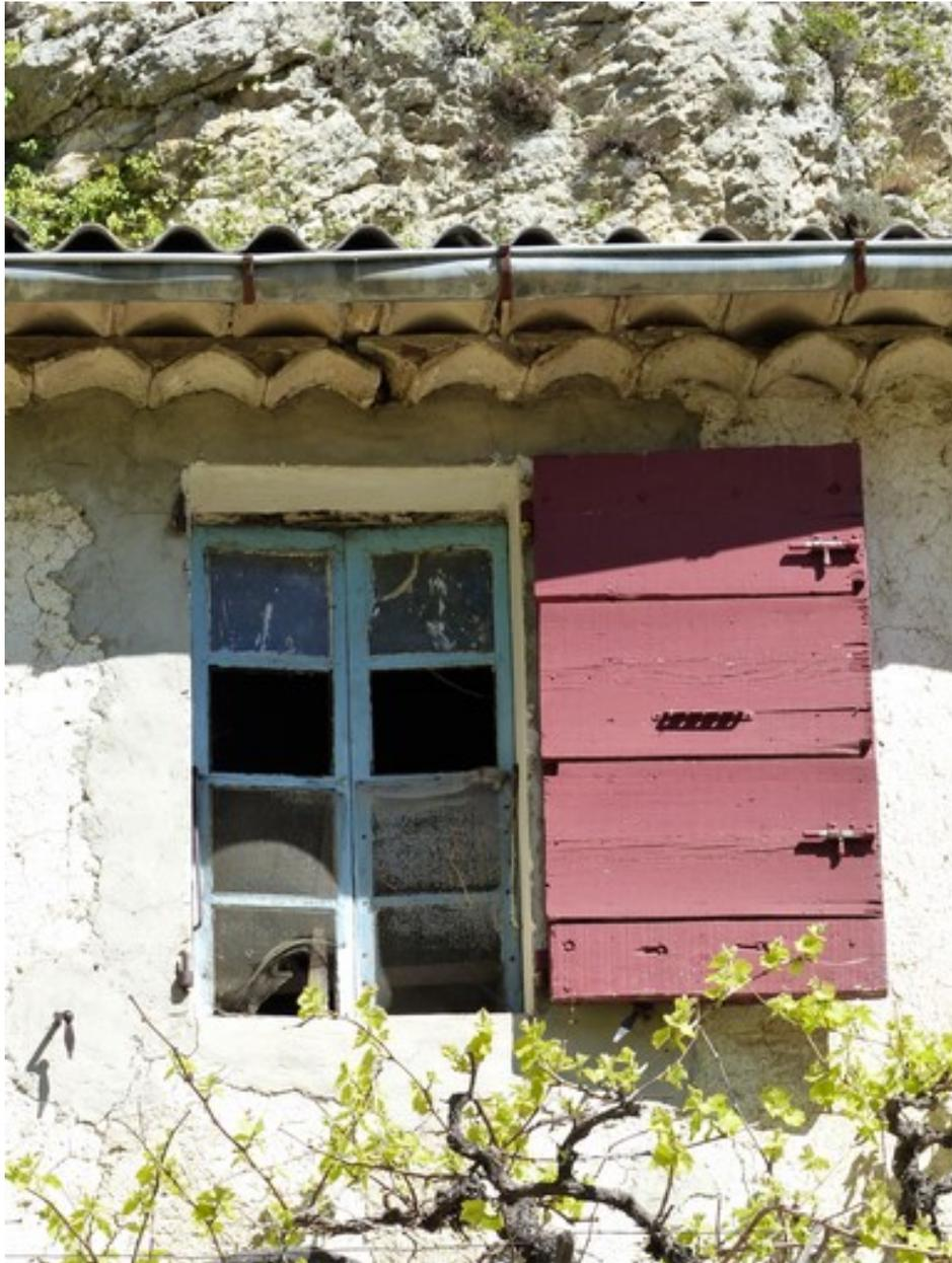
Elévation est, troisième niveau. Fenêtre équipée de contrevents en planches.
