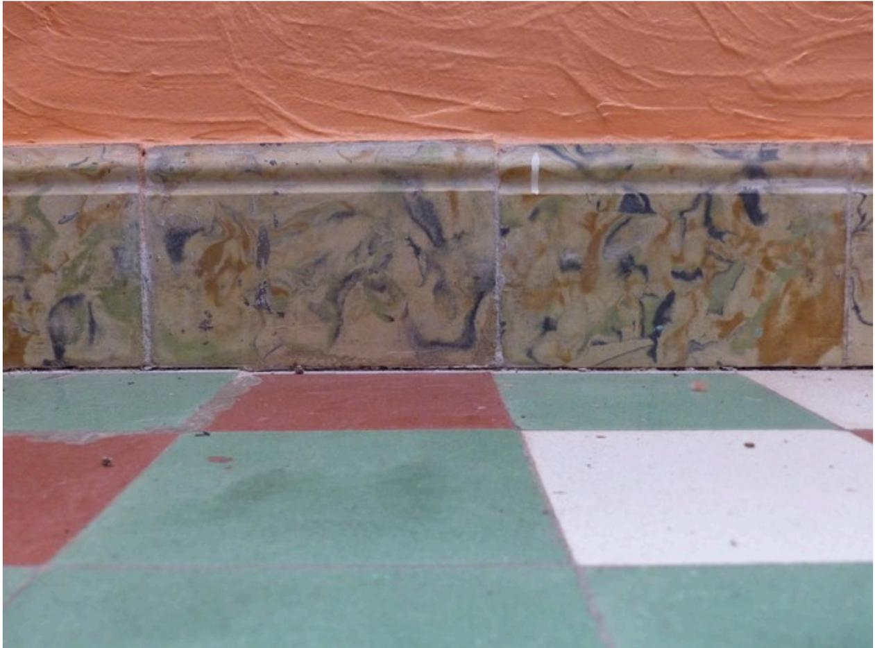
Rez-de-chaussée surélevé, chambre. Sol et plinthes en carreaux de ciment.
