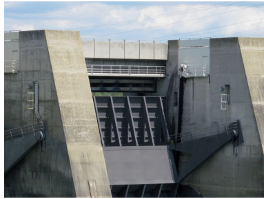
Barrage, face aval, vue partielle : une passe Phot. I. Havard IVR82_20104200011NUCA
