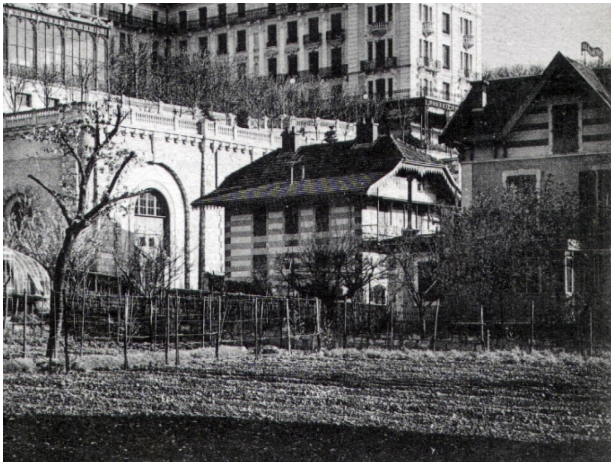
Vue prise du nord
