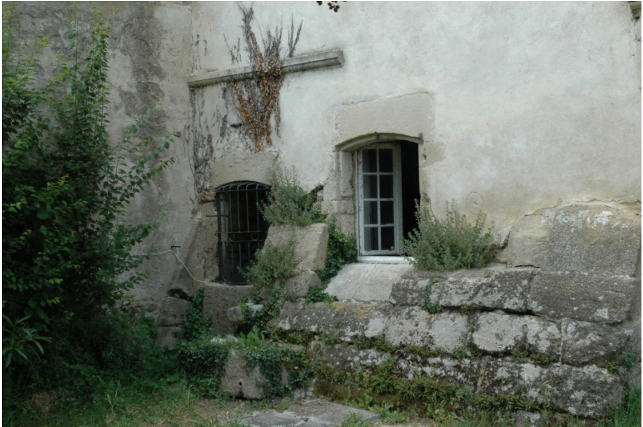
Vue sud du puits et du mur taluté
