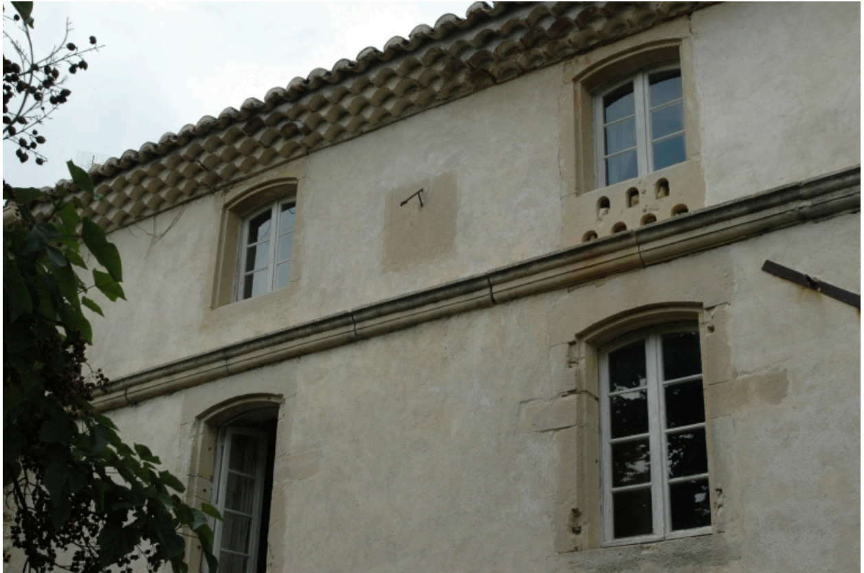
vue sud d'un détail de la façade
