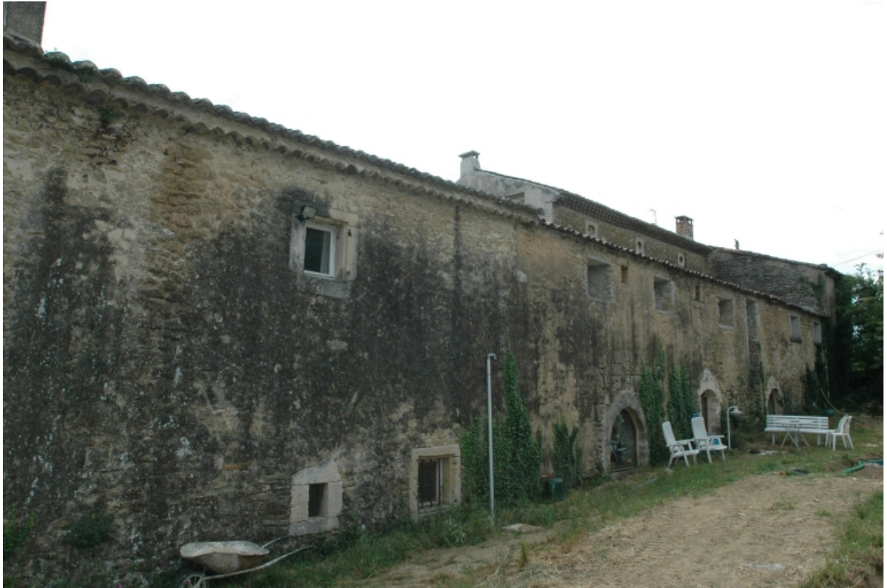
Vue nord de la façade de la maison
