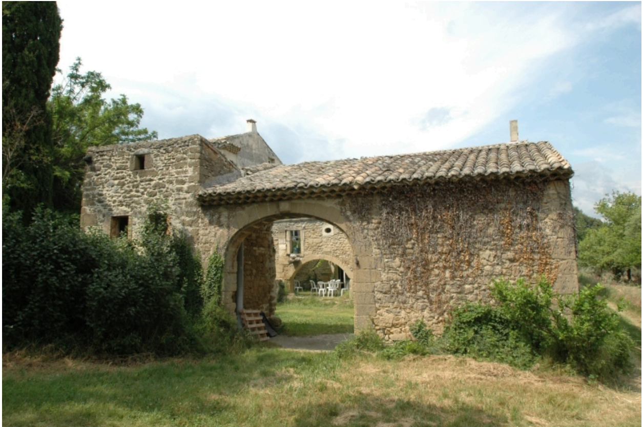
Vue sud du porche d'entrée
