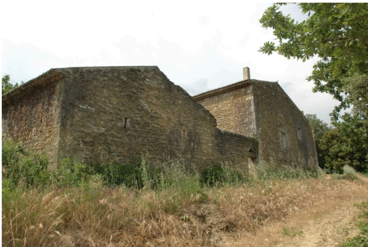
Vue est de la maison et du porche d'entrée
