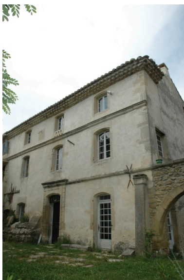
Vue sud-est de la façade de la maison Phot. Geneviève Jourdan IVR82_20092600474NUCA
