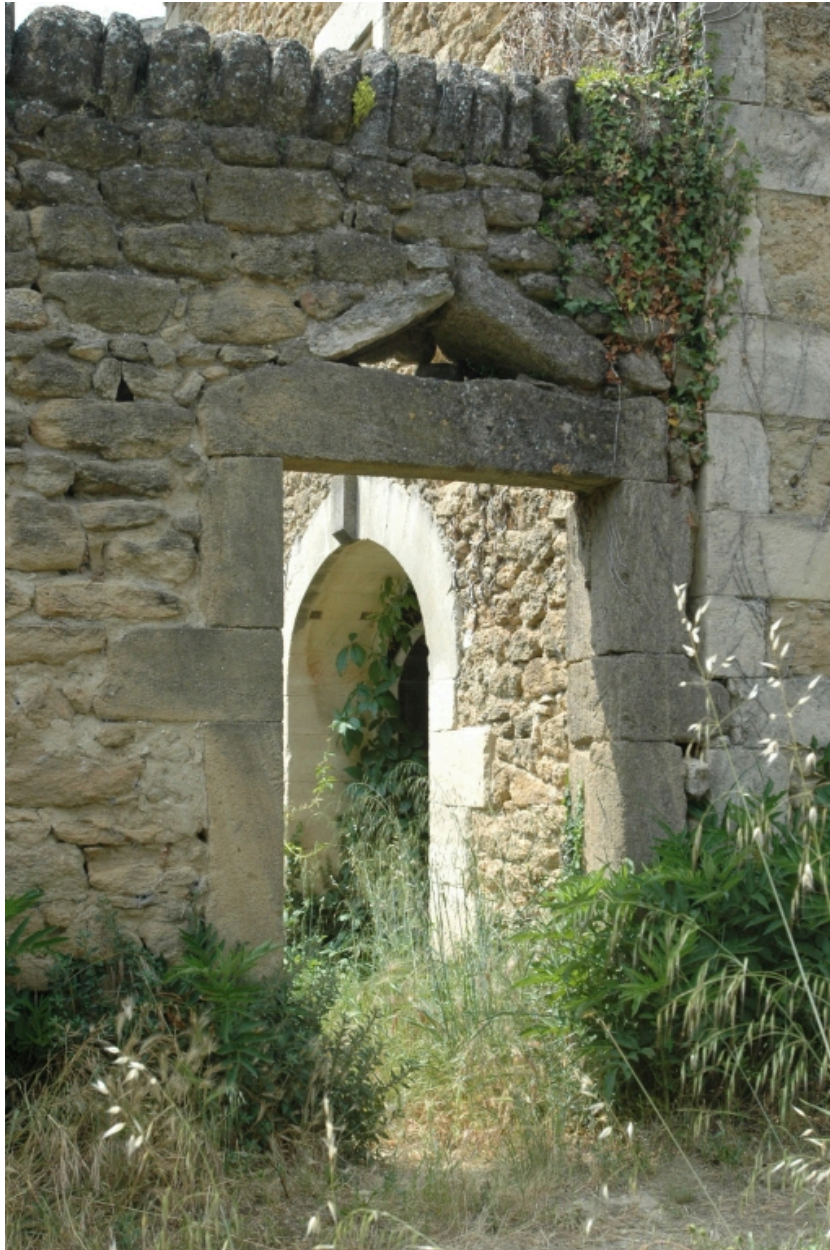
Détail est d'une porte de la façade de la maison
