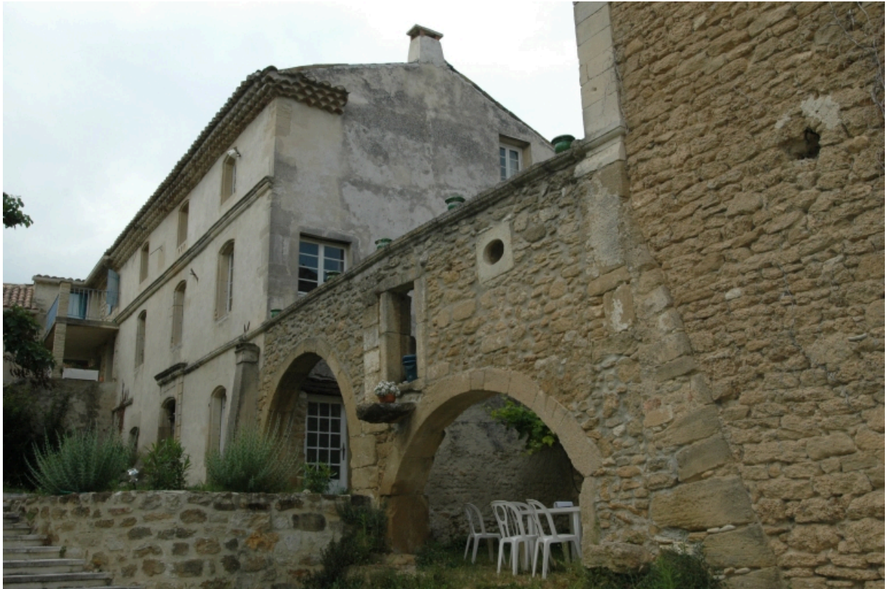
vue sud-est de la maison, du porche et de la magnagerie
