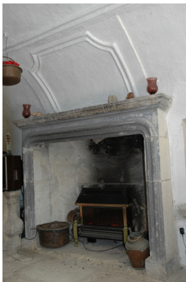
Vue de la cheminée du salon Phot. Geneviève Jourdan IVR82_20092600486NUCA
