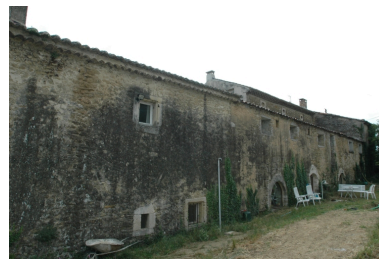
Vue nord de la façade de la maison Phot. Geneviève Jourdan IVR82_20092600481NUCA
