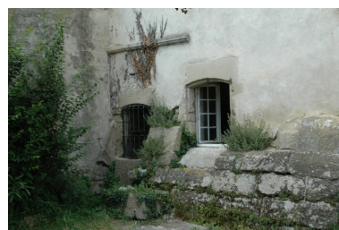
Vue sud du puits et du mur taluté Phot. Geneviève Jourdan IVR82_20092600476NUCA
