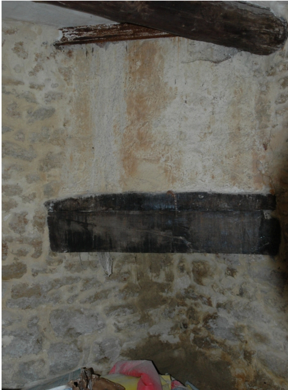
Vue d'une des cheminée d'angle de la magnanerie
