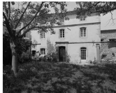
Vue partielle de la façade de la maison Phot. Alain Franchella IVR82_19972600274X
