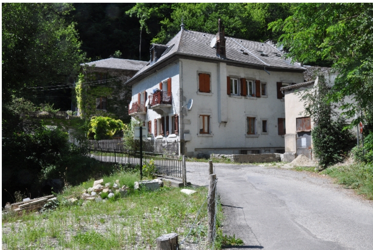
Vue de l'ancienne papeterie du Bout du Monde
