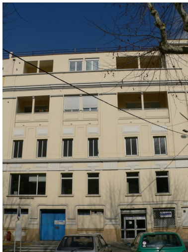
Façade principale Phot. Isabelle Dupuis IVR82_20093800341NUCA
