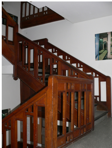
Escalier de l'entreprise Phot. Isabelle Dupuis IVR82_20093800340NUCA
