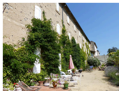
Façade postérieure côté jardin et rivière Ardèche Phot. Nadine Halitim-Dubois IVR84_20180700054NUCA
