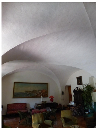
Manufacture Royale Deydier : vue intérieure système voûté Phot. Nadine Halitim-Dubois IVR84_20180700060NUCA
