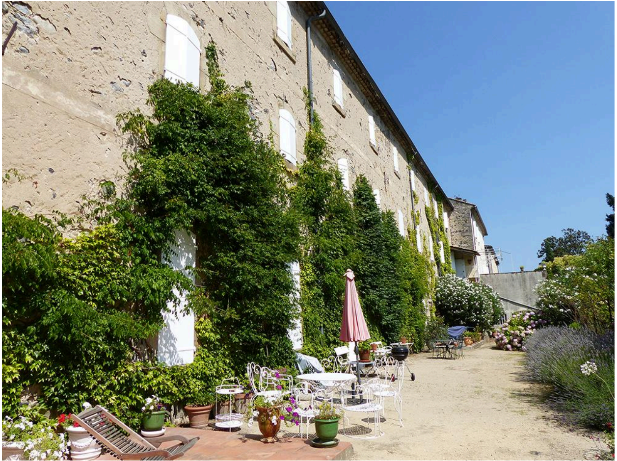
Façade postérieure côté jardin et rivière Ardèche
