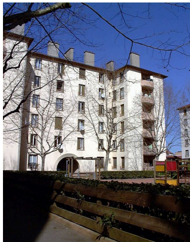
Elévation depuis la rue Ferdinand-Buisson Phot. Bernard Ducouret IVR82_20016900871NUCA
