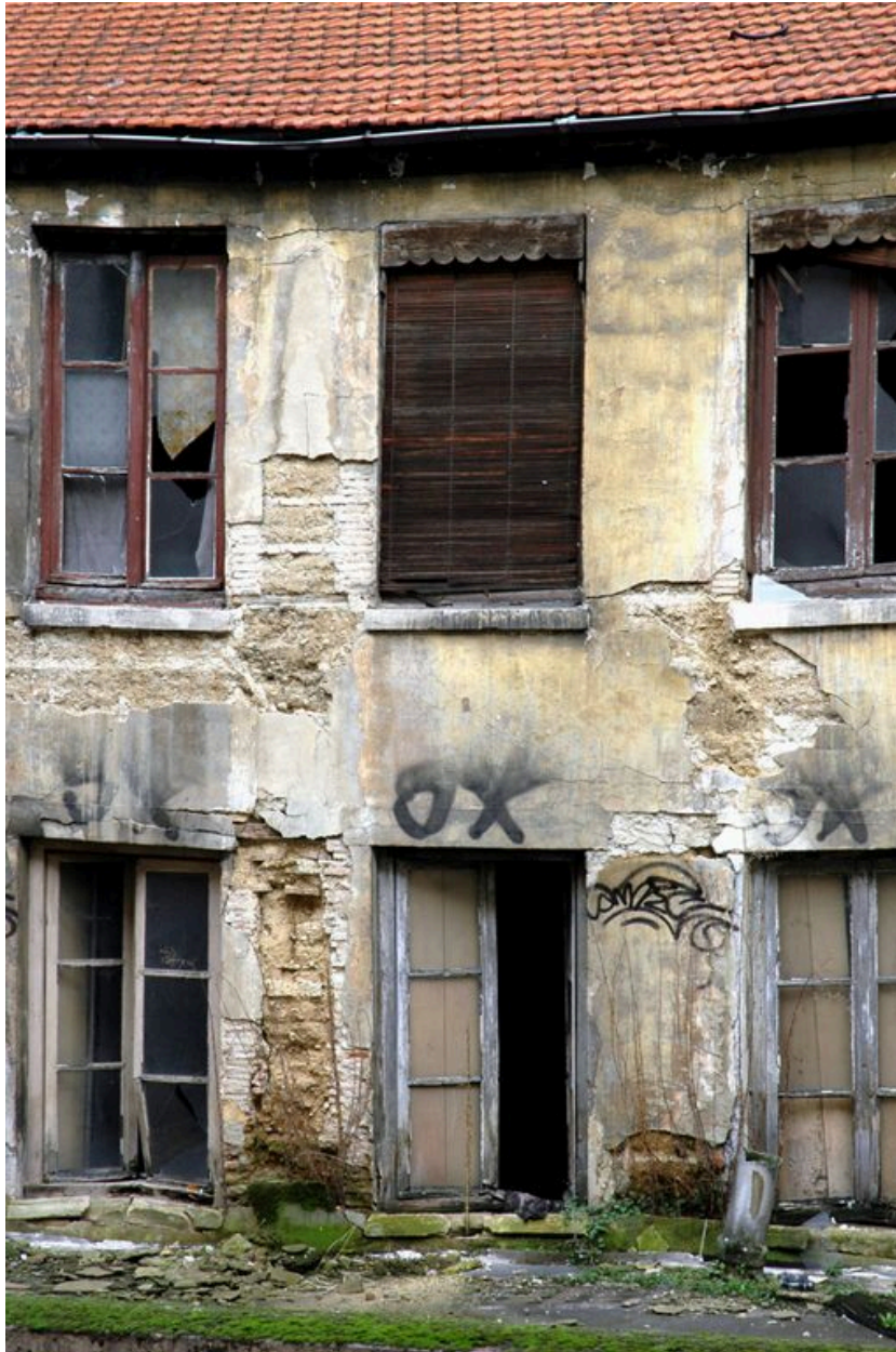
Détail de l'élévation antérieure
