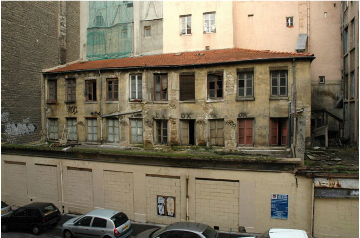
Elévation antérieure et garages au niveau de la rue
