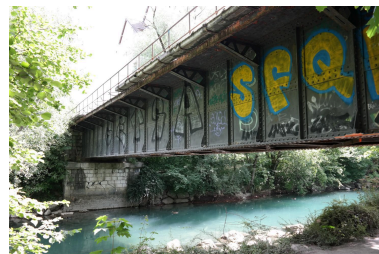
Ancien pont ferroviaire de Cran, détail de la pile en rive droite Phot. Pascale Renard IVR84_20207403852NUCA
