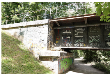
Ancien pont ferroviaire de Cran, détail de la pile en rive gauche Phot. Pascale Renard IVR84_20207403851NUCA
