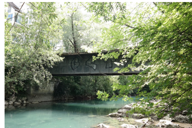
Ancien pont ferroviaire de Cran, vue de la face aval Phot. Pascale Renard IVR84_20207403849NUCA
