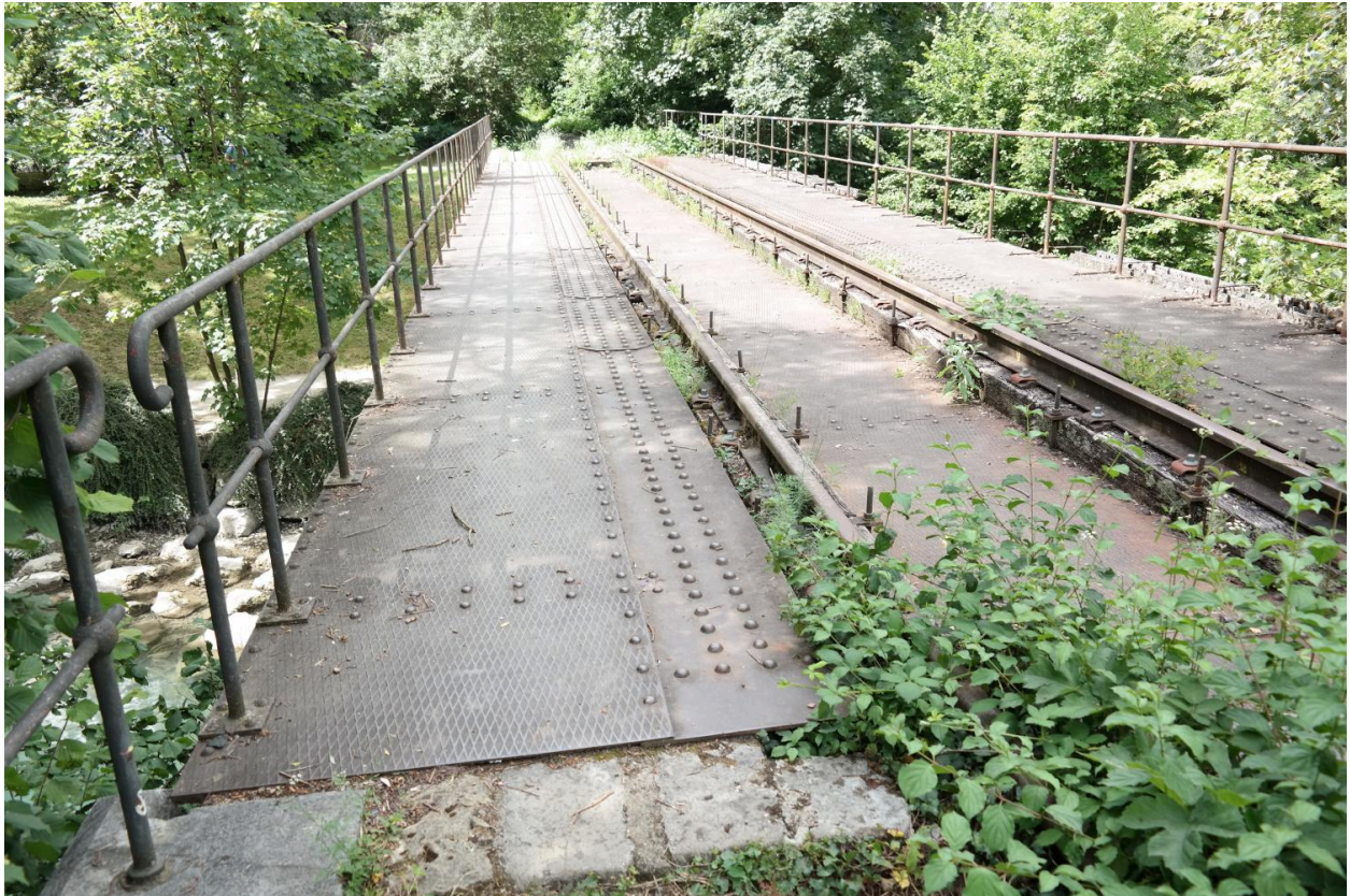
Ancien pont ferroviaire de Cran, vue de la chaussée
