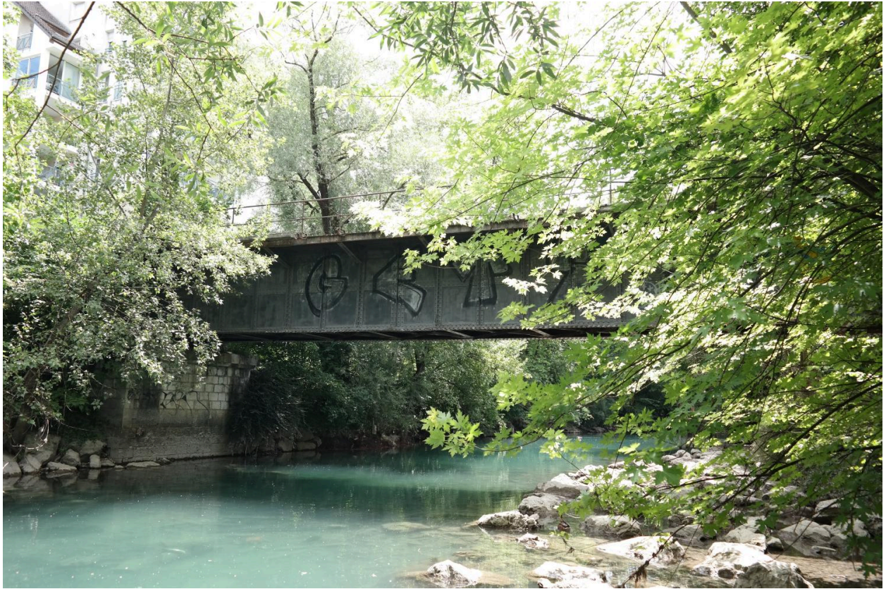
Ancien pont ferroviaire de Cran, vue de la face aval
