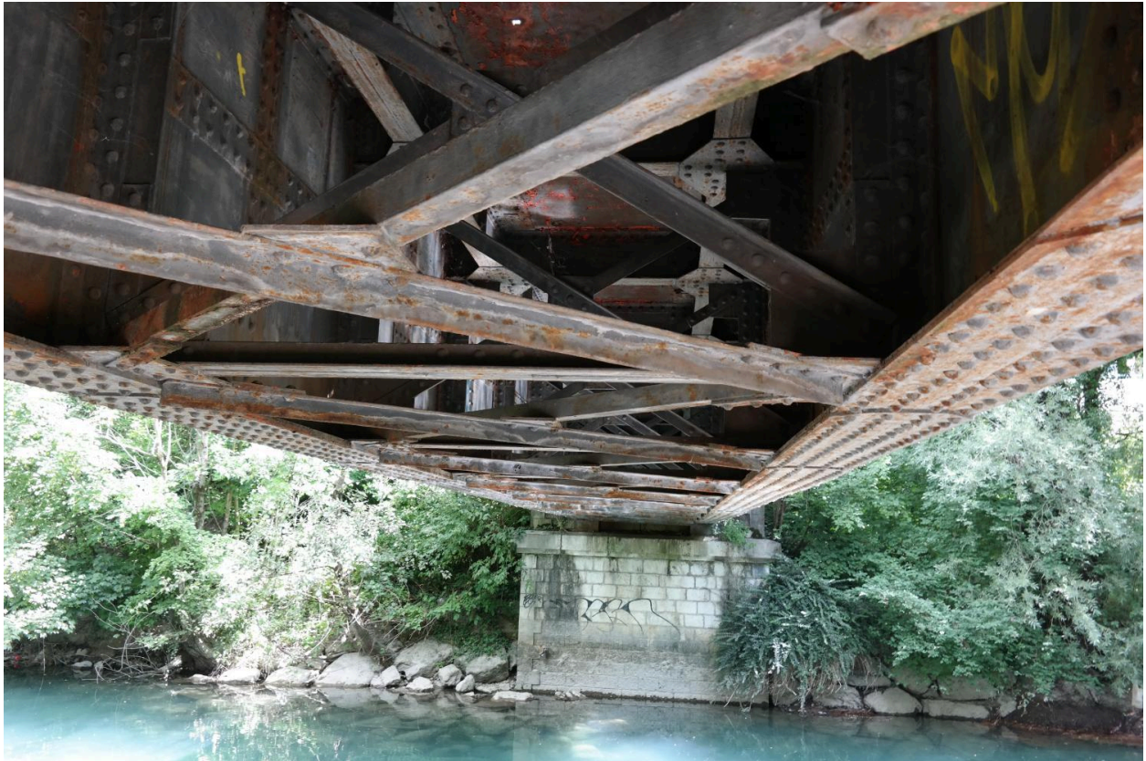
Ancien pont ferroviaire de Cran, détail de la structure du tablier
