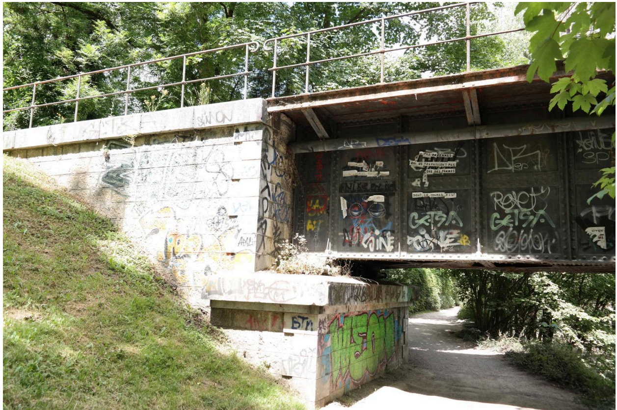
Ancien pont ferroviaire de Cran, détail de la pile en rive gauche
