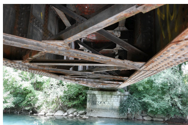
Ancien pont ferroviaire de Cran, détail de la structure du tablier Phot. Pascale Renard IVR84_20207403853NUCA
