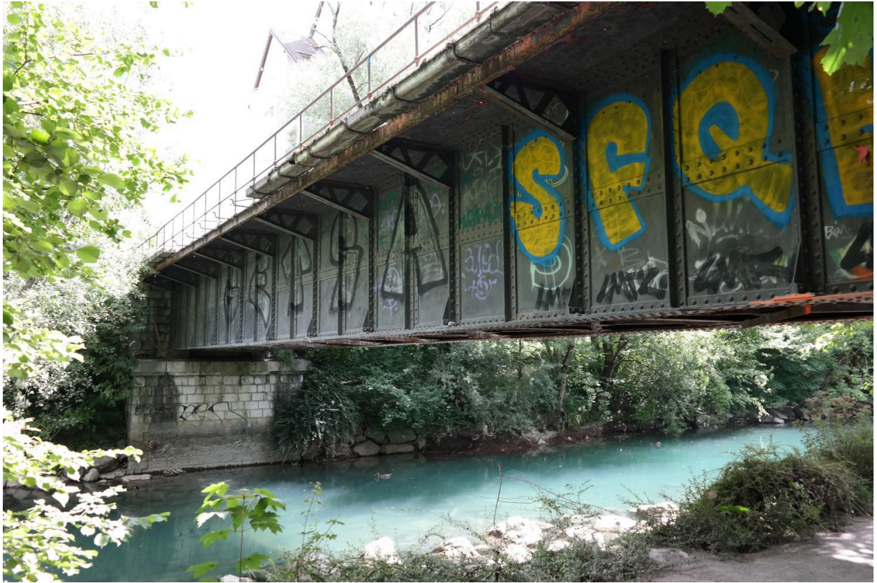
Ancien pont ferroviaire de Cran, détail de la pile en rive droite
