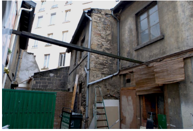
Vue d'ensemble depuis le nord-ouest Phot. Maryannick Chalabi IVR82_20086900845NUCA
