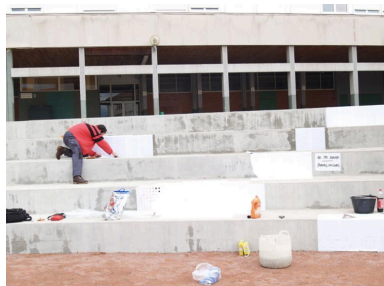
Installation en cours (2007). Autr. auteur inconnu IVR84_20204200031NUCAB
