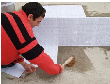
Installation en cours : vue rapprochée, application des patrons (2007). Autr. auteur inconnu IVR84_20204200032NUCAB
