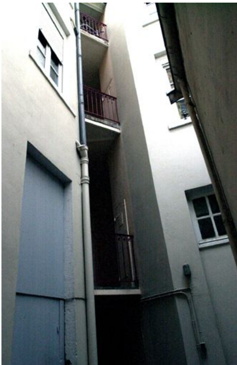
Vue de la cage d'escalier ouverte sur la cour
