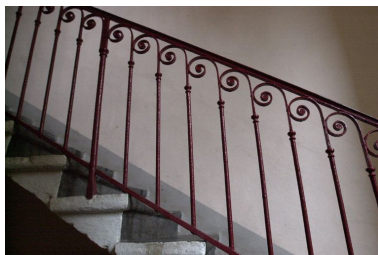
Détail de la rampe d'escalier en ferronnerie Phot. Maryannick Chalabi IVR82_20016900119NUCA
