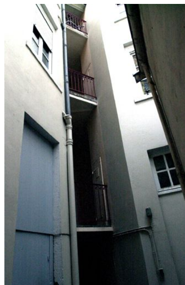
Vue de la cage d'escalier ouverte sur la cour Phot. Maryannick Chalabi IVR82_20016900115NUCA
