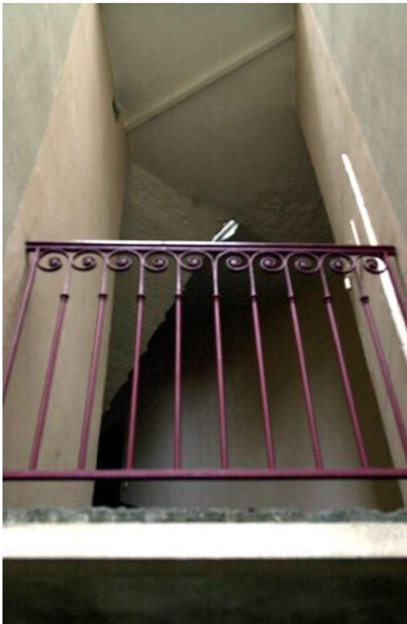
Détail du garde-corps de la cage d'escalier
