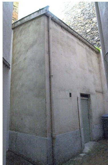
Vue de la loge de concierge, dans la cour Phot. Maryannick Chalabi IVR82_20016900117NUCA
