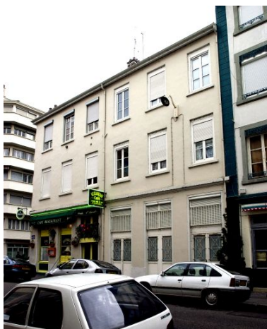
Elévation rue Marc-Antoine-Petit depuis le sud-est Phot. Maryannick Chalabi IVR82_20016900052NUCA
