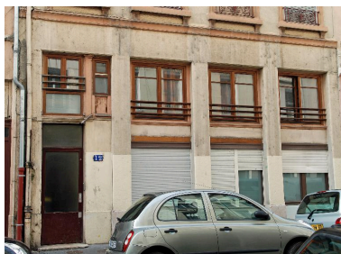
Elévation sur rue : rez-de-chaussée et entresol Phot. Magali Delavenne IVR82_20146902873NUCA
