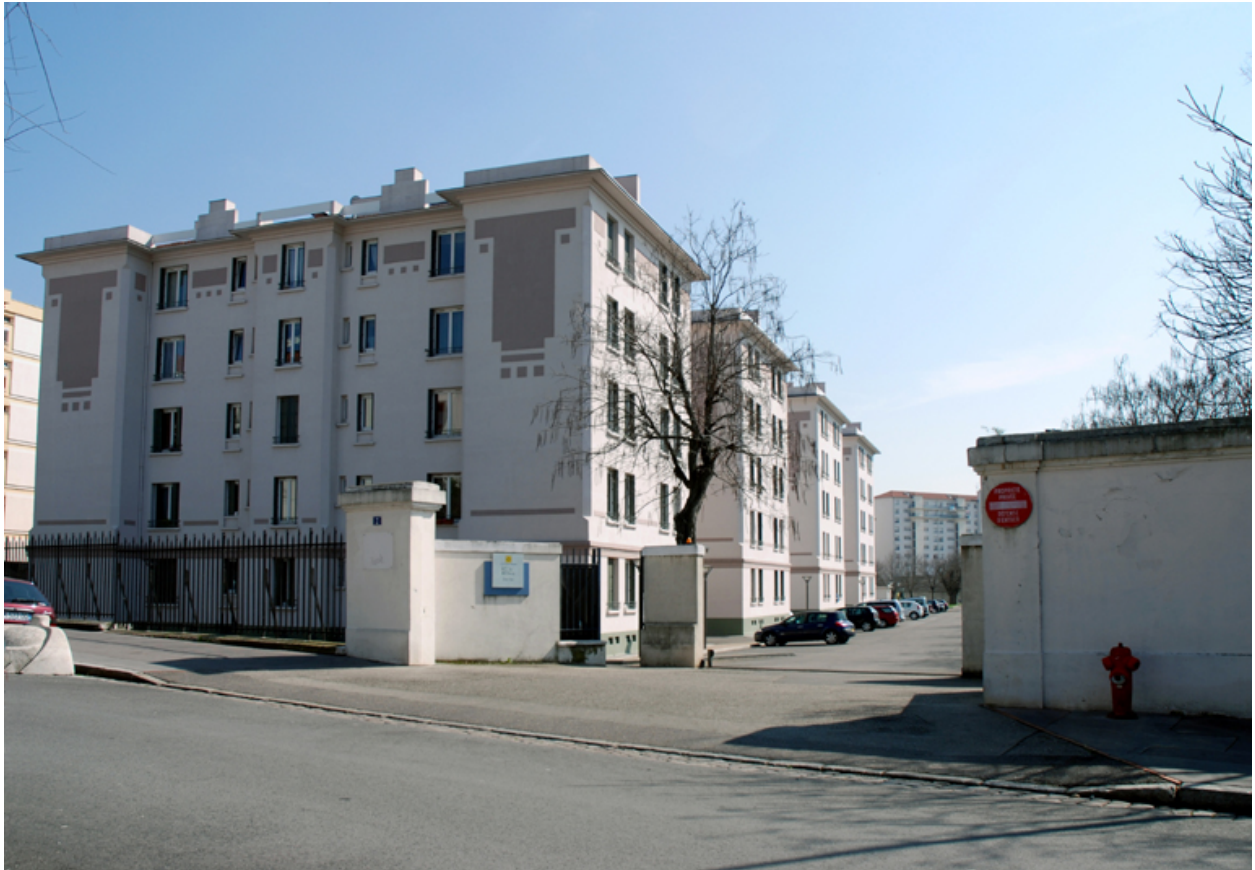
Vue générale depuis l'entrée de la Résidence
