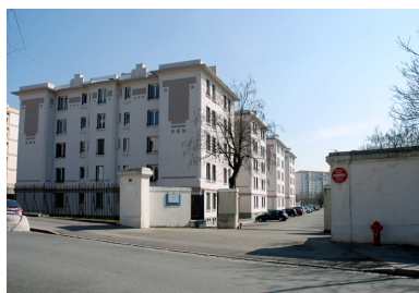
Vue générale depuis l'entrée de la Résidence Phot. Catherine Guégan IVR82_20126902471NUCA
