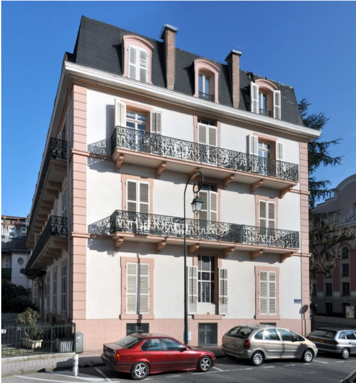
Façade latérale droite
