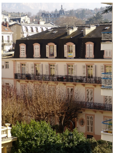
Façade nord, détail Phot. François Fouger IVR82_20097300070NUCA
