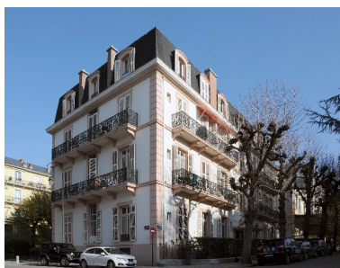
Vue de trois-quart depuis le sud-ouest Phot. François Fouger IVR82_20127300137NUCA
