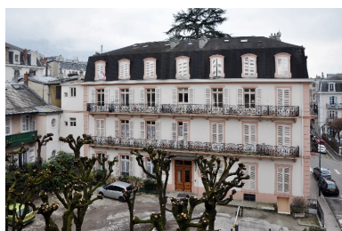
Façade nord Phot. François Fouger IVR82_20107300972NUCA
