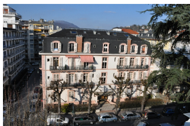
Façade sud Phot. François Fouger IVR82_20127300136NUCA
