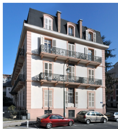
Façade latérale droite Phot. François Fouger IVR82_20107300973NUCA
