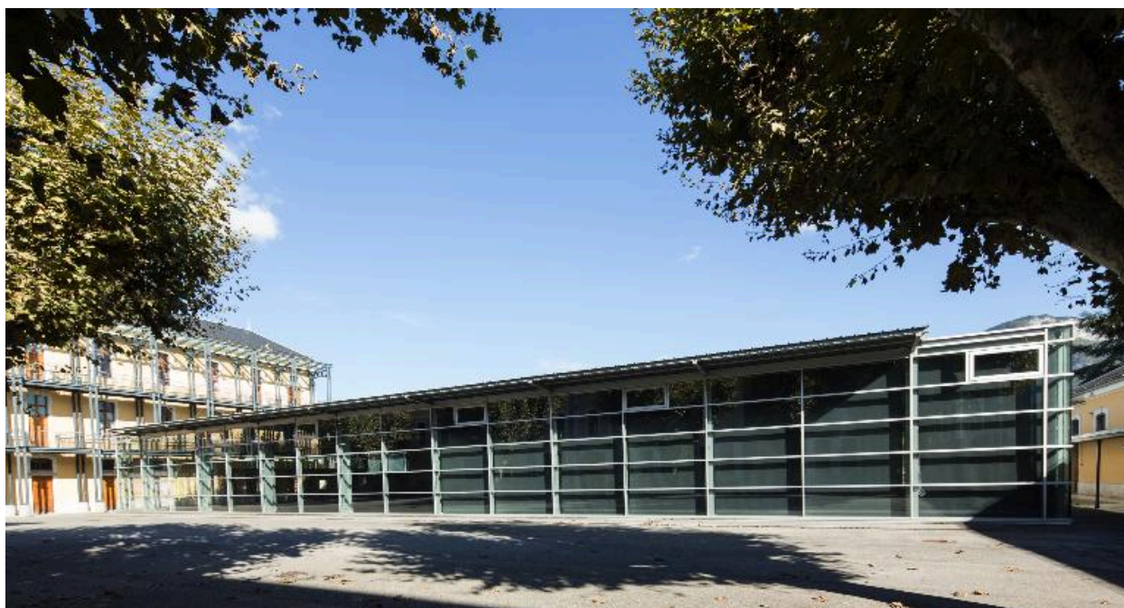
Façade sur cour 1.
