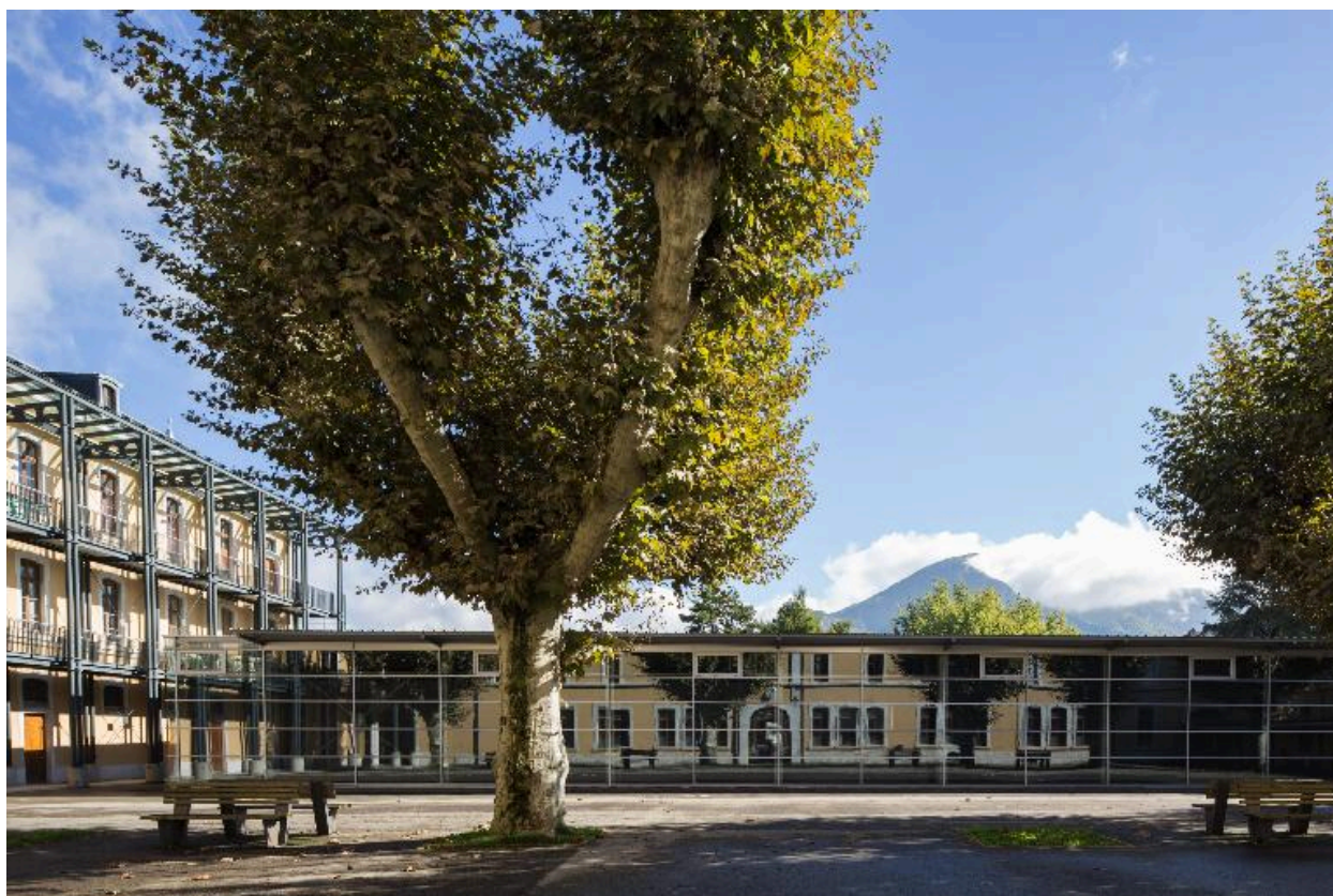
Façade sur cour 1.
