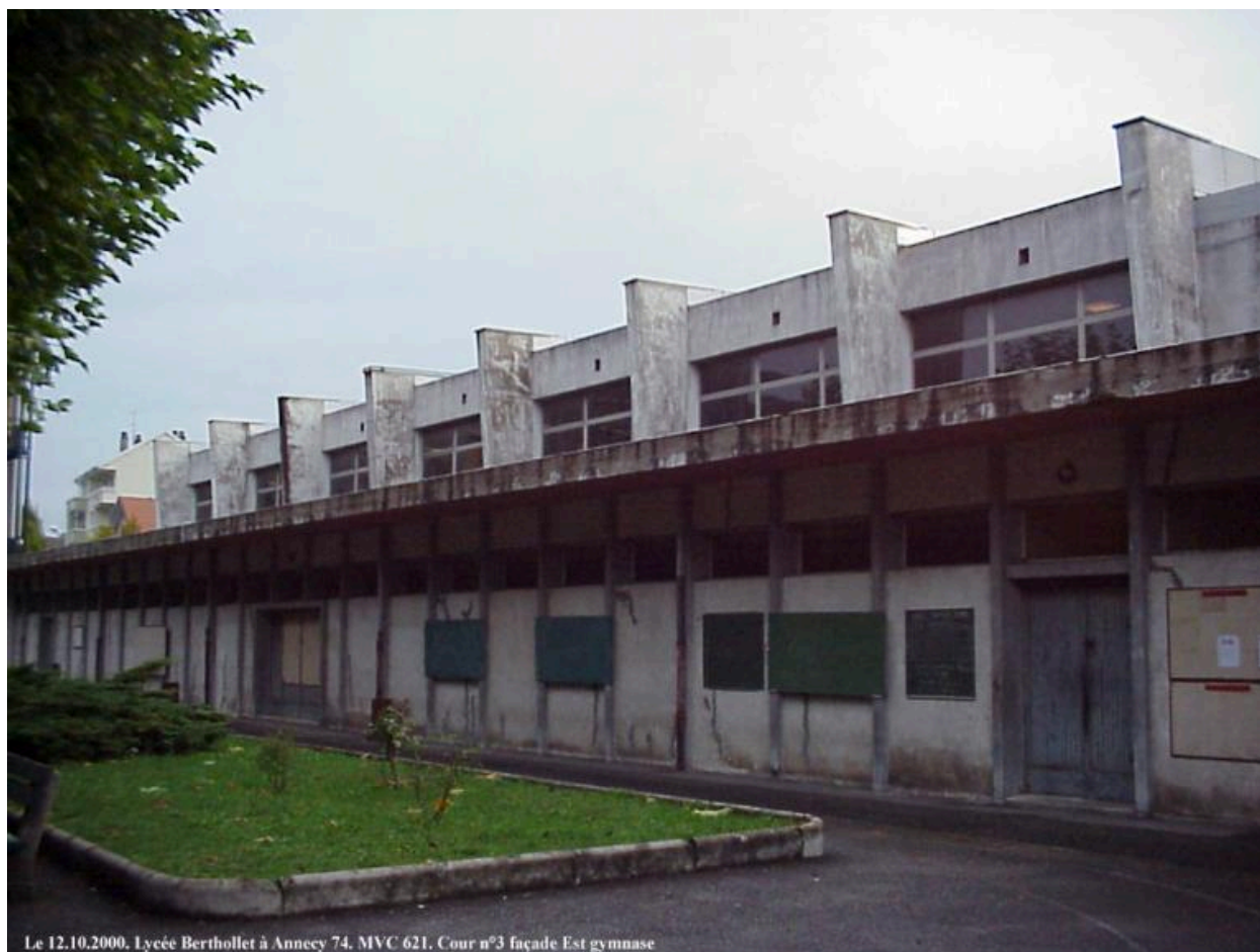
État en 2000 : façade sur cour
