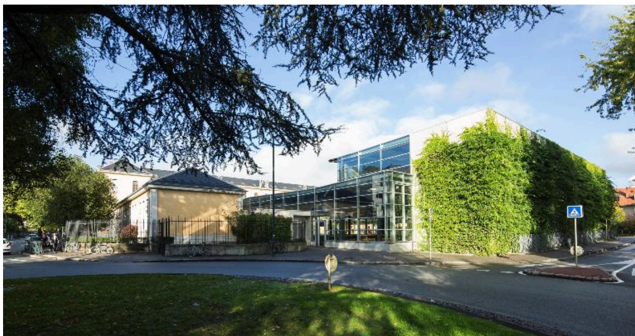
Façade végétalisée sur boulevard Taine.
