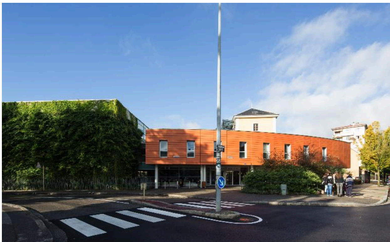
Façade principale sur boulevard Taine.
