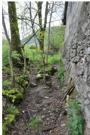
Vue du passage du bief, façade est. Phot. Clara Bérelle IVR82_20137301931NUCA
