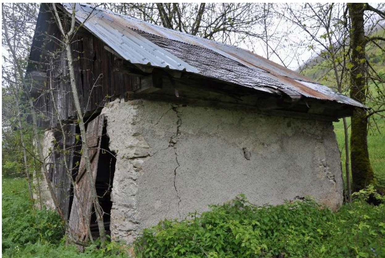
Façade sud du moulin.
