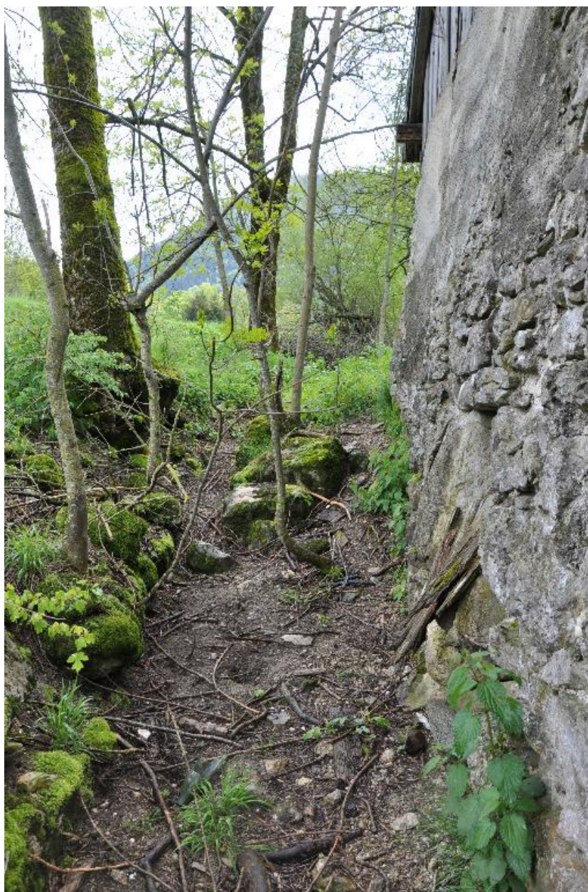
Vue du passage du bief, façade est.
