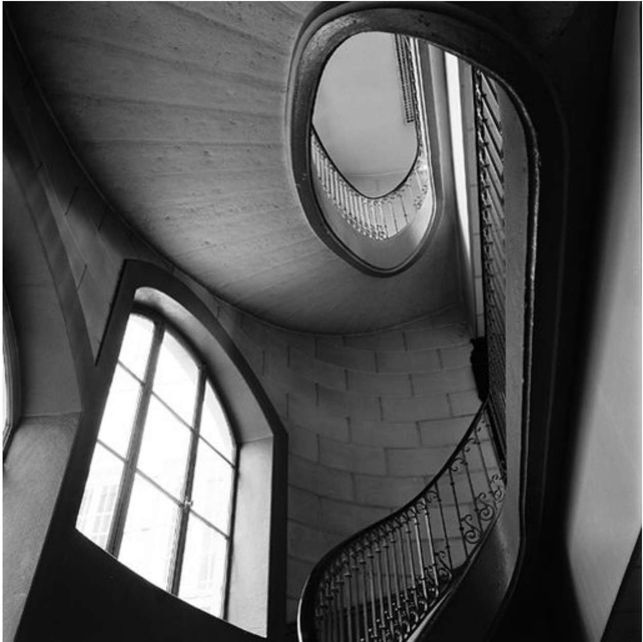
Escalier vu depuis le palier du 3e étage
