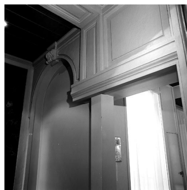
Vestibule du rez-de-chaussée, détail du mur sud Phot. Didier Gourbin IVR82_20036902060X
