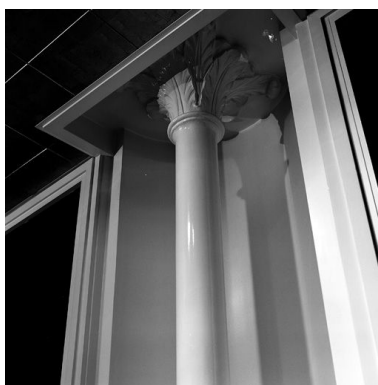
Rez-de-chaussée, partie sud, détail d'une colonne de soutien Phot. Didier Gourbin IVR82_20036902061X
