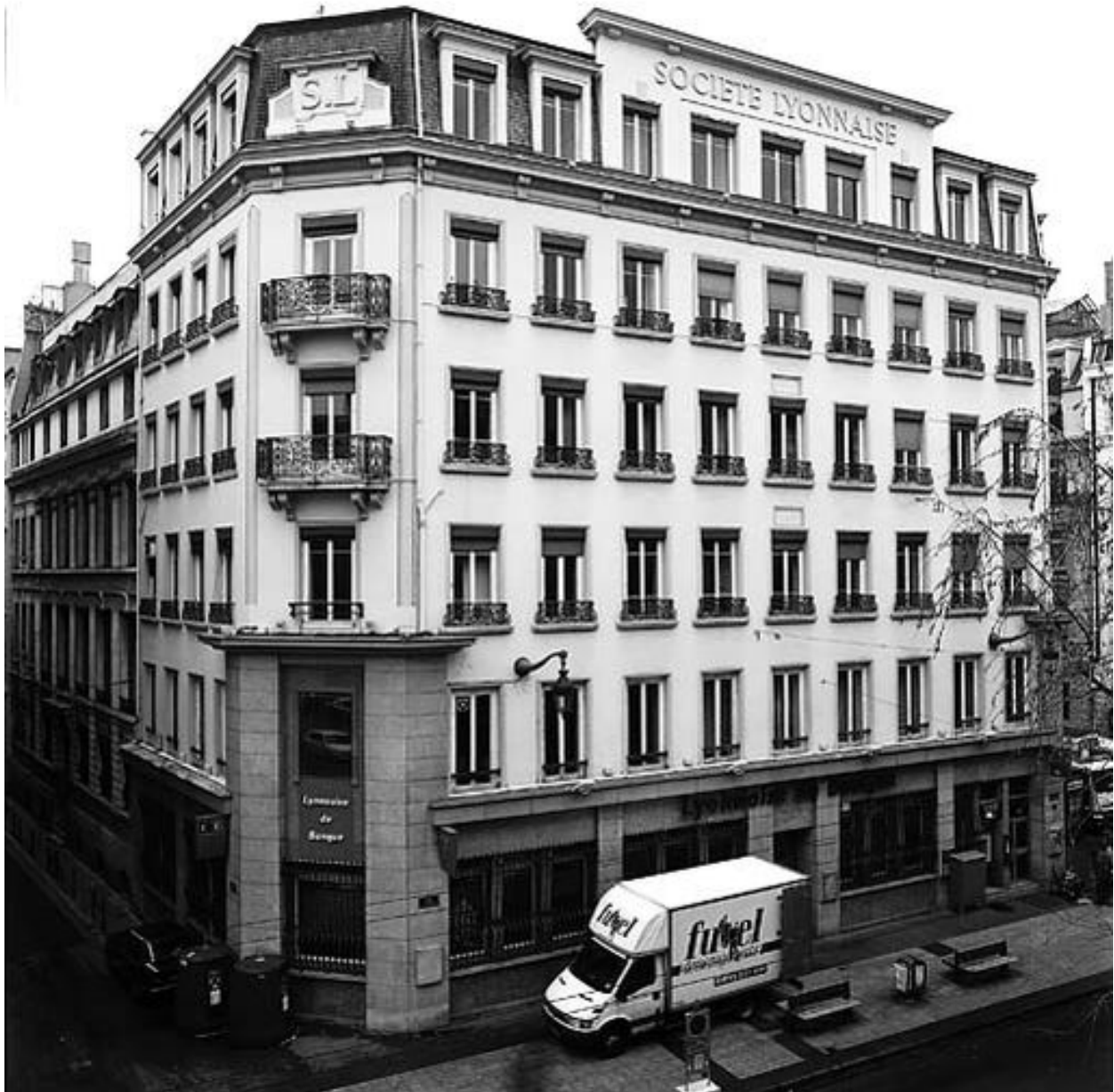
Vue générale des façades sur la rue Mulet (à gauche) et sur la rue de la République (à droite)
