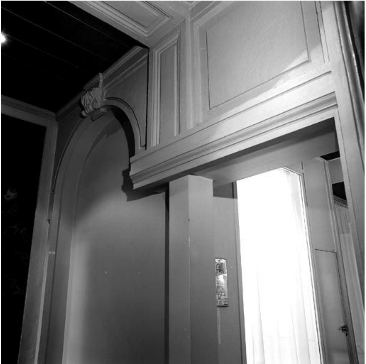
Vestibule du rez-de-chaussée, détail du mur sud
