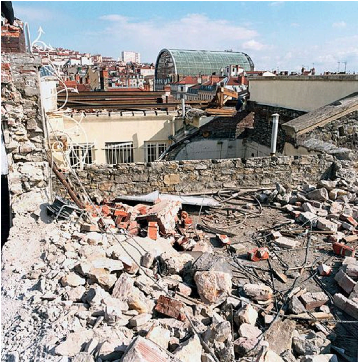
Toit en cours de démolition, avril 2004
