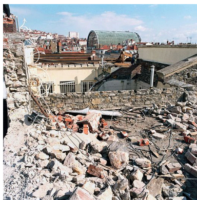
Toit en cours de démolition, avril 2004 Phot. Didier Gourbin IVR82_20046901546XE
