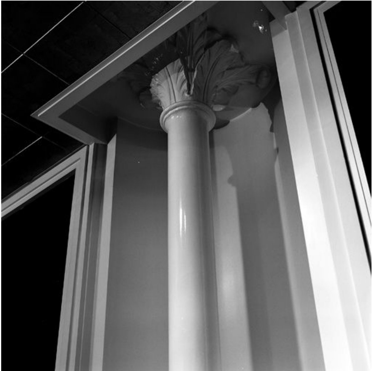
Rez-de-chaussée, partie sud, détail d'une colonne de soutien
