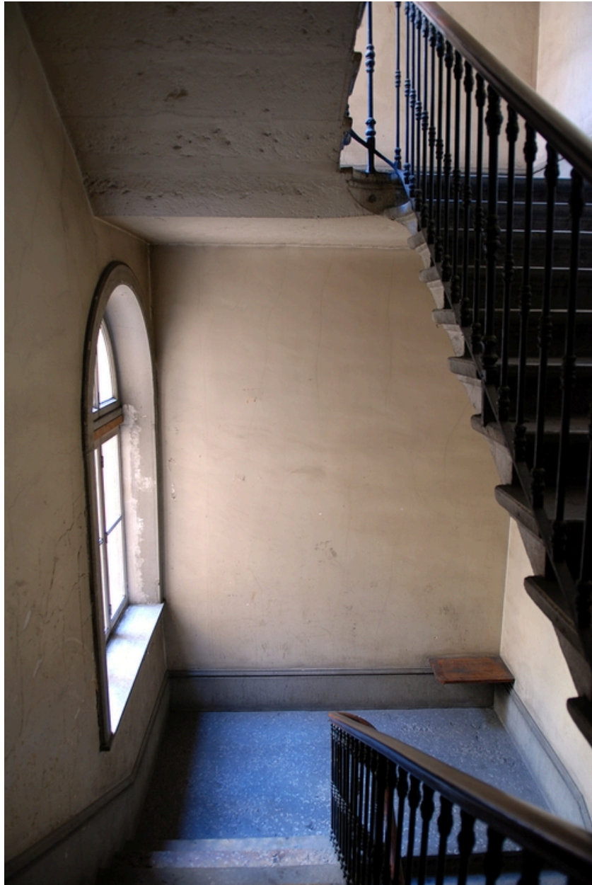
L'escalier : repos éclairé par la fenêtre ouvrant sur la cour
