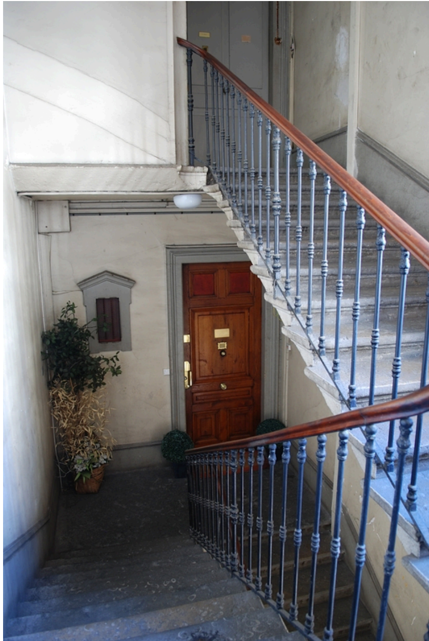
L'escalier : porte palière et fenêtre de second jour
