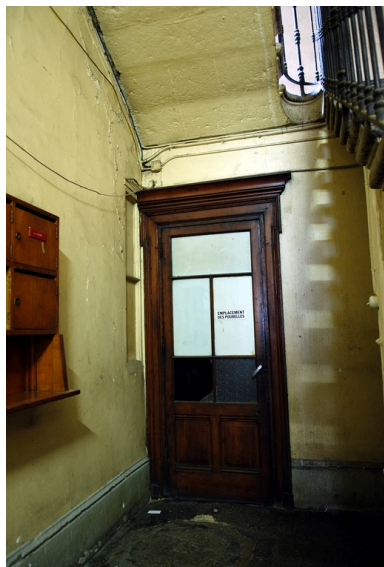
L'allée : porte et fenêtre de second jour de l'ancienne loge de concierge ? Phot. Véronique Belle IVR82_20096904726NUCA
