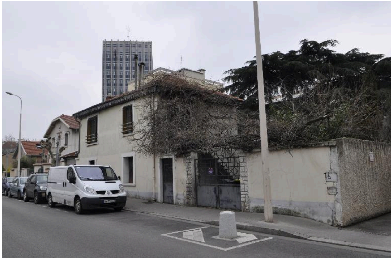
Vue générale depuis le sud
