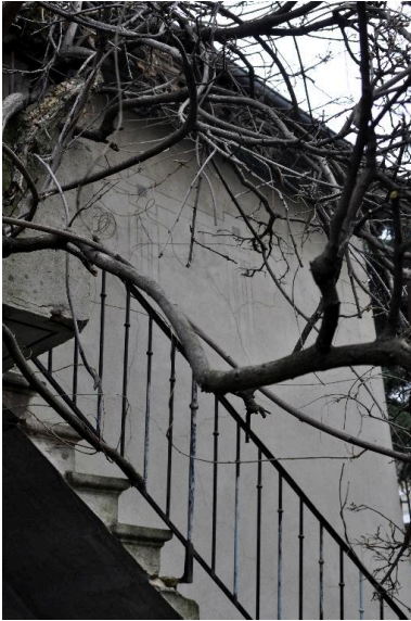
Détail de l'ancien décor peint sur enduit Phot. Catherine Guégan IVR82_20136900304NUCA
