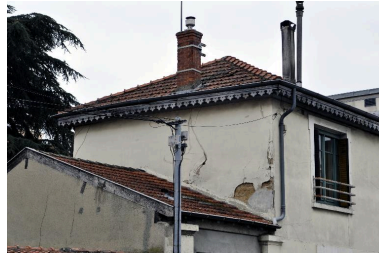
Détail de l'élévation latérale nord : lambrequins en bois sur la rive du toit, maçonnerie en pisé recouvert d'enduit Phot. Catherine Guégan IVR82_20136900306NUCA
