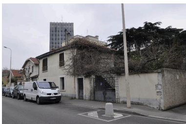
Vue générale depuis le sud Phot. Catherine Guégan IVR82_20136900301NUCA
