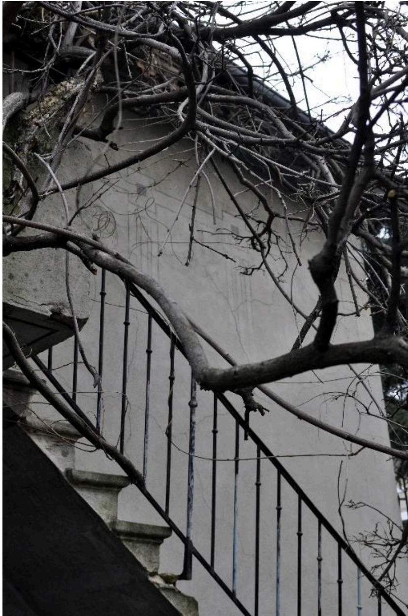
Détail de l'ancien décor peint sur enduit
