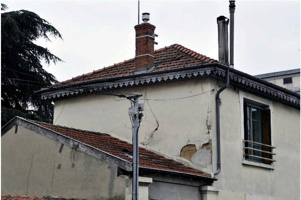
Détail de l'élévation latérale nord : lambrequins en bois sur la rive du toit, maçonnerie en pisé recouvert d'enduit
