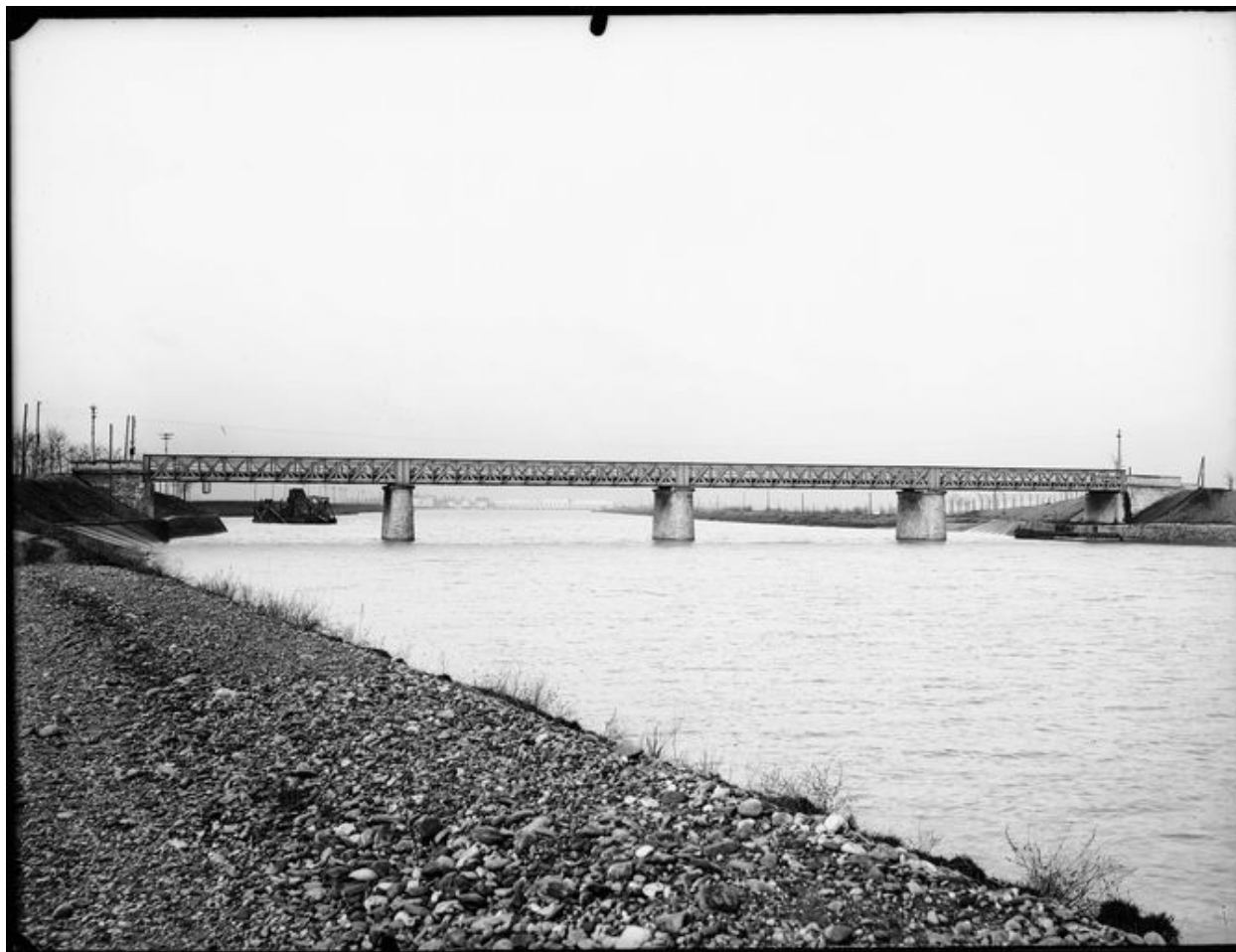
[Pont de la Sucrierie, vue d'ensemble, amont. Canal de Jonage et central hydroélectrique de Cusset]. [03/1908]. 1 photogr. : plaque de verre, n. et b. (AD Rhône. 156 J 401, n°219)
