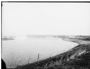
[Pont de la Sucrierie et barrage provisoire pour la mise en eau du canal, vue d'aval. Canal de Jonage et central hydroélectrique de Cusset]. [22/12/1898]. 1 fotogr. : plaque de verre, n. et b. (AD Rhône. 156 J 398, n°148) Phot. AD Rhône, Autr. auteur inconnu 1_ IVR82_20106902645NUCAB
