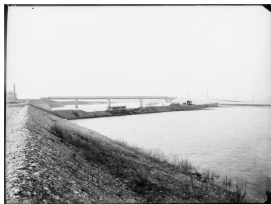
[Pont de la Sucrierie et barrage provisoire pour la mise en eau du canal, vue d'amont. Canal de Jonage et central hydroélectrique de Cusset]. [22/12/1898]. 1 fotogr. : plaque de verre, n. et b. (AD Rhône. 156 J 398, n°147) Phot. AD Rhône, Autr. auteur inconnu 1_ IVR82_20106902644NUCAB
