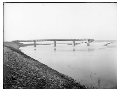
[Pont de la Sucrierie, vue d'amont, au fond l'usine-barrage de Cusset. Canal de Jonage et central hydroélectrique de Cusset]. [22/12/1898]. 1 fotogr. : plaque de verre, n. et b. (AD Rhône. 156 J 398, n°149) Phot. AD Rhône, Autr. auteur inconnu 1_ IVR82_20106902646NUCAB
