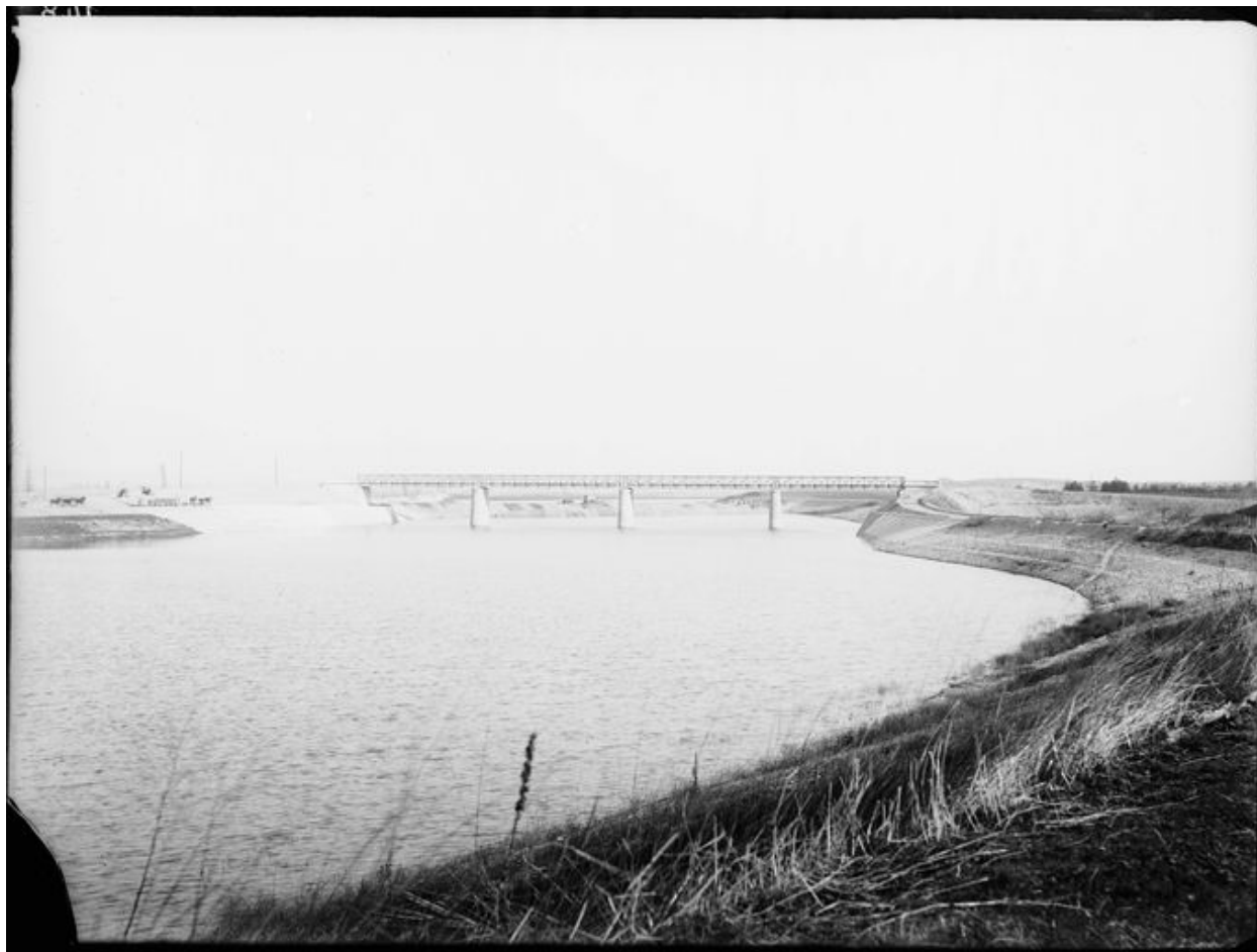
[Pont de la Sucrierie et barrage provisoire pour la mise en eau du canal, vue d'aval. Canal de Jonage et central hydroélectrique de Cusset]. [22/12/1898]. 1 fotogr. : plaque de verre, n. et b. (AD Rhône. 156 J 398, n°148)
