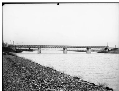
[Pont de la Sucrierie, vue d'ensemble, amont. Canal de Jonage et central hydroélectrique de Cusset]. [03/1908]. 1 fotogr. : plaque de verre, n. et b. (AD Rhône. 156 J 401, n°219) Phot. AD Rhône, Autr. auteur inconnu 1_ IVR82_20106902647NUCAB
