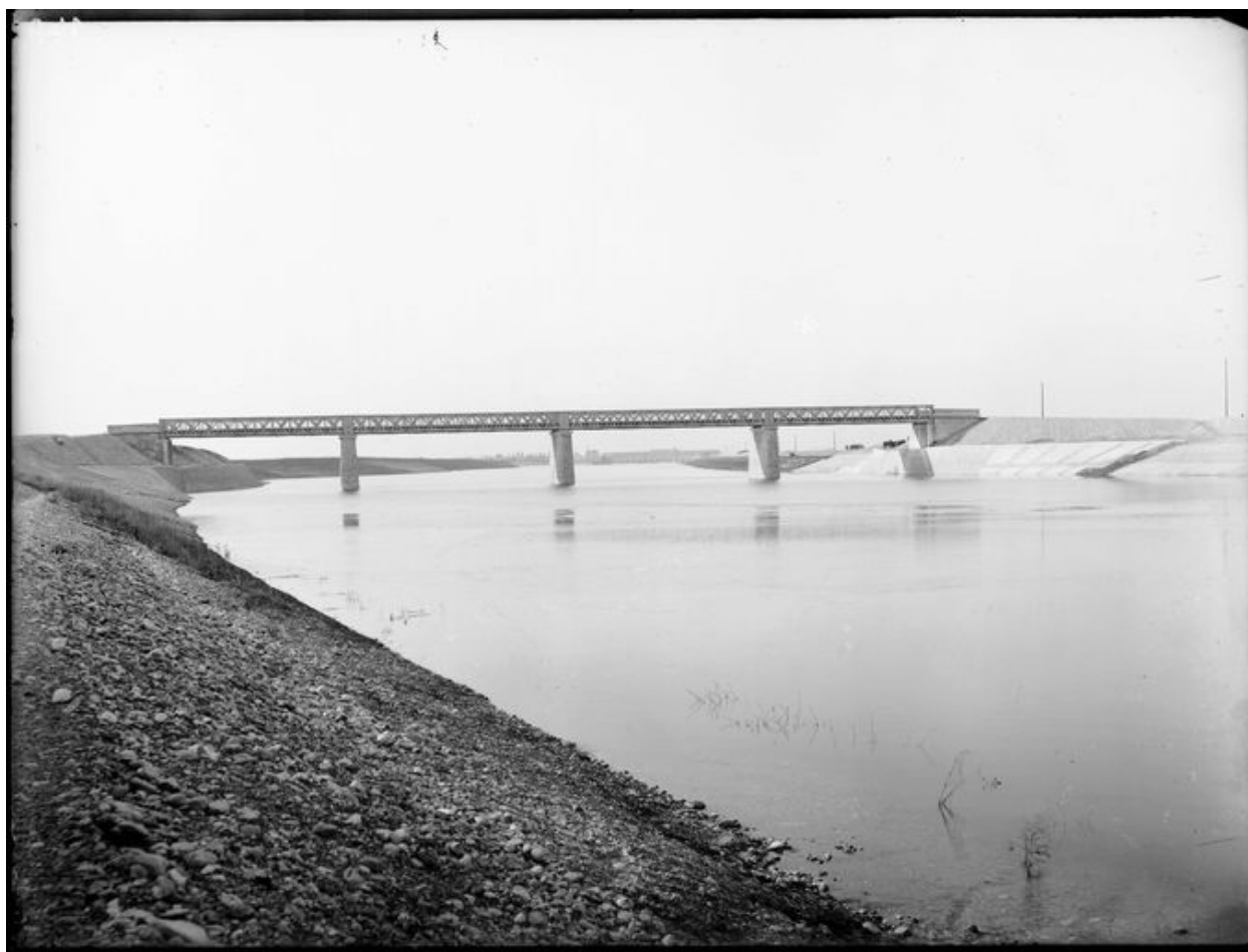
[Pont de la Sucrierie, vue d'amont, au fond l'usine-barrage de Cusset. Canal de Jonage et central hydroélectrique de Cusset]. [22/12/1898]. 1 fotogr. : plaque de verre, n. et b. (AD Rhône. 156 J 398, n°149)
