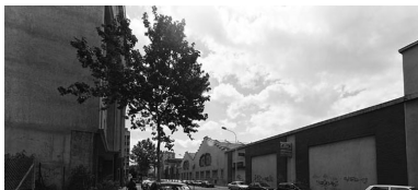
Vue sud Phot. Martial Couderette IVR82_20006900964V
