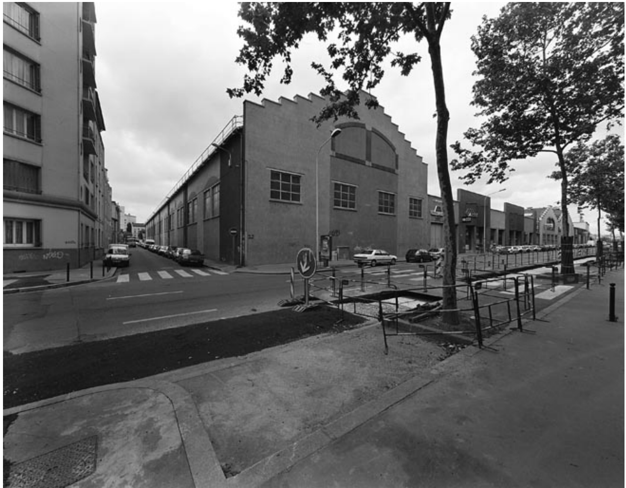
Vue générale de la grande halle angle rue Saint-Agan
