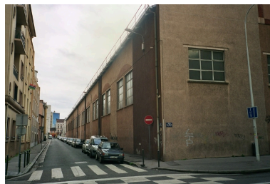
Façade rue Saint-Agan, vue nord Phot. Nadine Halitim-Dubois IVR82_20076900625NUCA
