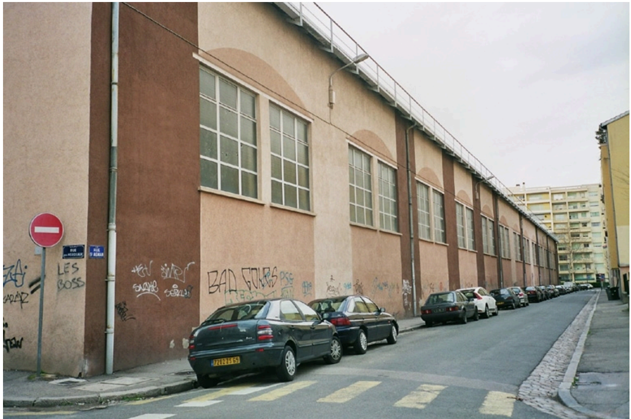
Façade rue Saint-Agan, vue sud
