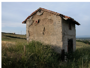
Loge de vigne à un étage, murs en pisé enduit (Champdieu, la Loge, IA42003069). Phot. Thierry Monnet IVR82_20134200751NUCA
