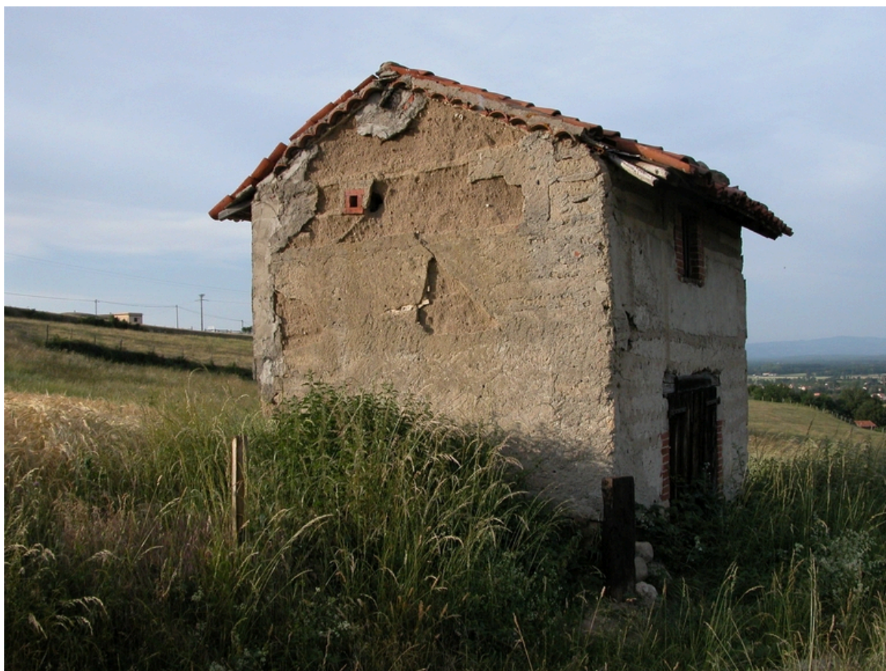
Loge de vigne à un étage, murs en pisé enduit (Champdieu, la Loge, IA42003069).
