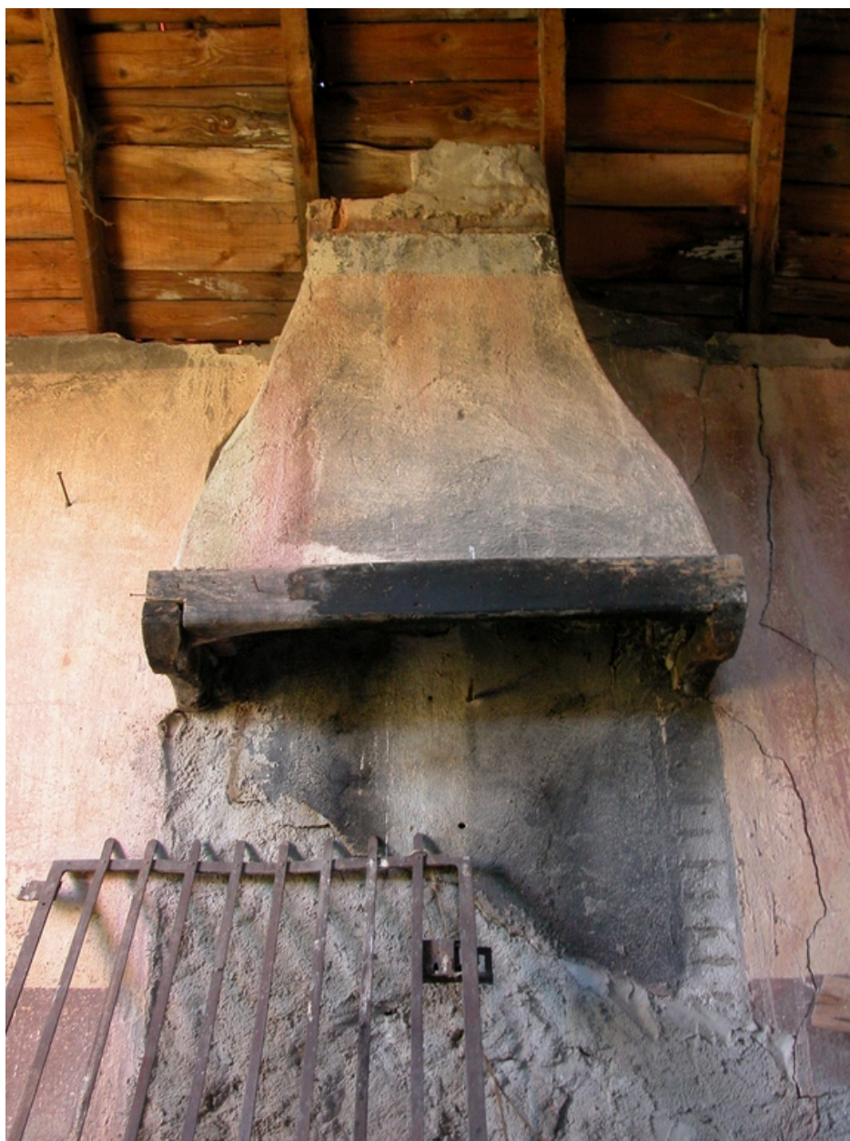
Loge de vigne, vue intérieure de l'étage : cheminée (Saint-Thomas-la-Garde, Croix Blanche, IA42002468).
