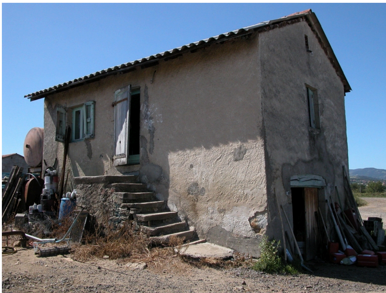
Loge de vigne à un étage, murs en pisé enduit (Saint-Thomas-la-Garde, la Croix Blanche, IA42002467). Rare exemple d'escalier extérieur.
