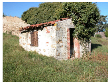
Loge de vigne en rez-de-chaussée, murs en granite enduit (Montbrison, Moingt ; Lunard, IA42002742). Phot. Thierry Monnet IVR82_20134200304NUCA
