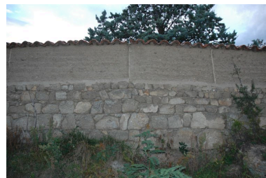
Mur de clos en pisé (Montbrison, Moingt, Sous Rigaud, AC 67a). Phot. Thierry Monnet IVR82_20134200386NUCA
