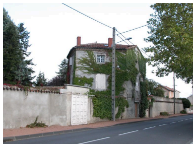
Cuvage transformé en habitation (?) (Montbrison, Moingt, les Puelles, 1986 AK 53).
