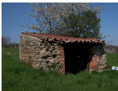
Loge de vigne en rez-de-chaussée, murs en granite (Lézigneux, les Goutasses, IA42002189). Phot. Thierry Monnet IVR82_20114202202NUCA
