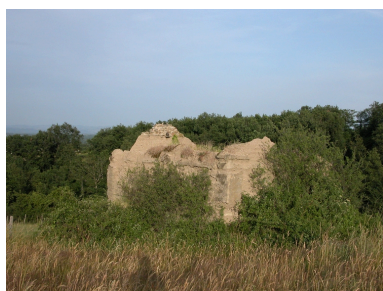
Loge de vigne en pisé en ruine (Champdieu, la Loge, IA42003068). Phot. Thierry Monnet IVR82_20134200752NUCA
