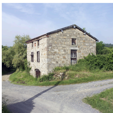
Montbrison Lieux-dits Moingt ; Cindrieux Informations cadastrales 1986 AS 57 IA42002771 Cuvage à Cindrieux, commune de Moingt (1986 AS 57 ; étudié, IA42002771). Phot. Didier Gourbin IVR82_20074201213NUCA
