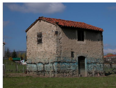
Loge de vigne à un étage, murs en pisé enduit (Écotay-l'Olme, Rigaud, IA42002810). Phot. Thierry Monnet IVR82_20124201755NUCA
