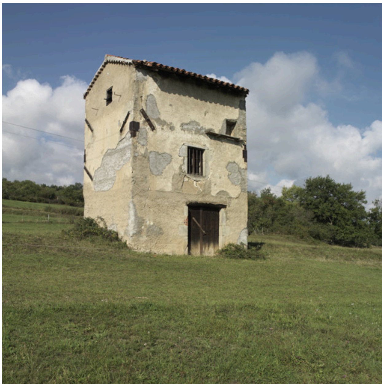
Loge de vigne à un étage et comble à surcroît aménagé en pigeonnier (Champdieu, les Bourrus, IA42003113).
