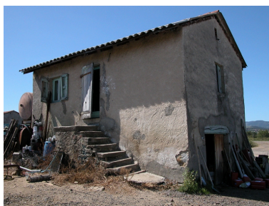
Loge de vigne à un étage, murs en pisé enduit (Saint-Thomas-la-Garde, la Croix Blanche, IA42002467). Rare exemple d'escalier extérieur. Phot. Thierry Monnet IVR82_20124201559NUCA
