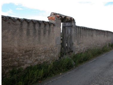
Mur de clôture (Montbrison, Moingt, vers Saintinieux, AR 85 ?) Phot. Thierry Monnet IVR82_20134200376NUCA
