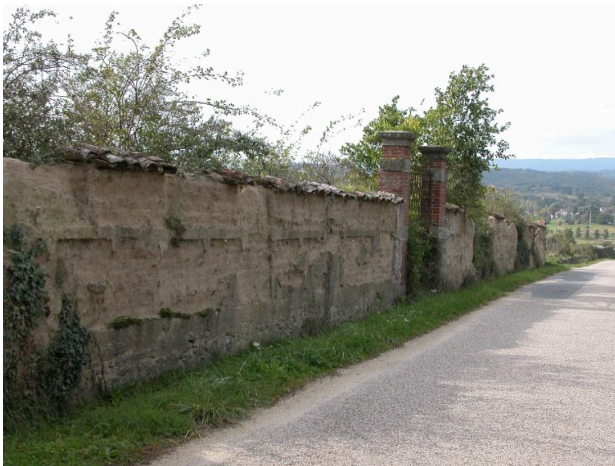
Vue d'un clos et de son portail (Montbrison, Moingt, Sous Montagneux, AR 231).
