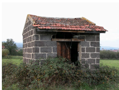
Loge de vigne en rez-de-chaussée, murs en parpaing de mâchefer (Montbrison, Moingt ; la Cassandre, IA42002726). Phot. Thierry Monnet IVR82_20134200281NUCA
