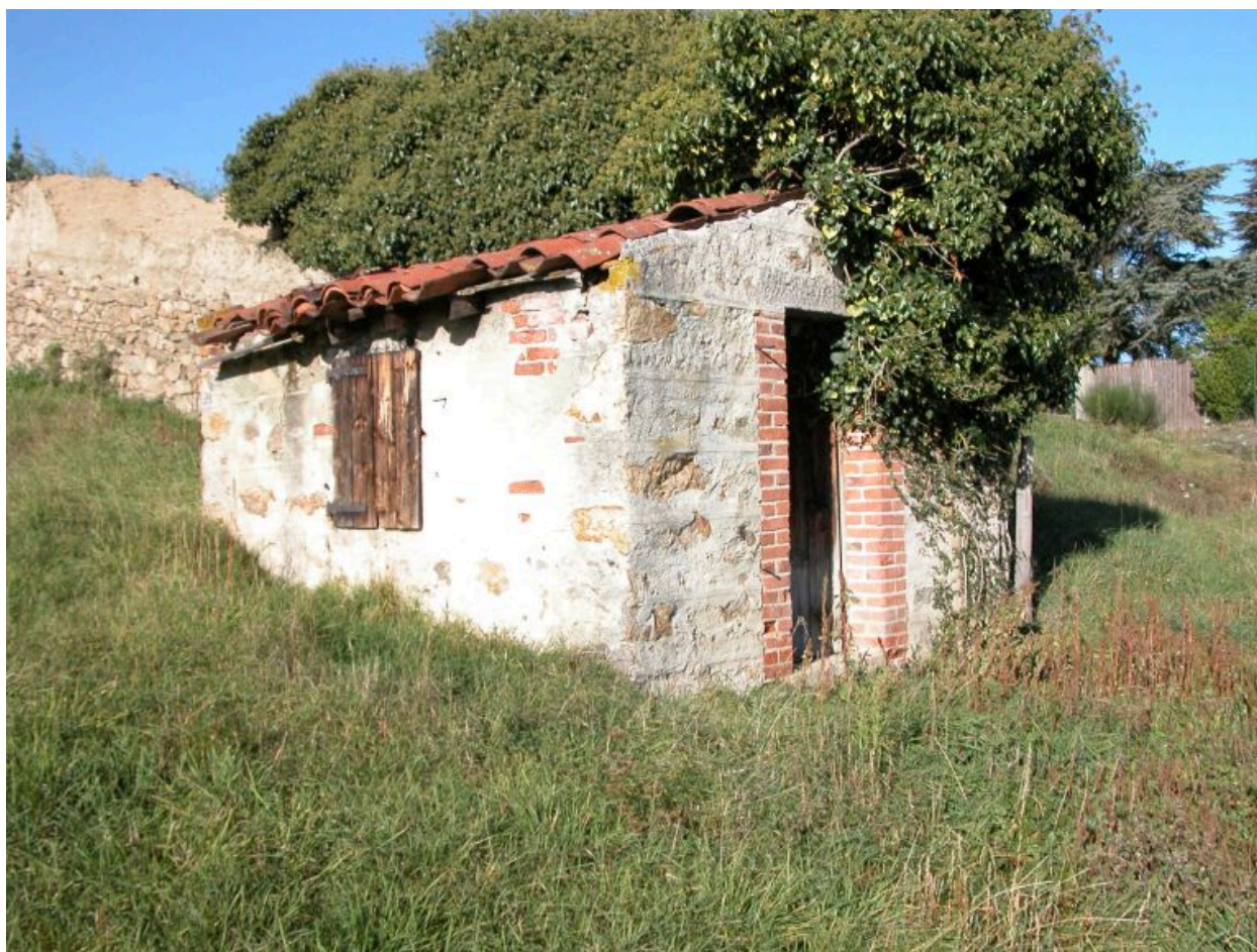
Loge de vigne en rez-de-chaussée, murs en granite enduit (Montbrison, Moingt ; Lunard, IA42002742).
