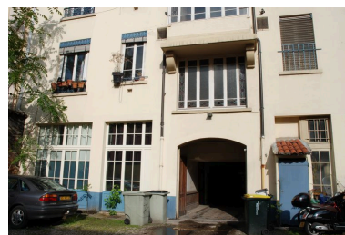
Détail du revers : vue partielle du rez-de-chaussée Phot. Catherine Guillot IVR82_20126900978NUCA
