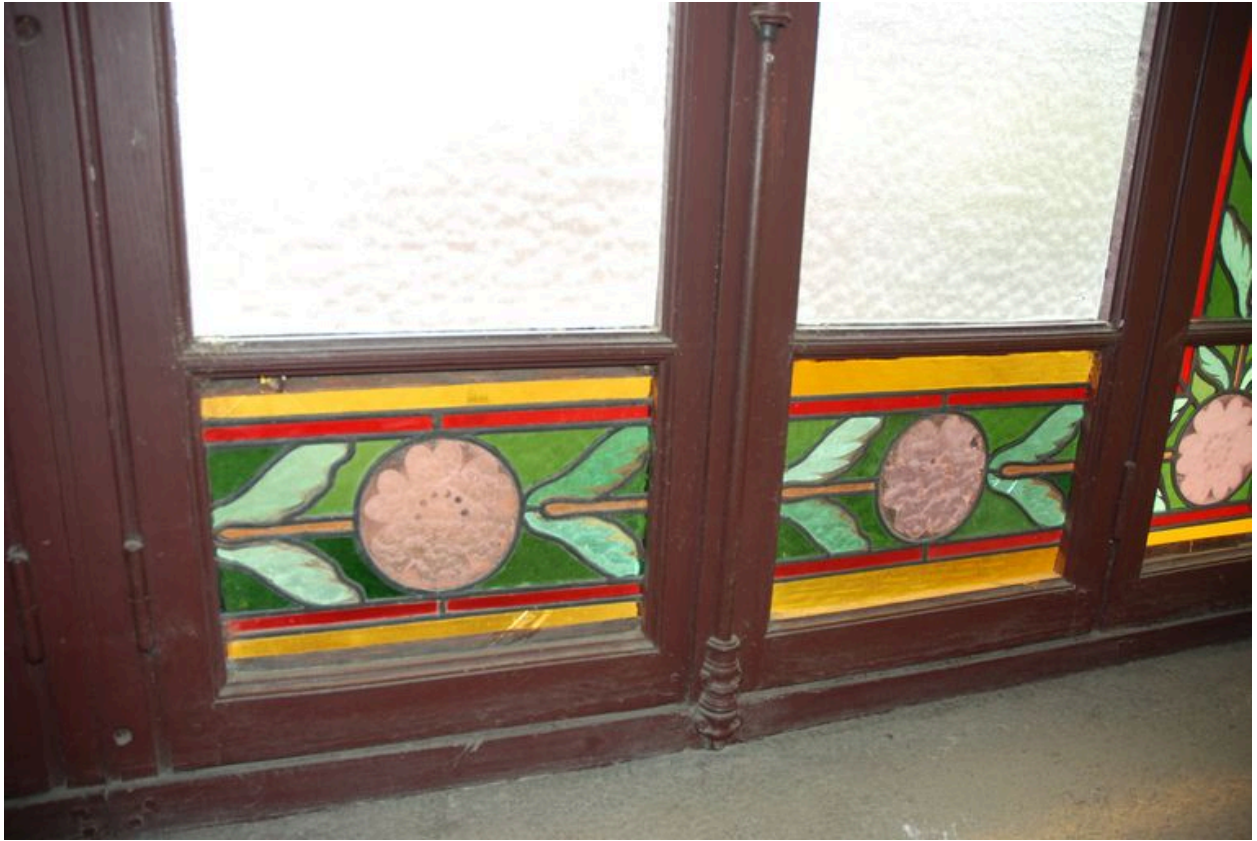
Détail d'une verrière dans la cage d'escalier
