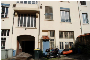
Détail du revers : vue partielle du rez-de-chaussée Phot. Catherine Guillot IVR82_20126900979NUCA
