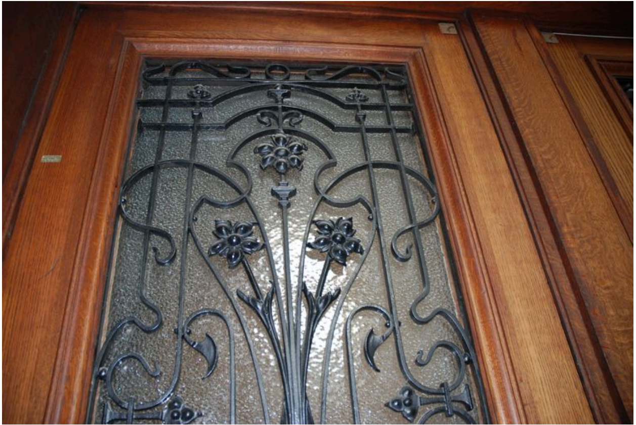
Détail de ferronnerie des portes palières
