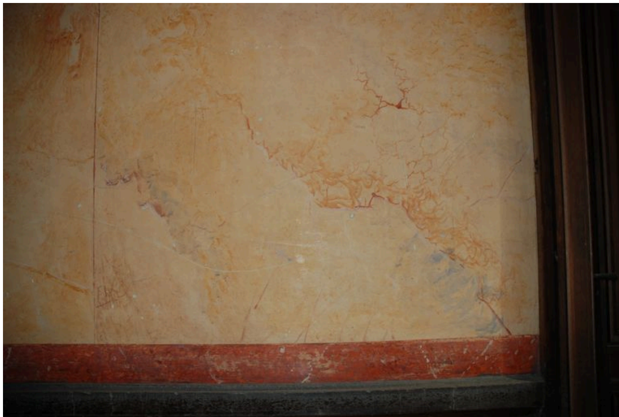
Détail du décor faux marbre, dans le passage cocher
