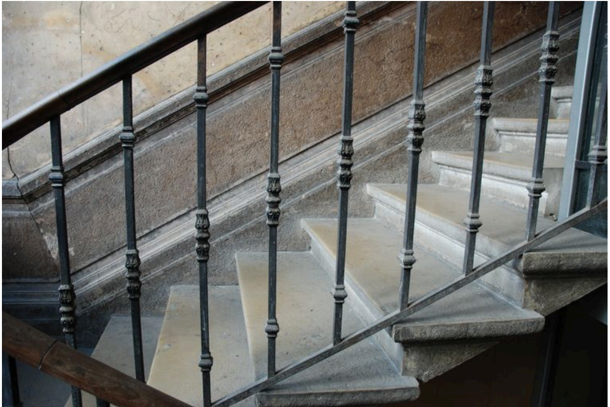
Détail de l'escalier
