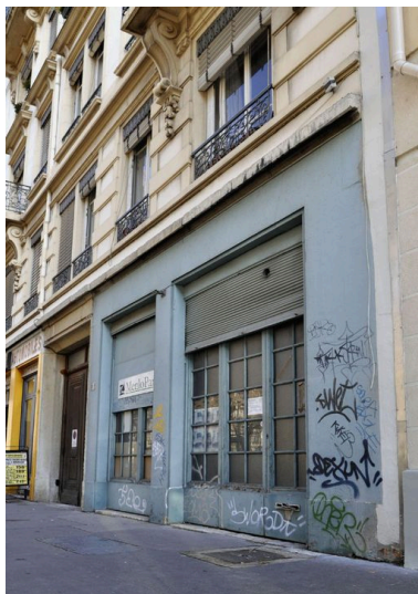
Détail de la façade en 2010 : l'ancien local commercial, avant transformation en logement Phot. Julien Defillon IVR82_20106900804NUCA
