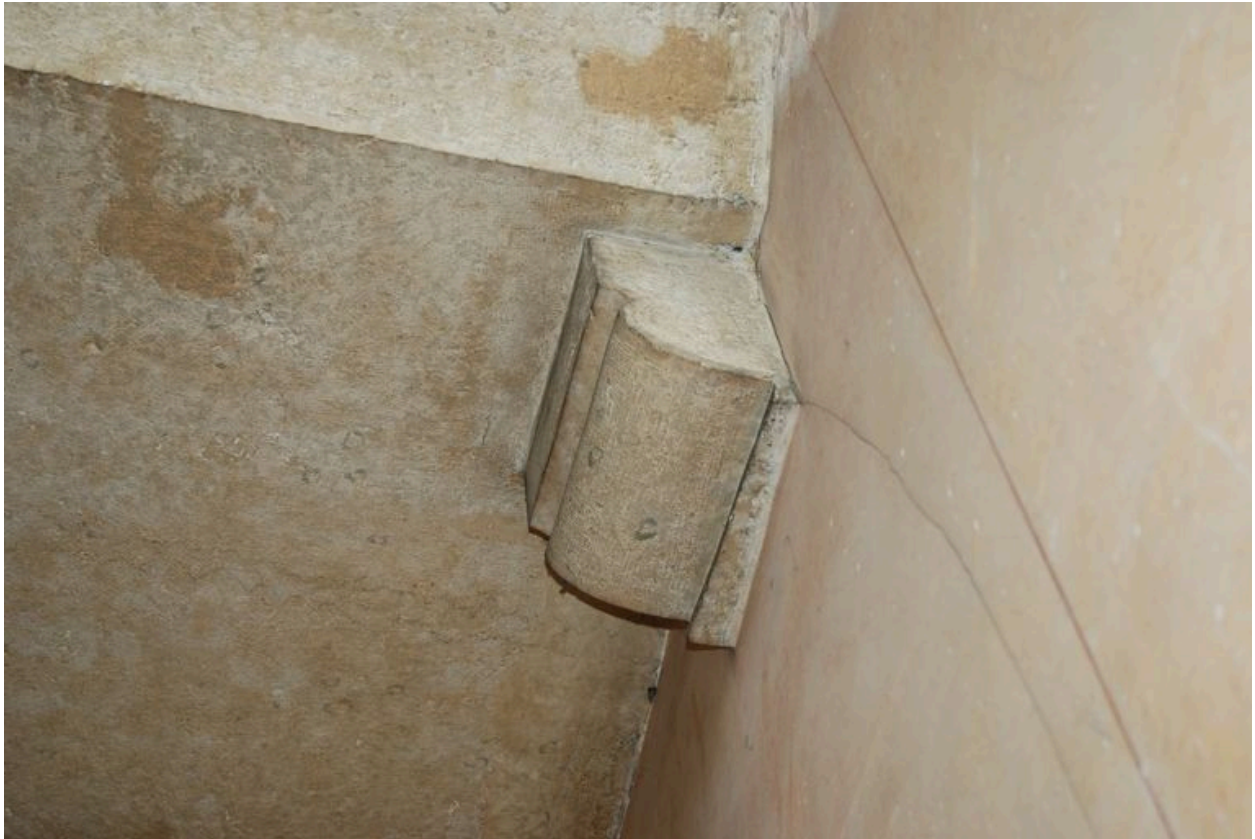
Détail d'une console dans la cage d'escalier
