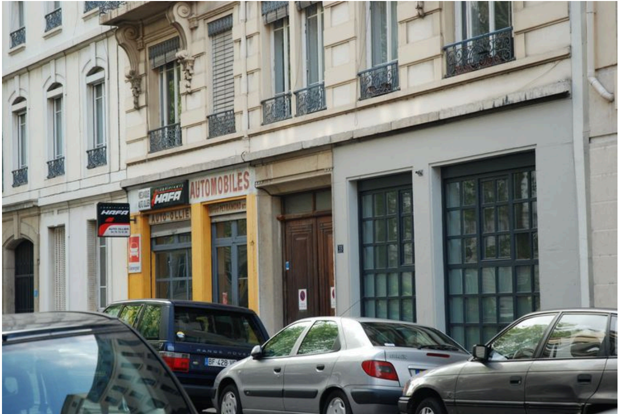
Vue du rez-de-chaussée, après transformation
