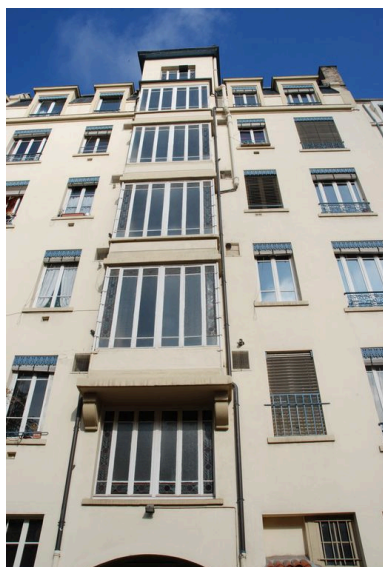
Vue du revers, avec la cage d'escalier vitrée Phot. Catherine Guillot IVR82_20126900976NUCA
