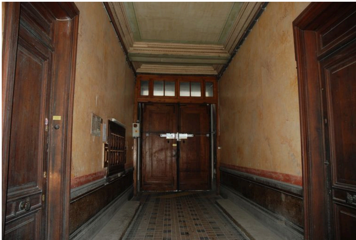
Vue du passage couvert, en direction de la rue
