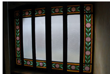
Vue d'une verrière dans la cage d'escalier Phot. Catherine Guillot IVR82_20126900984NUCA
