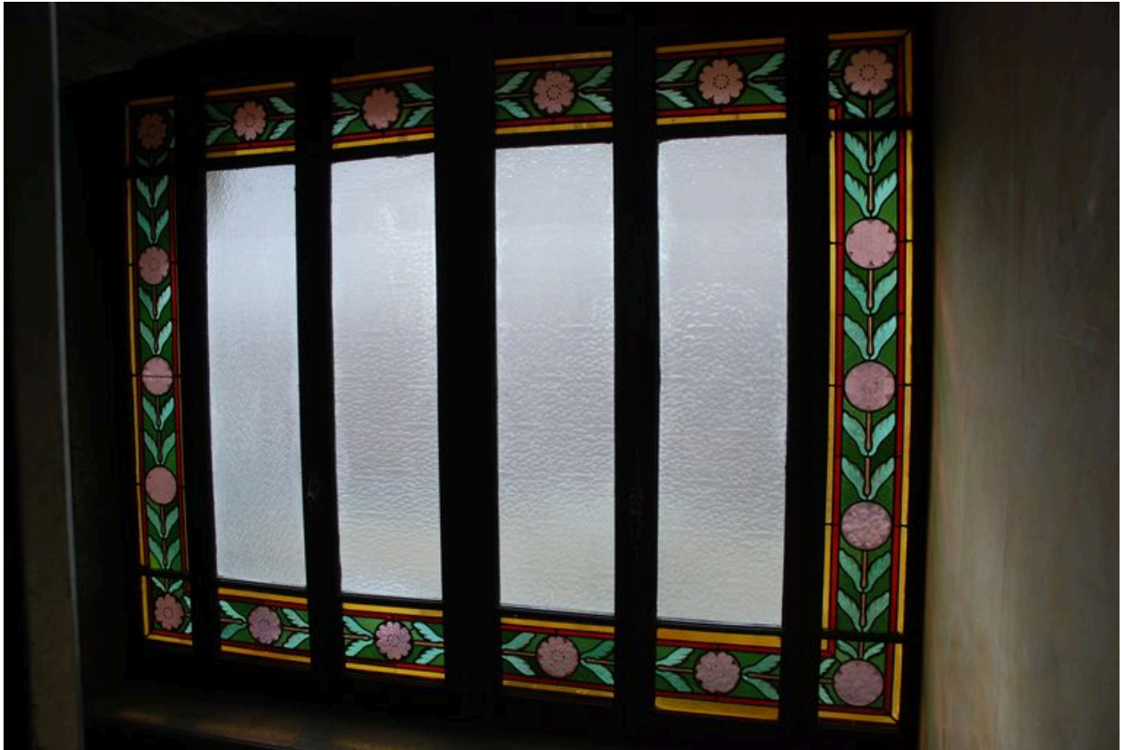
Vue d'une verrière dans la cage d'escalier
