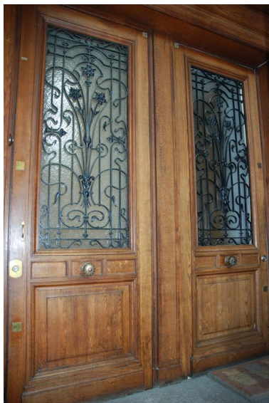
Vue des portes palières Phot. Catherine Guillot IVR82_20126900986NUCA
