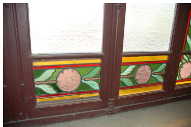
Détail d'une verrière dans la cage d'escalier Phot. Catherine Guillot IVR82_20126900985NUCA
