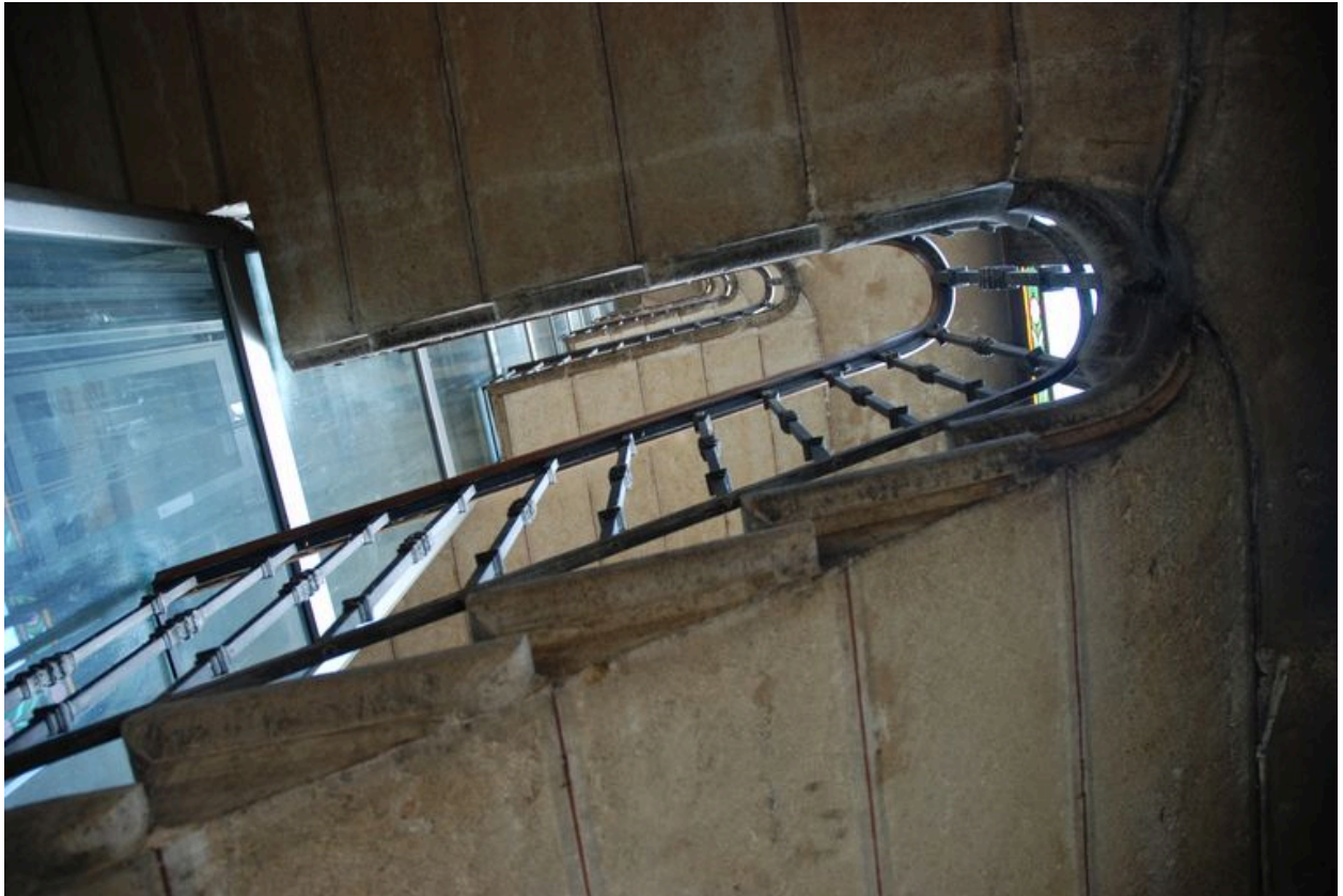
Vue de la cage d'escalier
