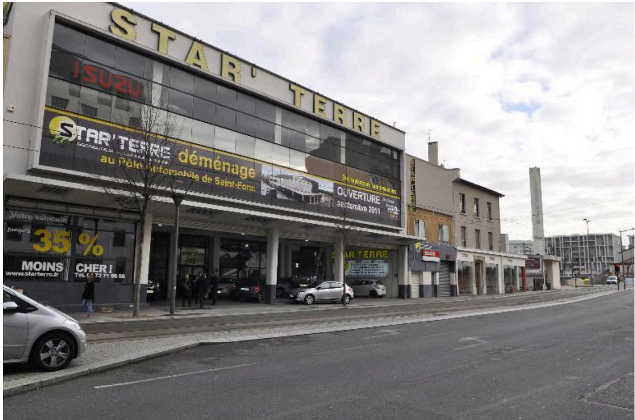
Vue d'ensemble ouest du garage avenue Berthelot
