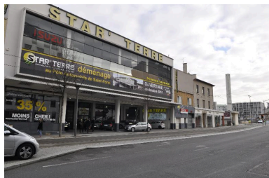
Vue d'ensemble ouest du garage avenue Berthelot Phot. Nadine Halitim-Dubois IVR82_20126900008NUCA
