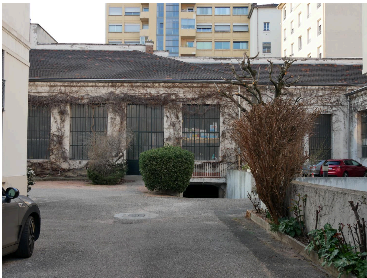
Entrepôts sur cour
