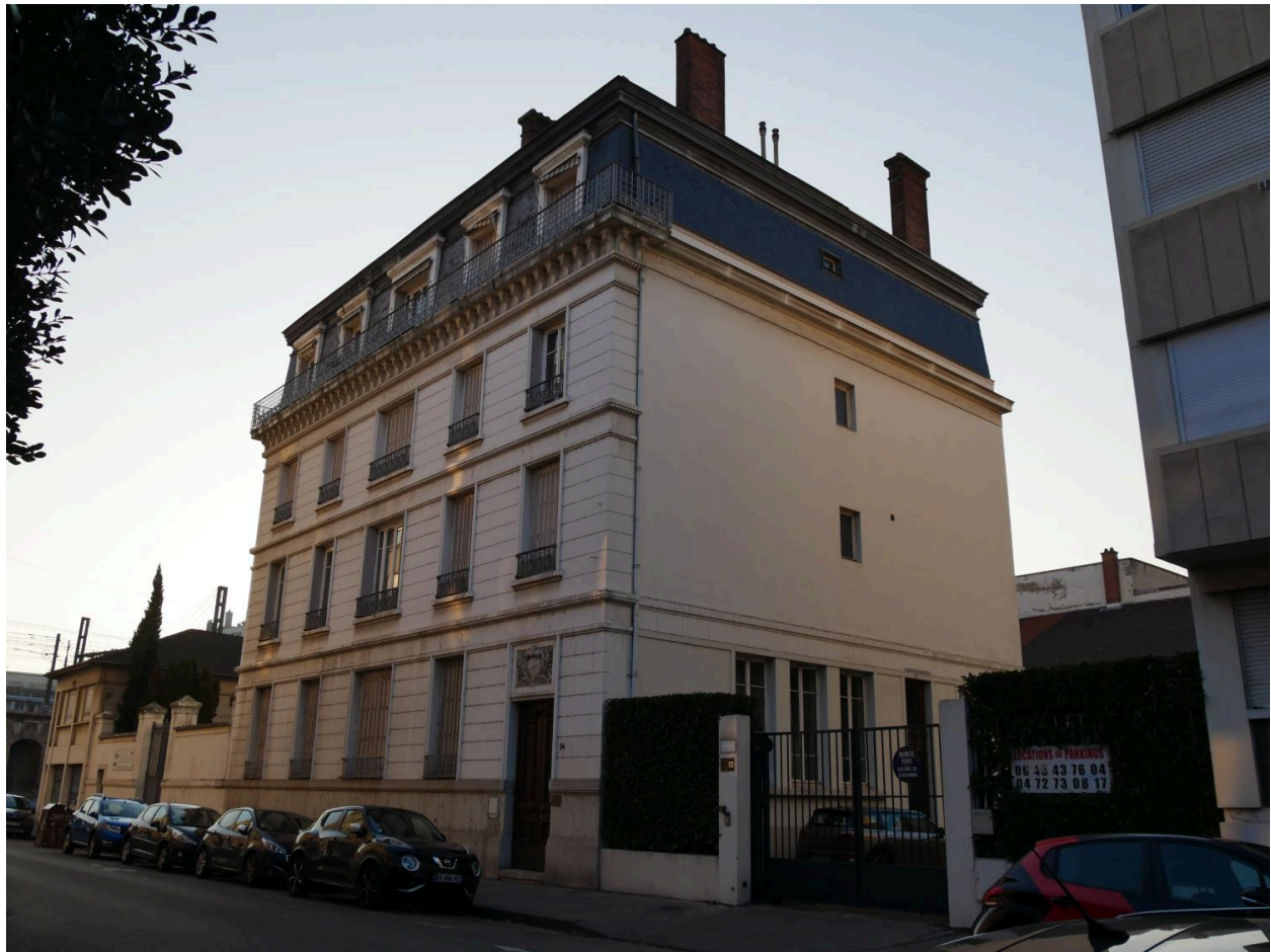
Vue d'ensemble nord-est du site dont la partie habitation.
