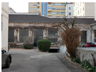
Entrepôts sur cour Phot. Nadine Halitim-Dubois IVR84_20226901523NUCA
