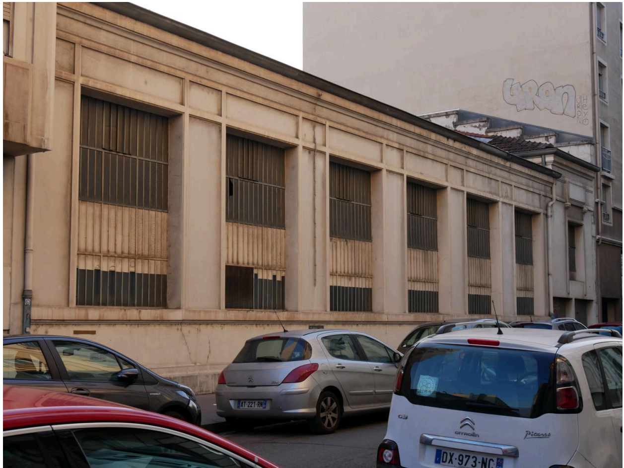
façade nord rue Etienne Rognon
